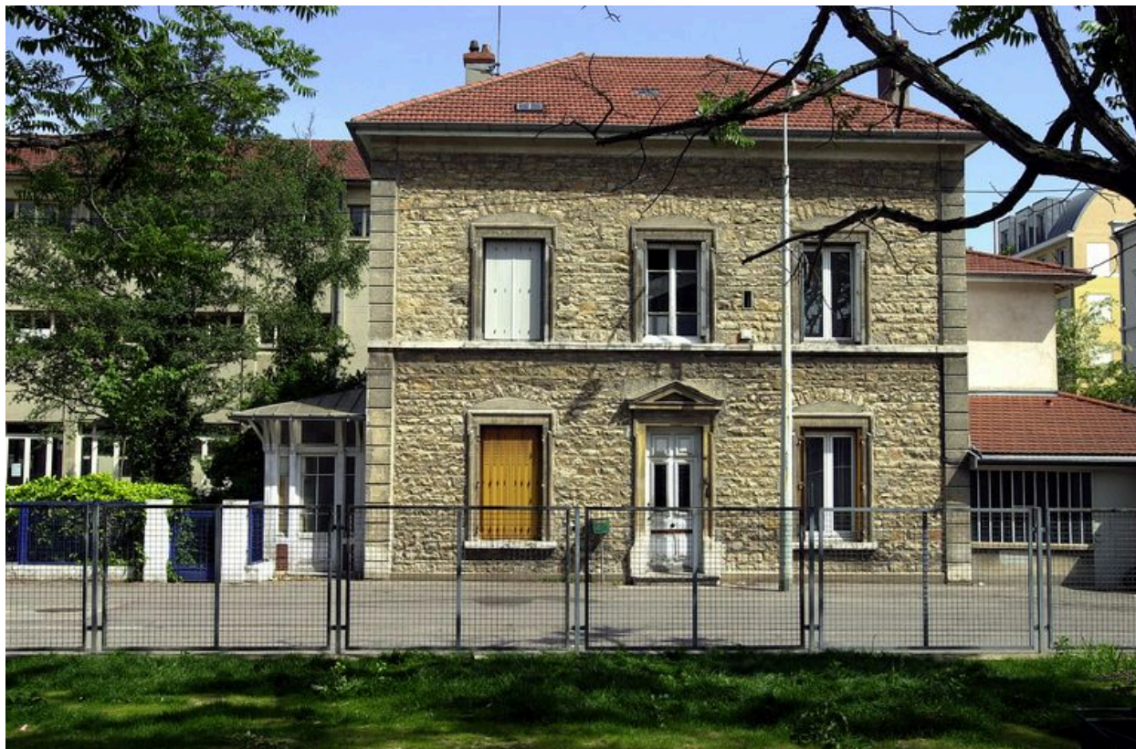
Elévation antérieure de la maison
