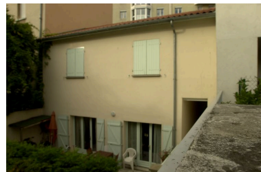
Elévation postérieure Phot. Maryannick Chalabi IVR82_20086900670NUCA
