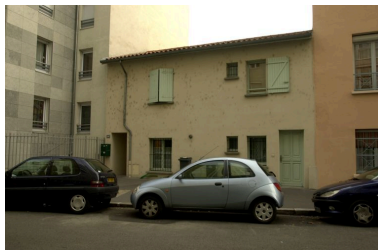
Vue d'ensemble depuis l'ouest Phot. Maryannick Chalabi IVR82_20086900669NUCA
