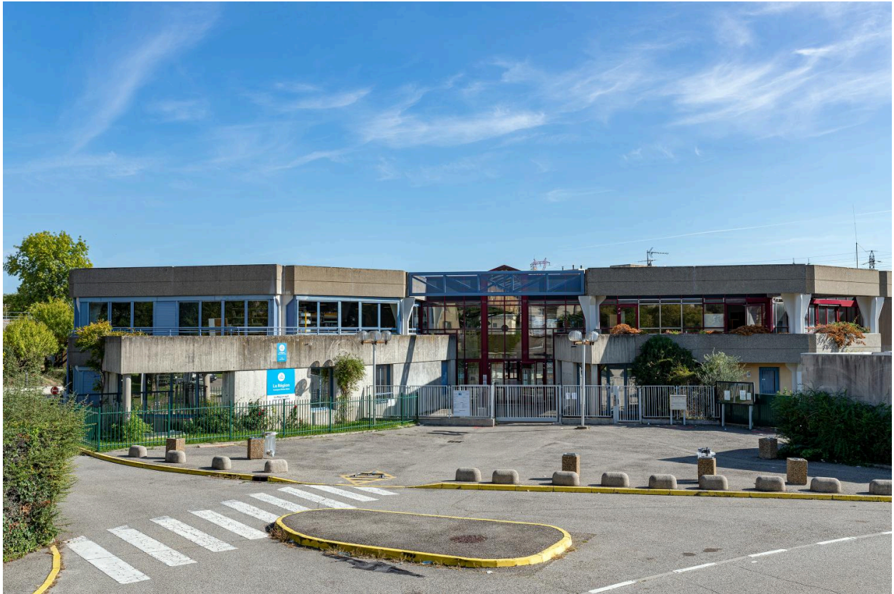
Vue d'ensemble et parvis.
