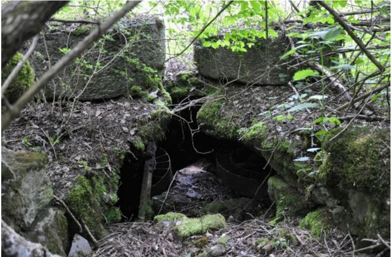
Vue de la chambre souterraine abritant les roues horizontales et surmontée par les meules.
