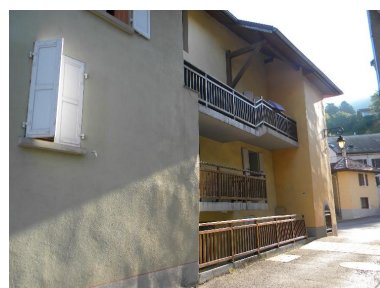
Vue de l'extrémité est des façades arrières. Phot. Jérôme Daviet IVR82_20147400521NUCA
