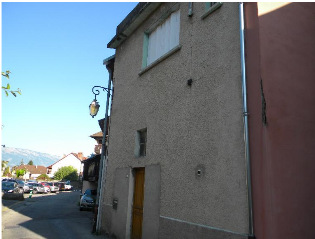
Vue de la façade arrière de la partie ouest de l'îlot.
