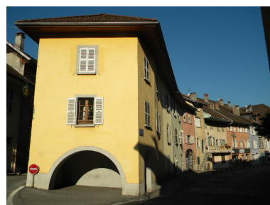
Vue du pignon est avec un espace voûté ouvert sur l'extérieur. Phot. Jérôme Daviet IVR82_20147400529NUCA
