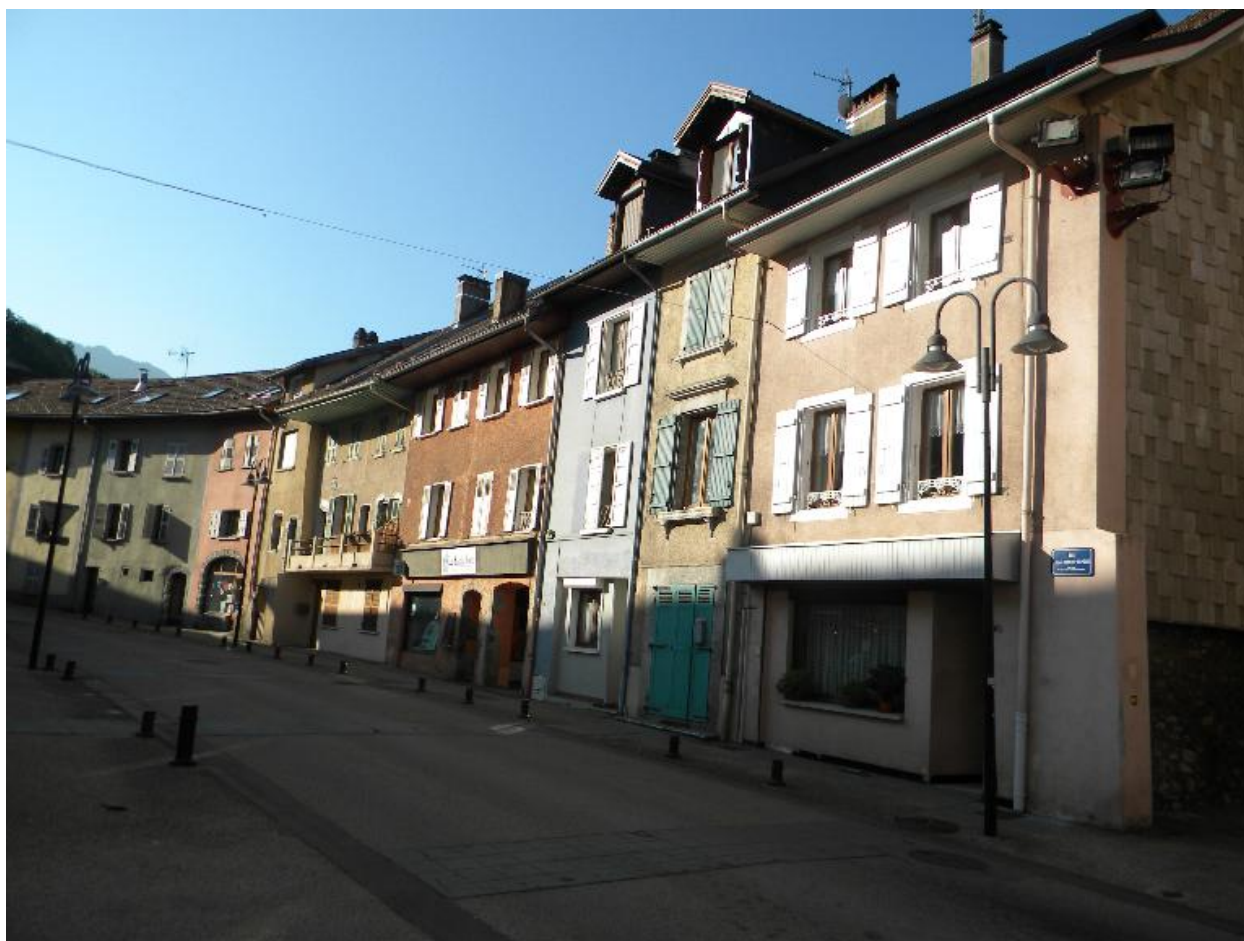
Vue d'ensemble de l'alignement de façades principales.
