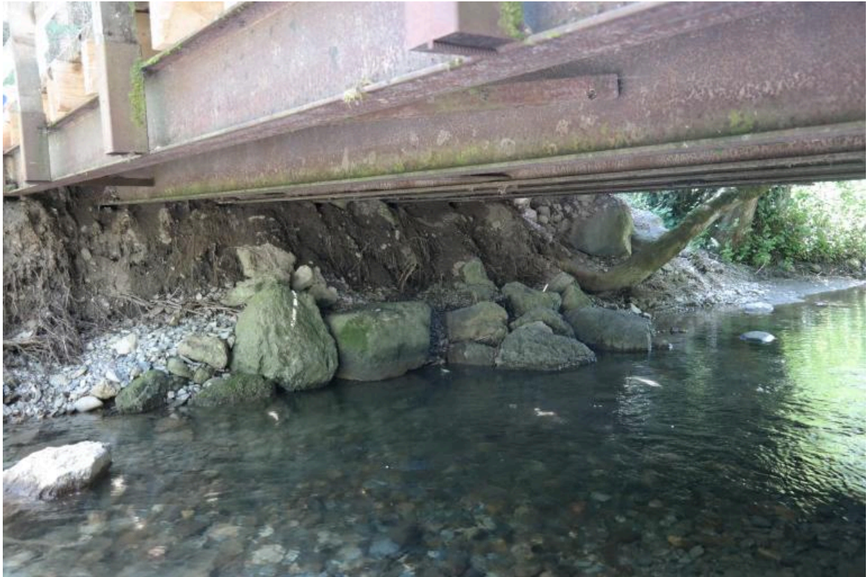
Pont du Bonfin, détail culée et structure
