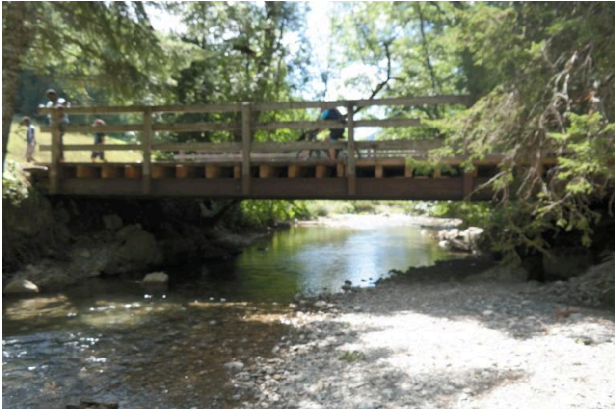
Pont du Banfin, face amont
