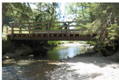
Pont du Banfin, face amont Phot. Pascale Renard IVR84_20207400920NUCA
