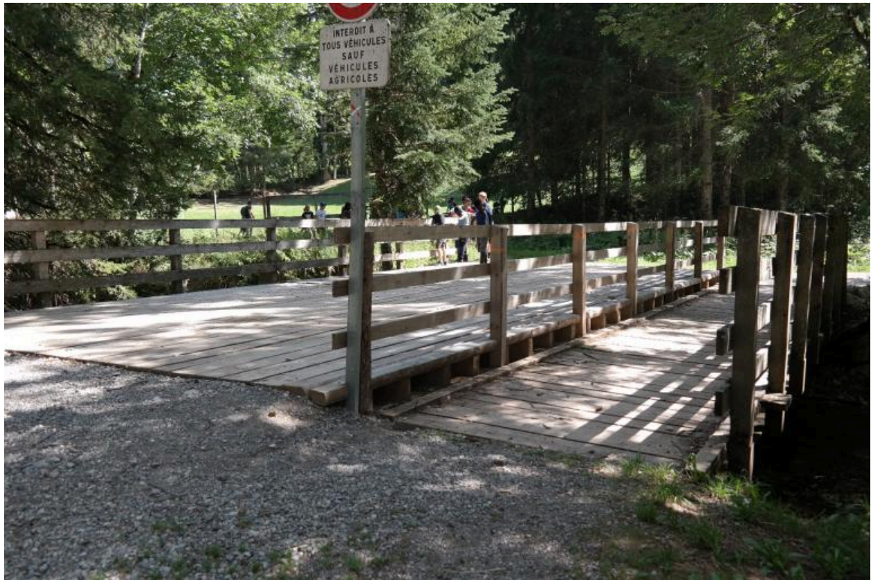
Vue générale du pont du Banfin
