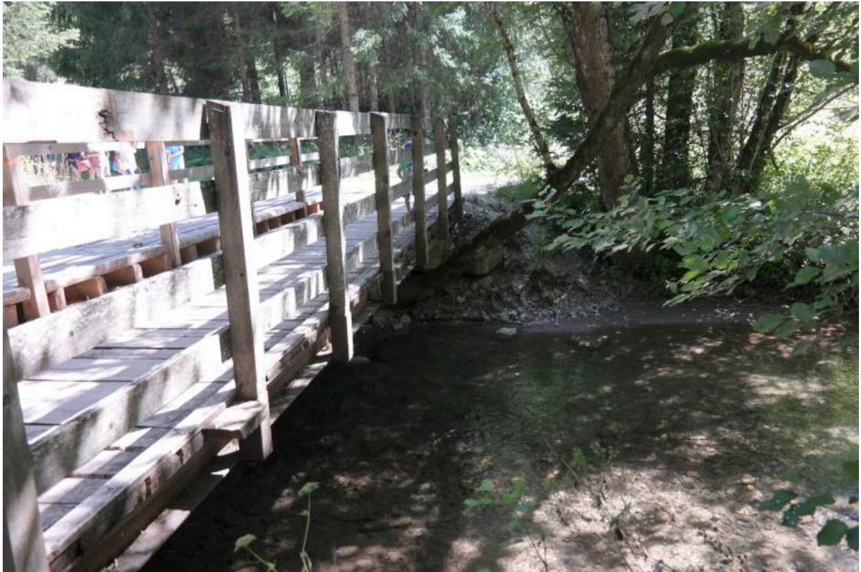
Pont du Banfin, face aval
