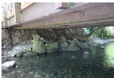
Pont du Bonfin, détail culée et structure Phot. Pascale Renard IVR84_20207400921NUCA
