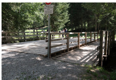
Vue générale du pont du Banfin Phot. Pascale Renard IVR84_20197401198NUCA
