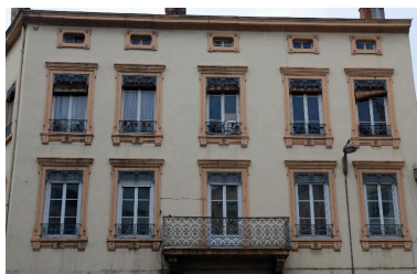
Élévation nord, sur la place Bulard, vue des étages Phot. Magali Delavenne IVR82_20156901174NUCA
