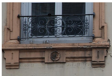
Élévation nord, détail : signature de l'architecte et date portée, sous l'encadrement d'une fenêtre du premier étage Phot. Magali Delavenne IVR82_20156901176NUCA
