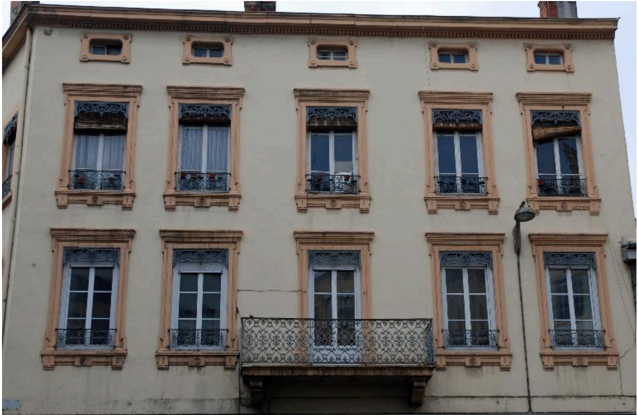
Elévation nord, sur la place Bulard, vue des étages
