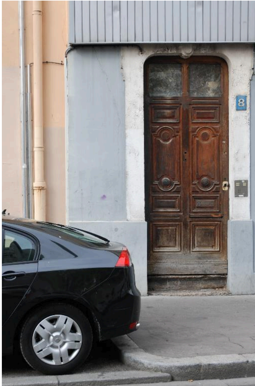
Elévation latérale : vue rapprochée de la porte d'entrée
