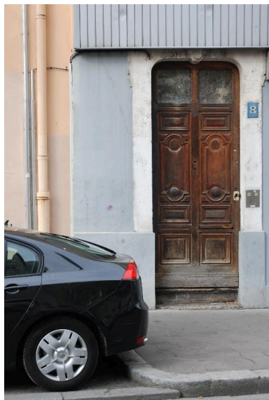
Elévation latérale : vue rapprochée de la porte d'entrée Phot. Magali Delavenne IVR82_20156901180NUCA
