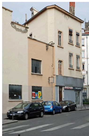
Élévation latérale, sur la rue Béchevelin Phot. Magali Delavenne IVR82_20156901179NUCA
