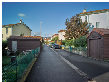
Habitations de type O avec leurs garages dans la partie médiane de l'allée du Coteau, en direction de l'ouest.
