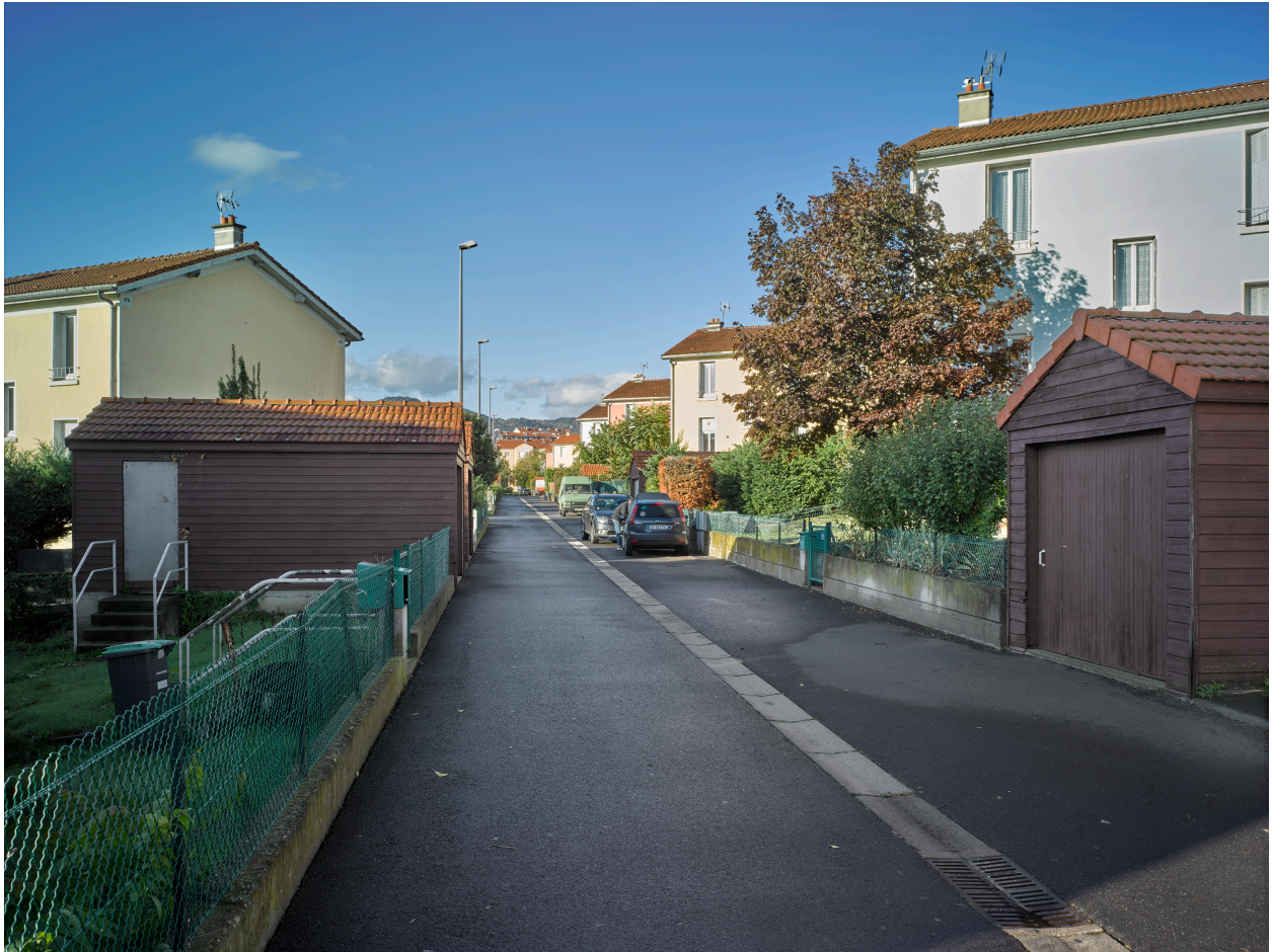
Habitations de type O avec leurs garages dans la partie médiane de l'allée du Coteau, en direction de l'ouest.
