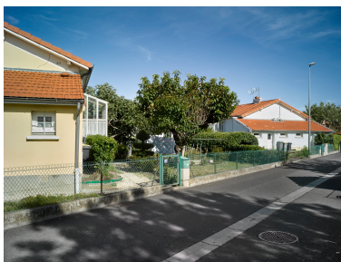
Maisons de type A sur l'allée du Ruisseau. Phot. Christian Parisey IVR84_20196300386NUC4A
