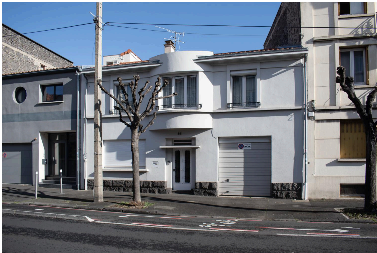
Façade sur le boulevard Jean-Jaurès
