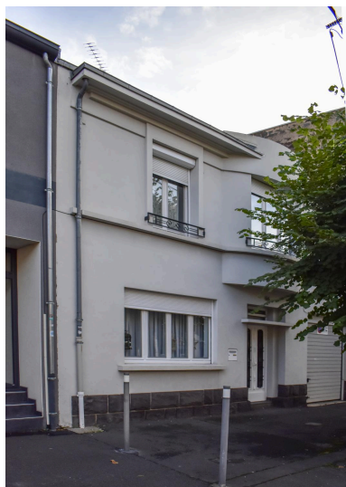
Façade sur le boulevard Jean-Jaurès Phot. Félicie Fougère IVR84_20256302152NUCA
