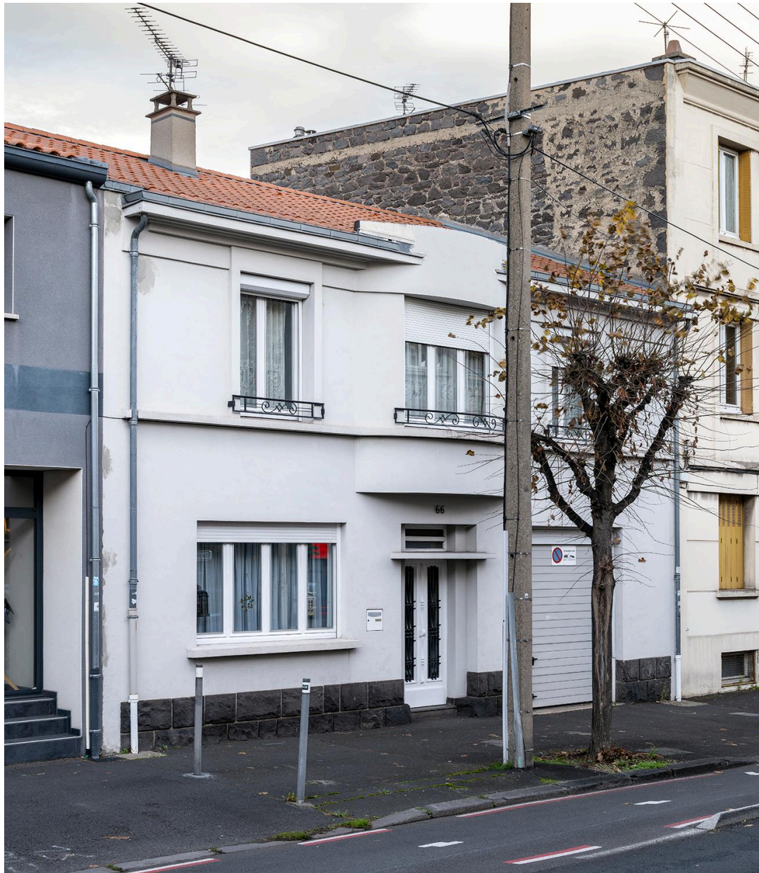
Façade sur le boulevard Jean-Jaurès
