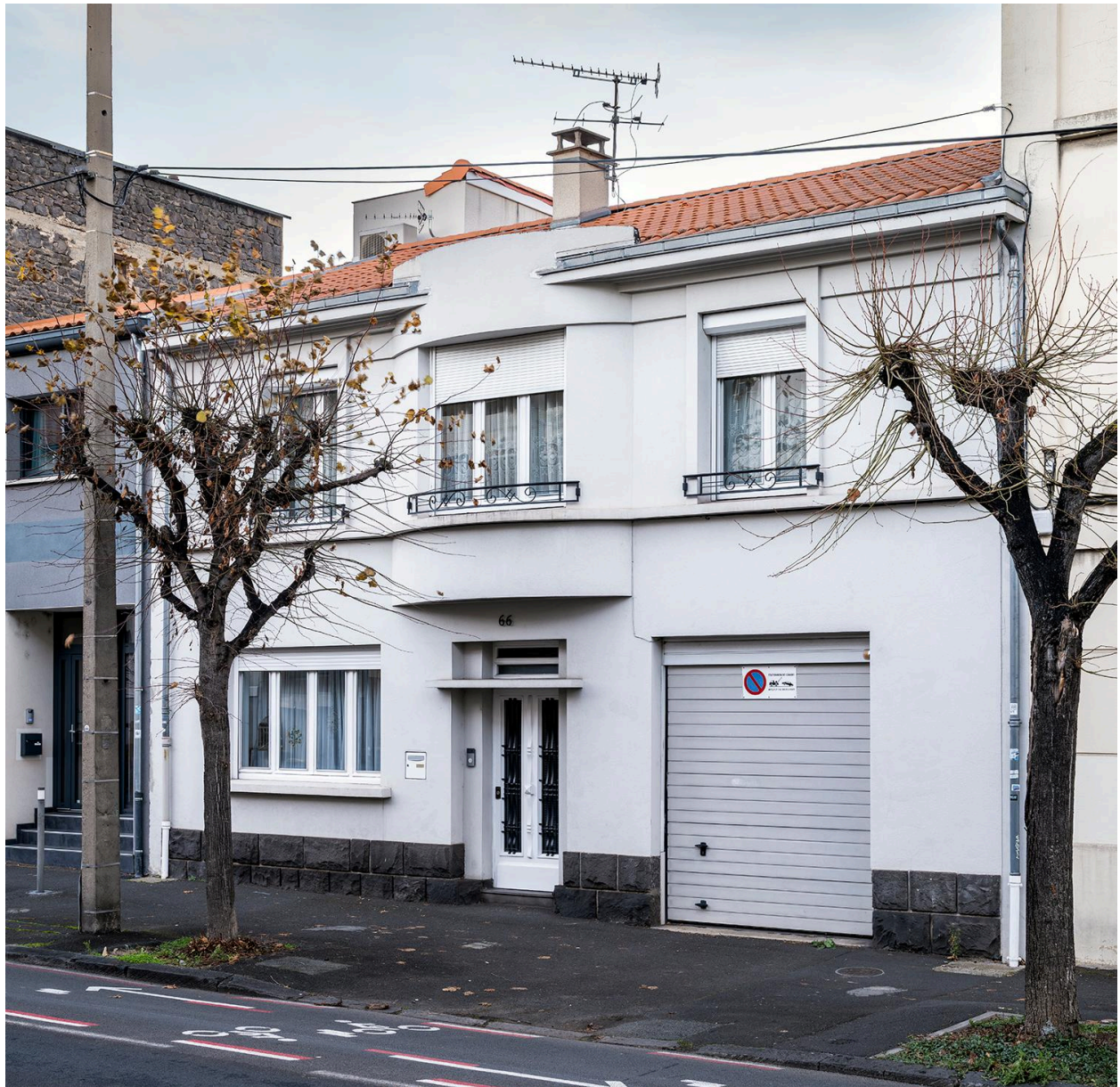
Façade sur le boulevard Jean-Jaurès
