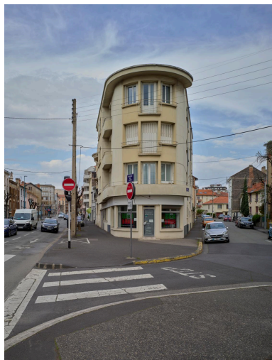
Traitement d'angle Phot. Christian Parisey IVR84_20236300352NUCA4A
