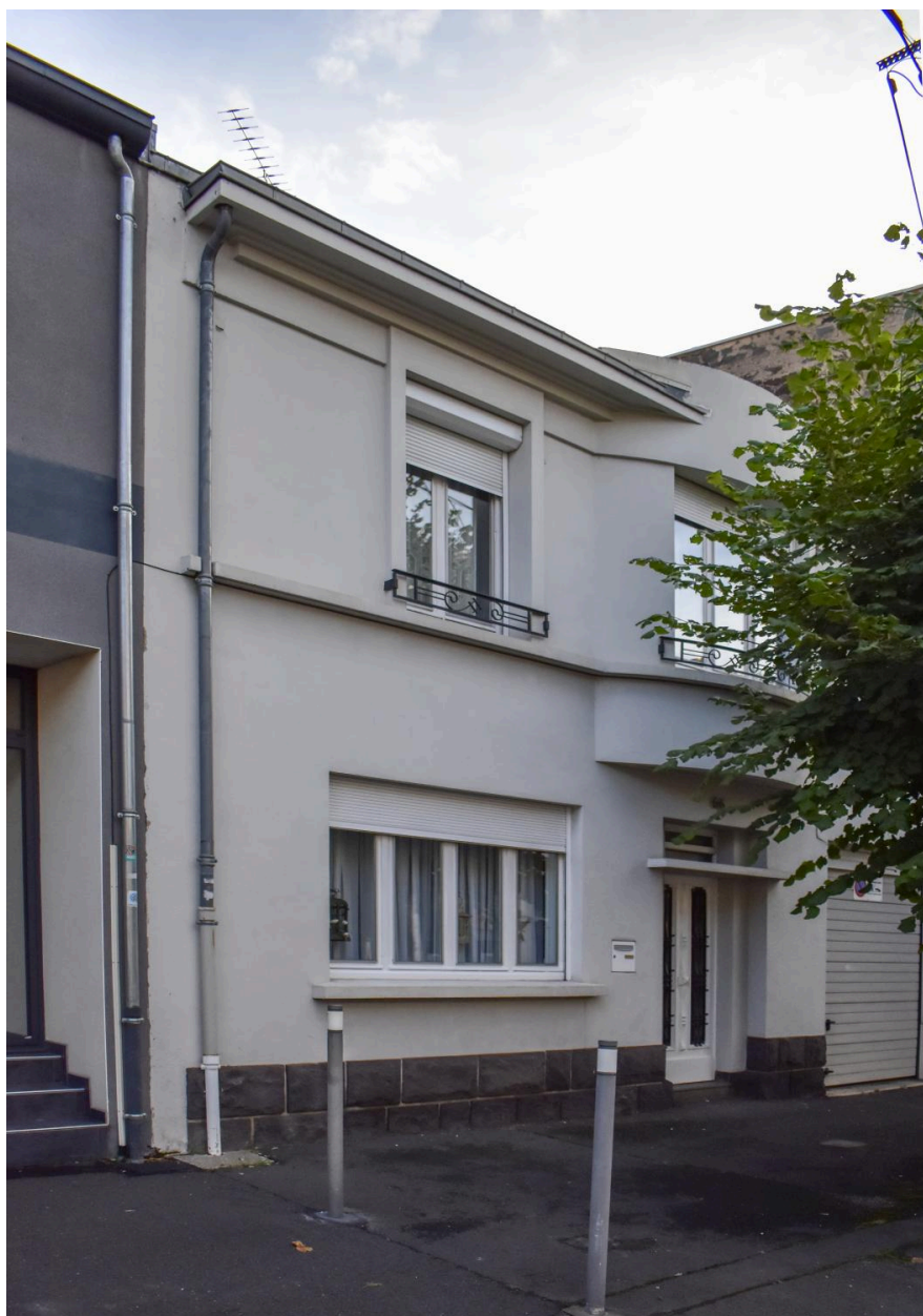
Façade sur le boulevard Jean-Jaurès
