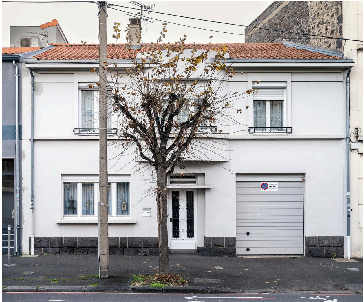
Façade sur le boulevard Jean-Jaurès
