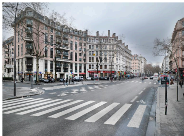
Vue générale depuis le nord Phot. Franck Trabouillet IVR84_20186900184NUCAQ
