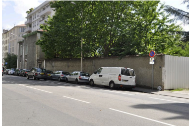
Vue générale. Phot. Catherine Guillot IVR82_20116902179NUCA
