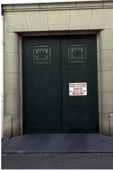
Vue générale de la porte cochère Phot. Bernard Ducouret IVR82_20026901527NUCA
