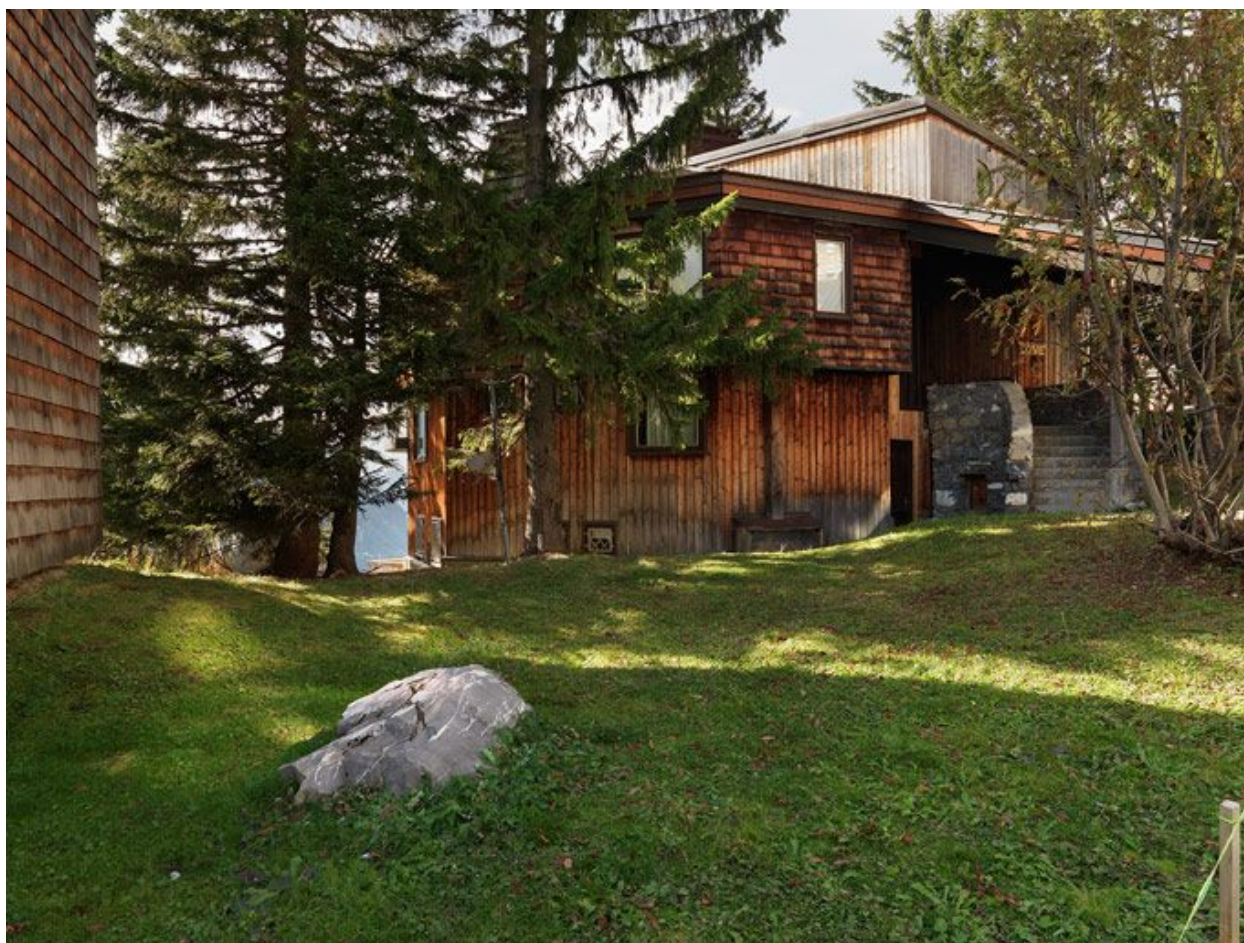
Vue générale depuis la route
