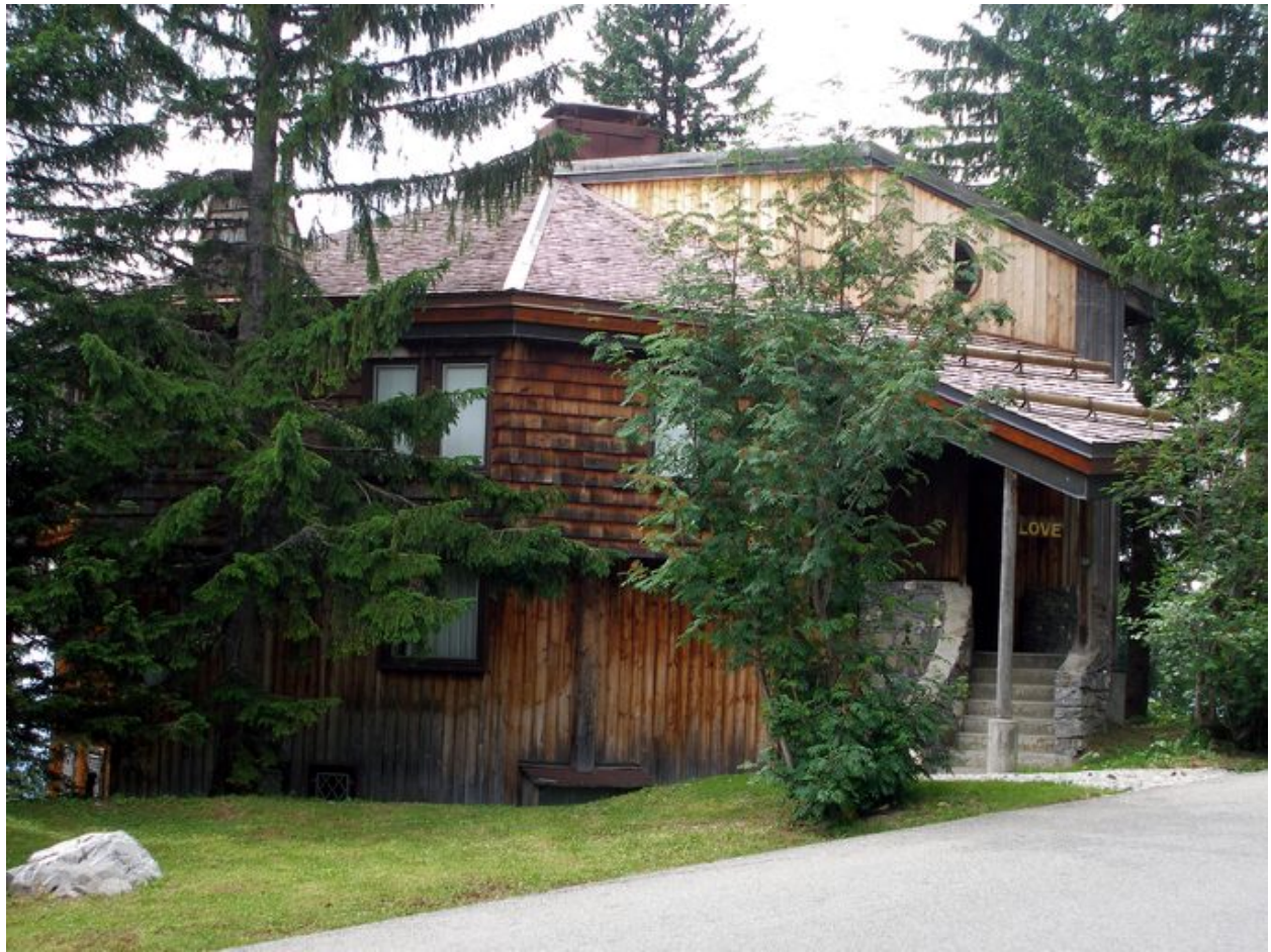
Vue d'ensemble depuis la route
