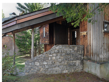
Vue de l'entrée Phot. Eric Dessert IVR82_20097400491NUCA
