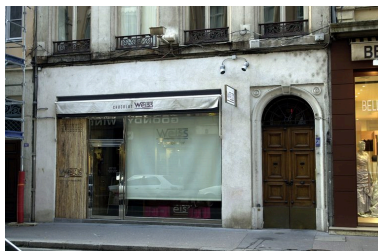
Elévation antérieure : le rez-de-chaussée Phot. Véronique Belle IVR82_20076901272NUCA
