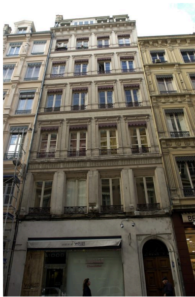
Vue générale rue de Brest Phot. Véronique Belle IVR82_20076901271NUCA
