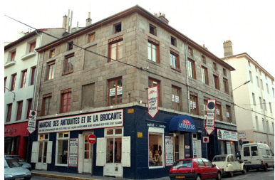
Elévation principale, rue de la Badouillère, et retour rue de la Mulatière Phot. Cendrine Sanquer IVR82_19974201989ZE
