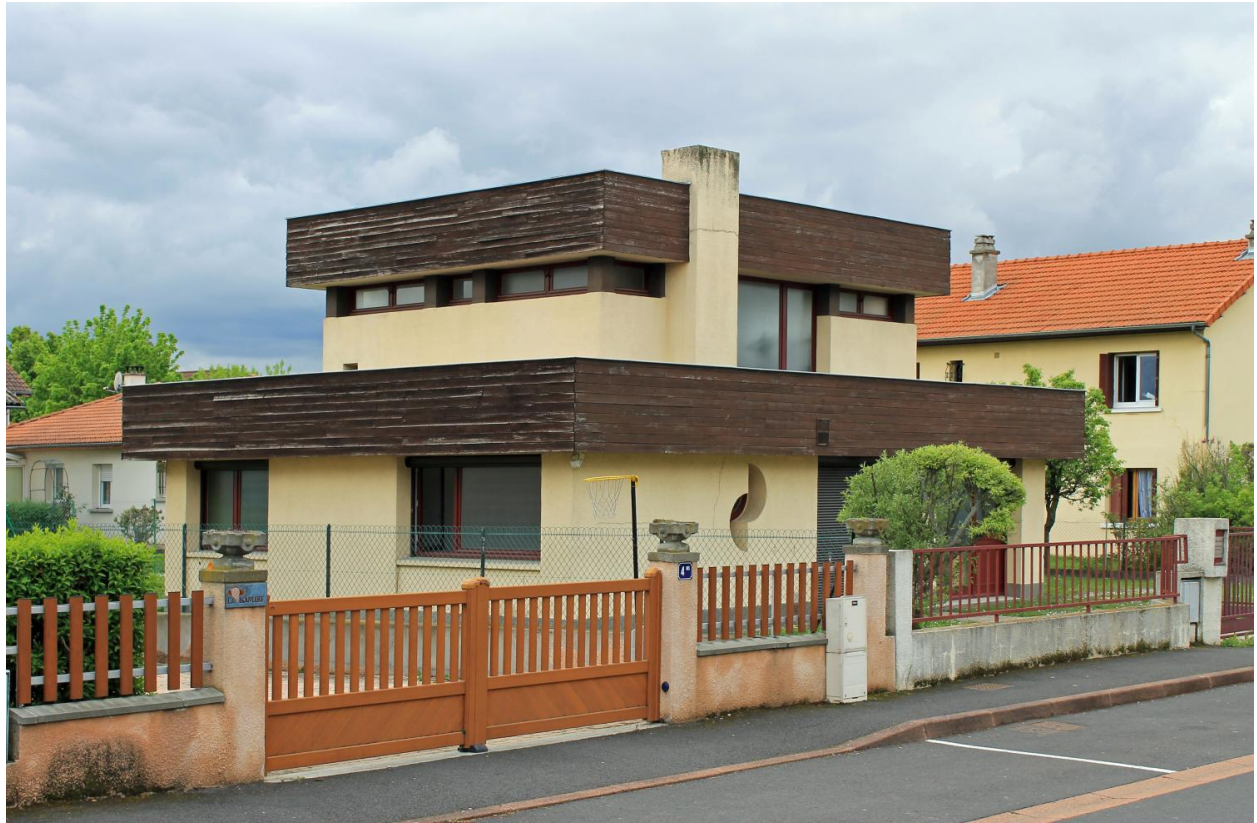
Aulnat, la Maison B.-C. vue du nord-est.
