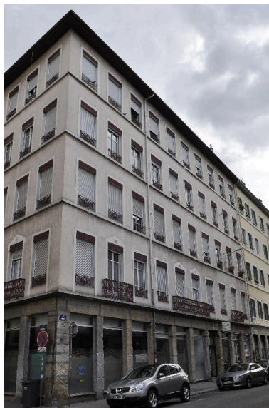
Elévation sud, rue Jangot Phot. Catherine Guégan IVR84_20166900743NUCA
