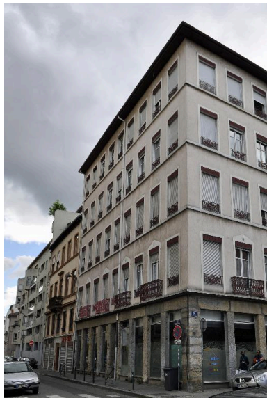
Elévation ouest, rue Béchevelin Phot. Catherine Guégan IVR84_20166900742NUCA
