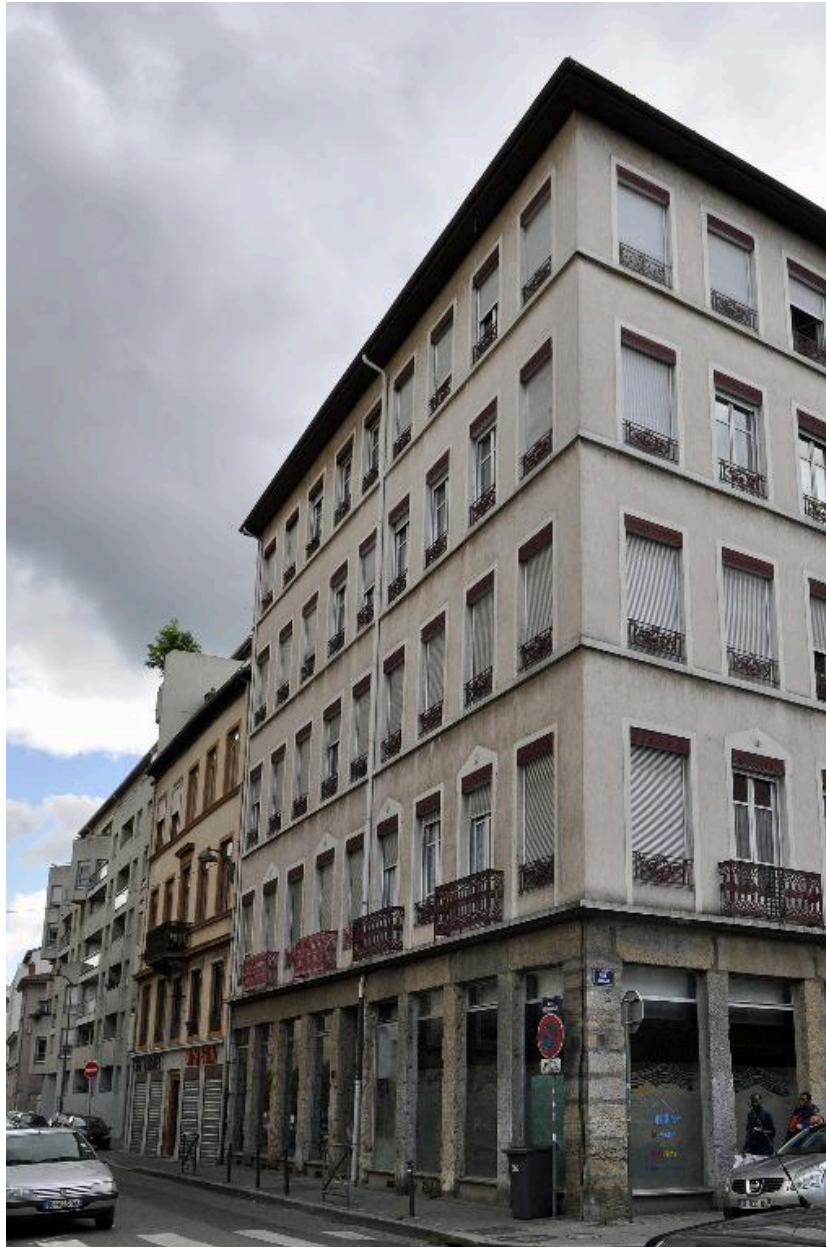
Elévation ouest, rue Béchevelin
