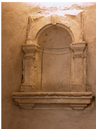
Escalier : niche à lumière permettant d'éclairer les repos Phot. Véronique Belle IVR82_20046905397NUCA
