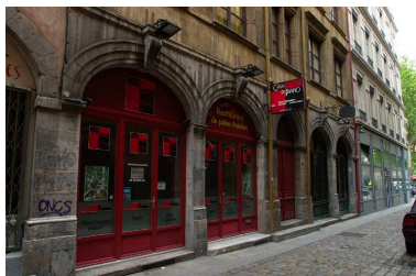
Le rez-de-chaussée Phot. Véronique Belle IVR82_20046905387NUCA
