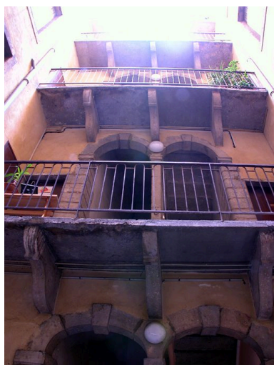
La cour : élévation nord Phot. Véronique Belle IVR82_20046905393NUCA
