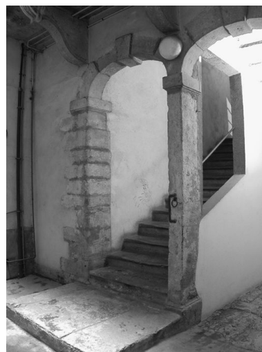
Le départ d'escalier depuis la cour Phot. Véronique Belle IVR82_20046905392NUC
