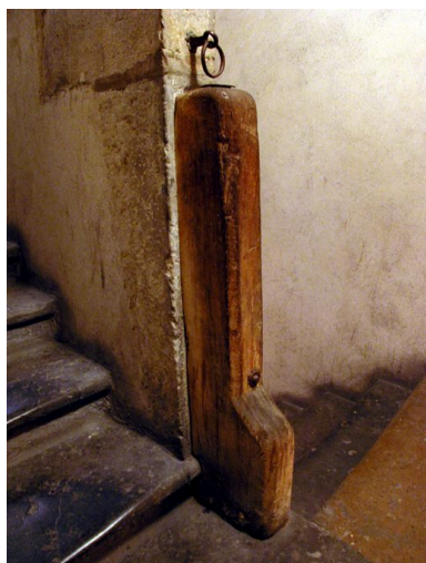
Premier repos de l'escalier : détail Phot. Véronique Belle IVR82_20046905396NUCA
