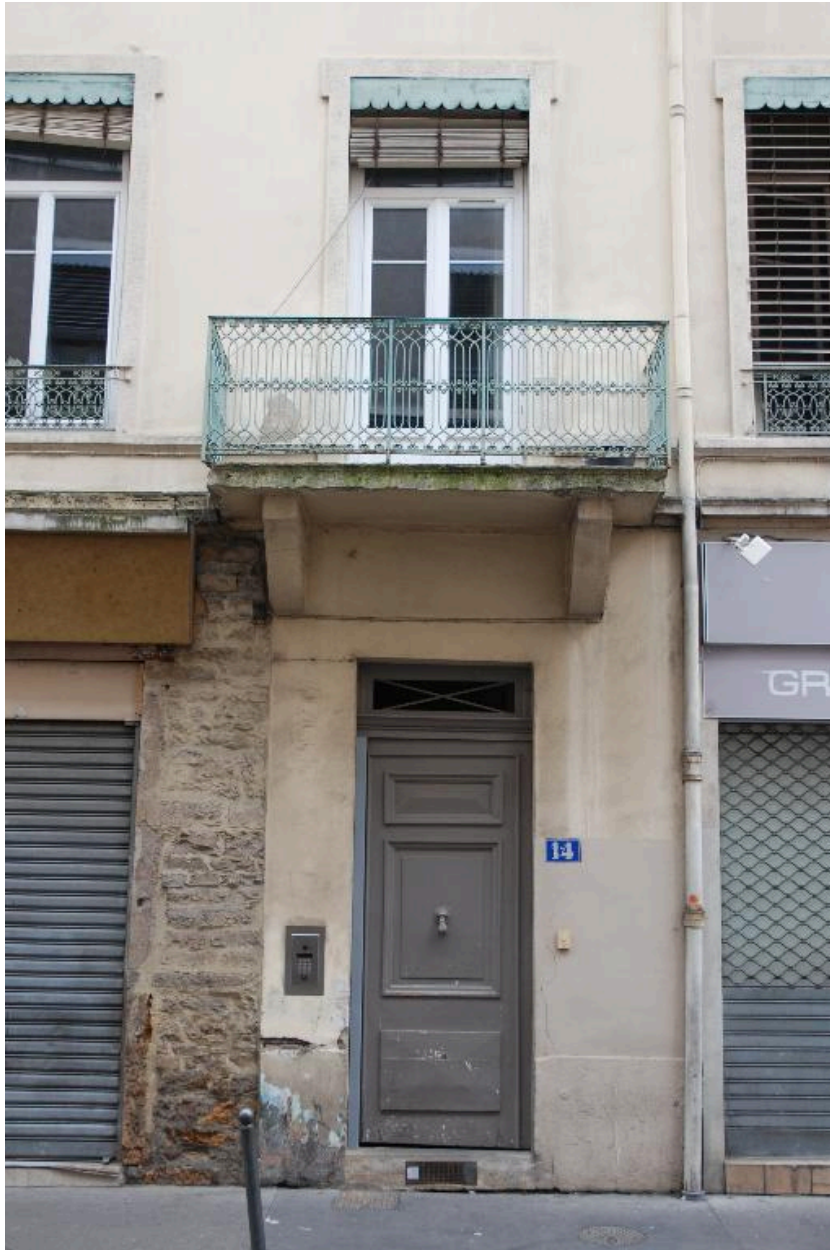
Vue rapprochée de l'élévation sur la rue Pasteur : porte et balcon
