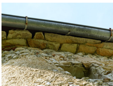
Ensemble occidental. Elévation est, extrémité sud. Avant-toit constitué de deux rangs de lauze. Phot. Alexeï Laurent IVR84_20162600763NUCA
