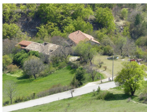
Vue d'ensemble prise du nord.
