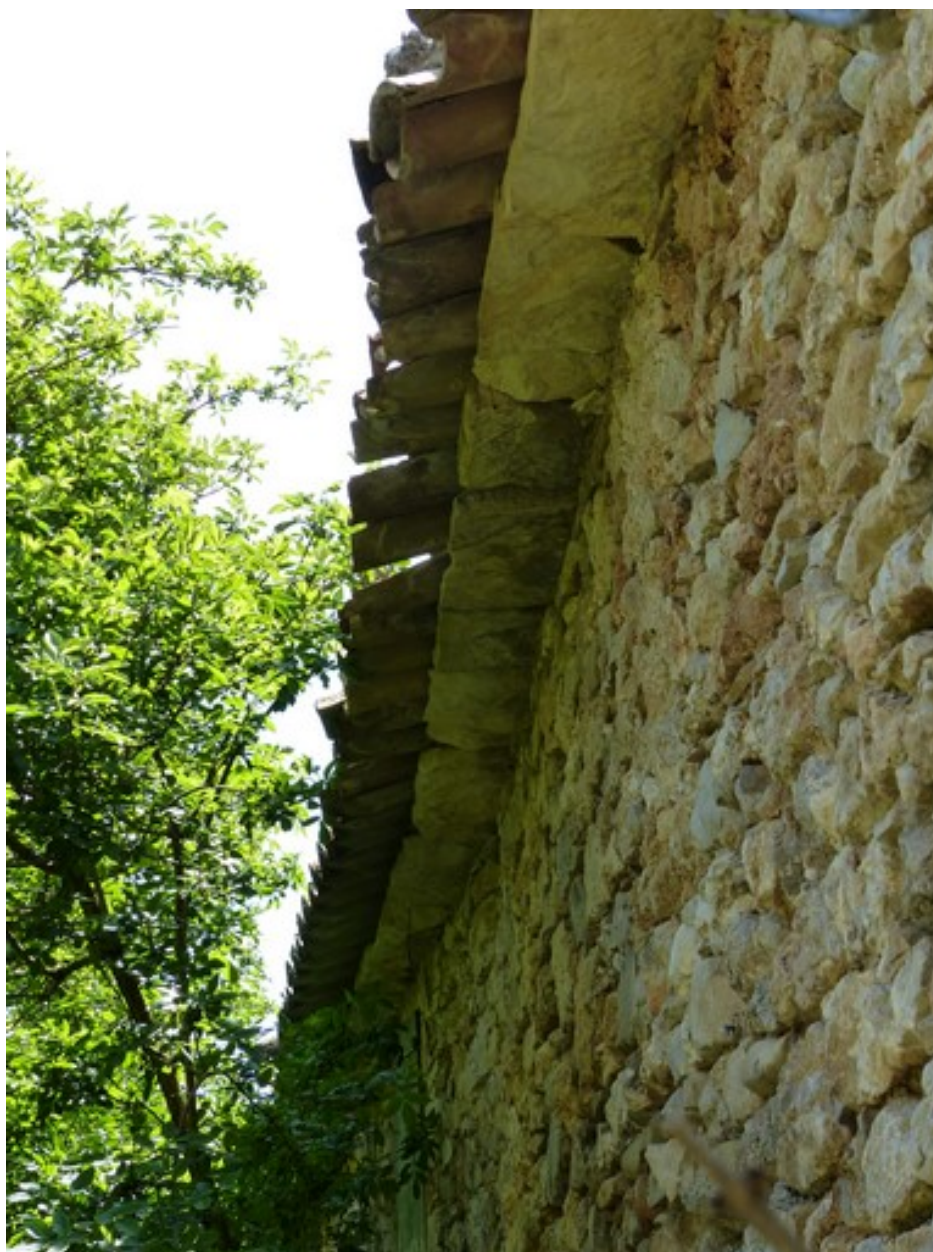
Ensemble oriental. Elévation est, avant-toit constitué d'un débord de lauze.
