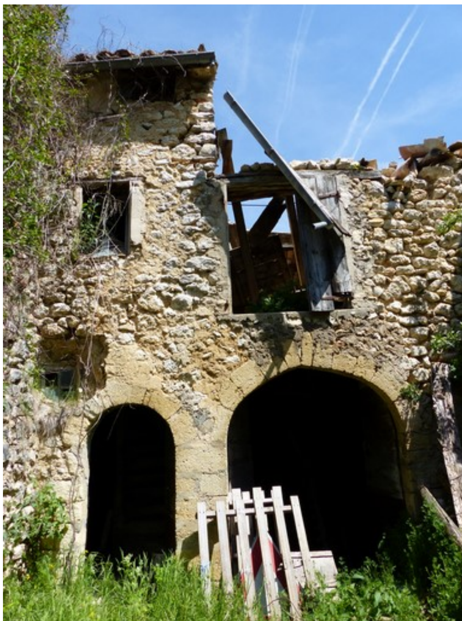
Ensemble oriental. Partie centrale. Elévation ouest.
