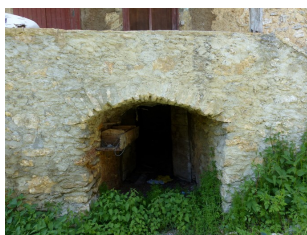
Ensemble occidental. Elévation est, passage voûté sous le palier filant.
