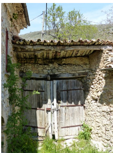
Portail de la cour, vue prise du sud. Phot. Alexeï Laurent IVR84_20162600754NUCA
