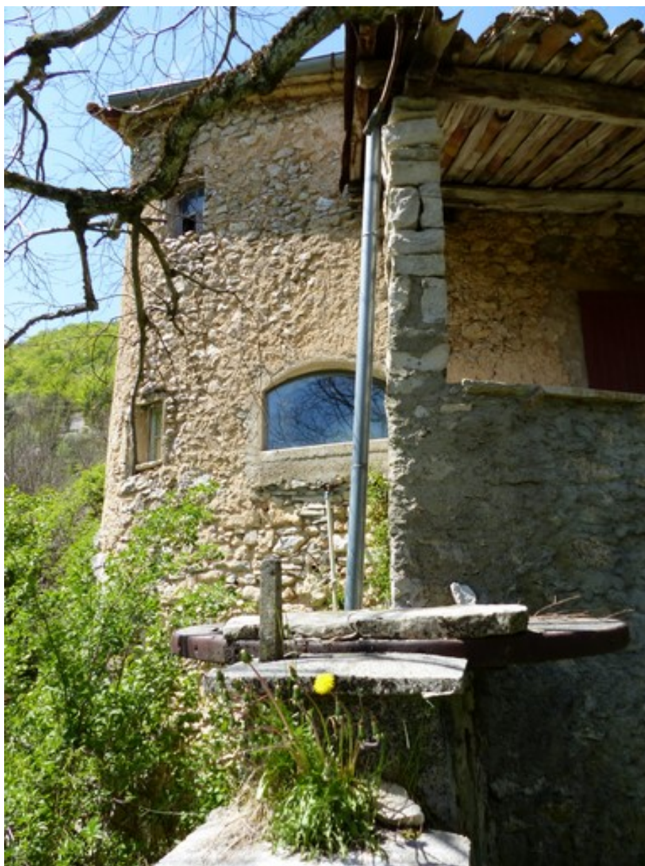
Ensemble occidental. Elévation est, extrémité sud.
