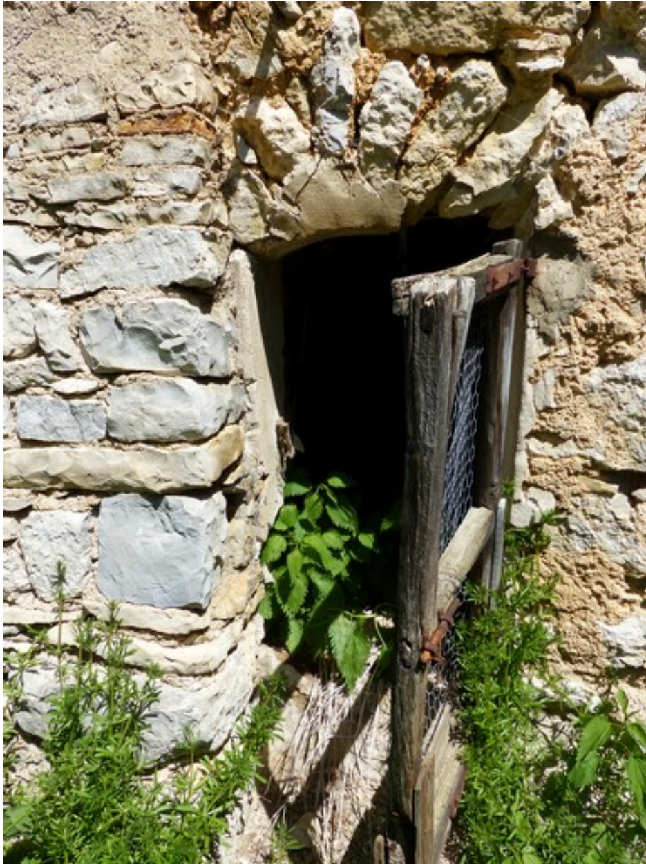
Ensemble oriental. Partie sud. Elévation ouest, partie sud. Porte du poulailler situé sous l'escalier couvert.
