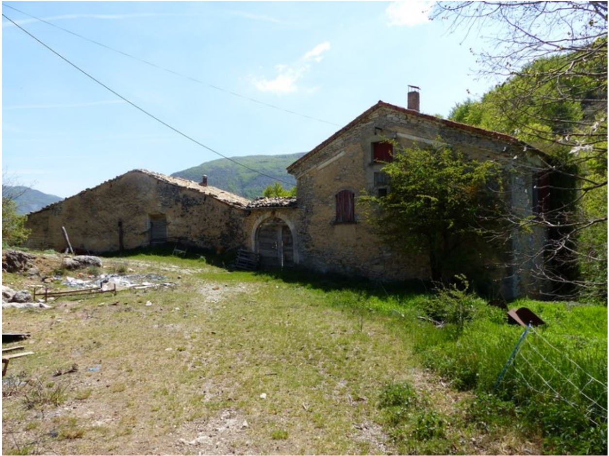
Vue d'ensemble prise du nord-ouest.
