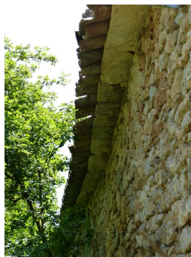
Ensemble oriental. Elévation est, avant-toit constitué d'un débord de lauze. Phot. Alexeï Laurent IVR84_20162600776NUCA
