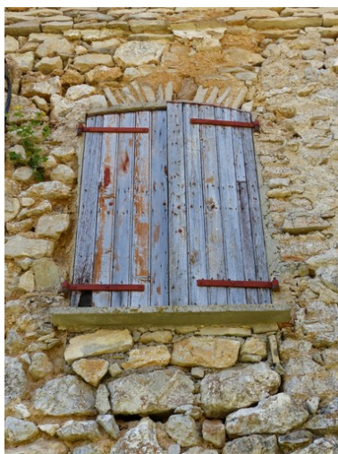
Ensemble occidental. Elévation est, second niveau. Fenêtre. Phot. Alexeï Laurent IVR84_20162600760NUCA
