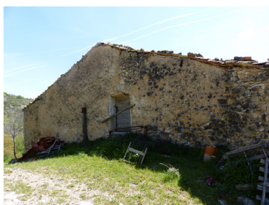
Ensemble oriental. Pignon nord. Phot. Alexeï Laurent IVR84_20162600772NUCA
