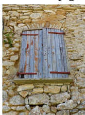
Ensemble occidental. Elévation est, second niveau. Fenêtre.
