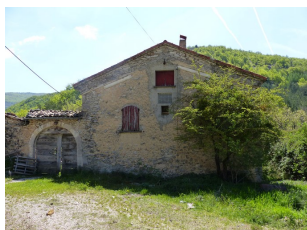
Ensemble occidental. Pignon nord.
