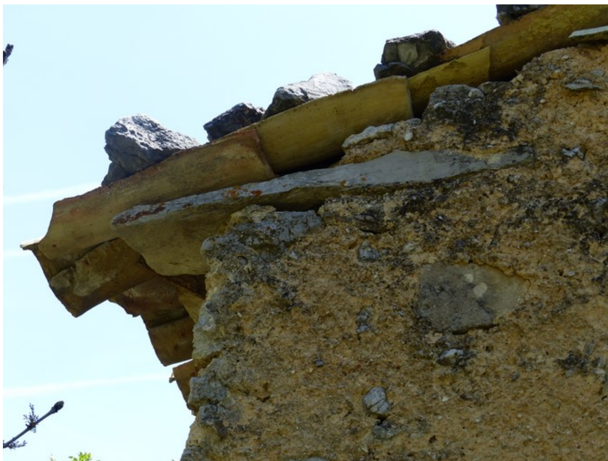
Ensemble oriental. Chaîne d'angle nord-est, avant-toit constitué d'un débord de lauze.
