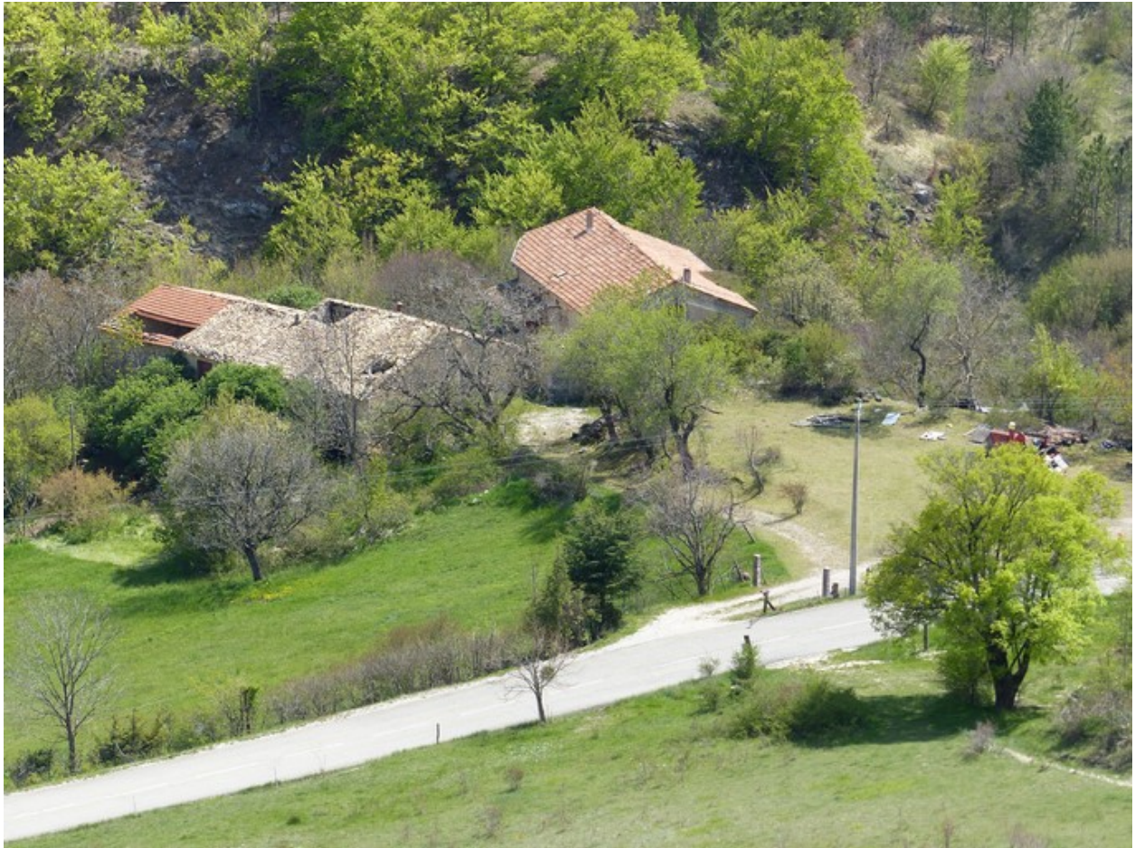
Vue d'ensemble prise du nord.
