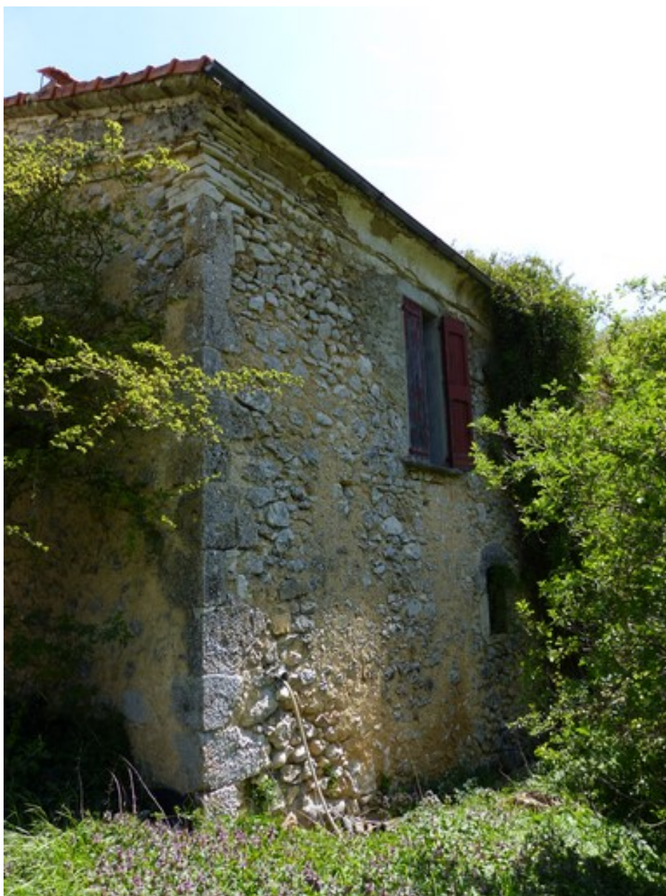
Ensemble occidental. Elévation ouest, partie nord.
