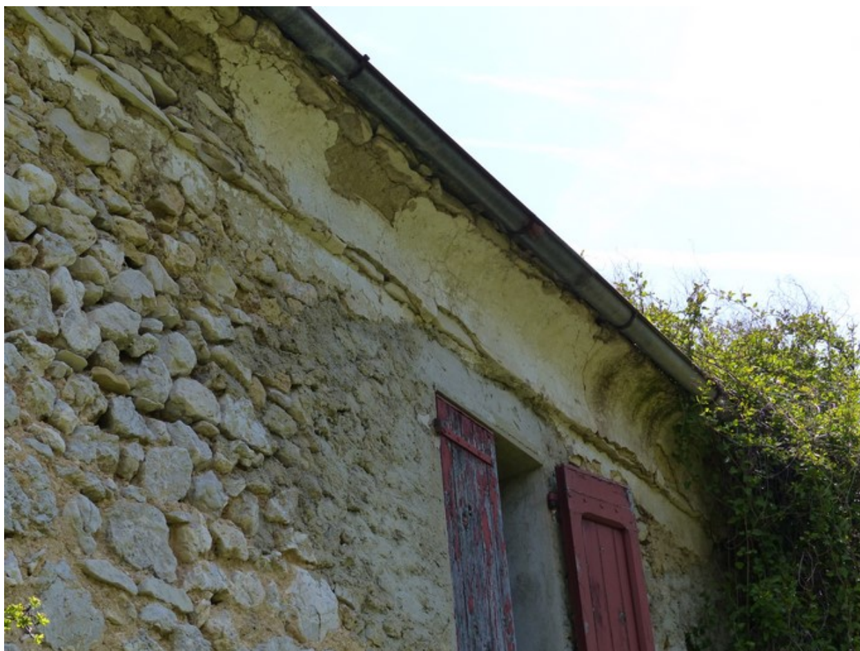
Ensemble occidental. Elévation ouest, avant-toit en voussure façonnée.
