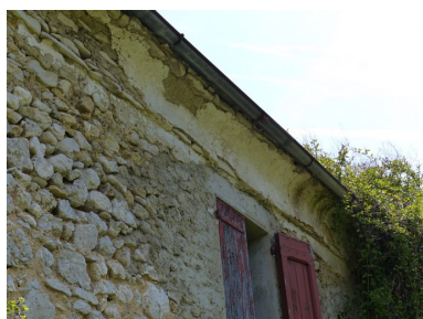
Ensemble occidental. Elévation ouest, avant-toit en voussure façonnée. Phot. Alexeï Laurent IVR84_20162600768NUCA
