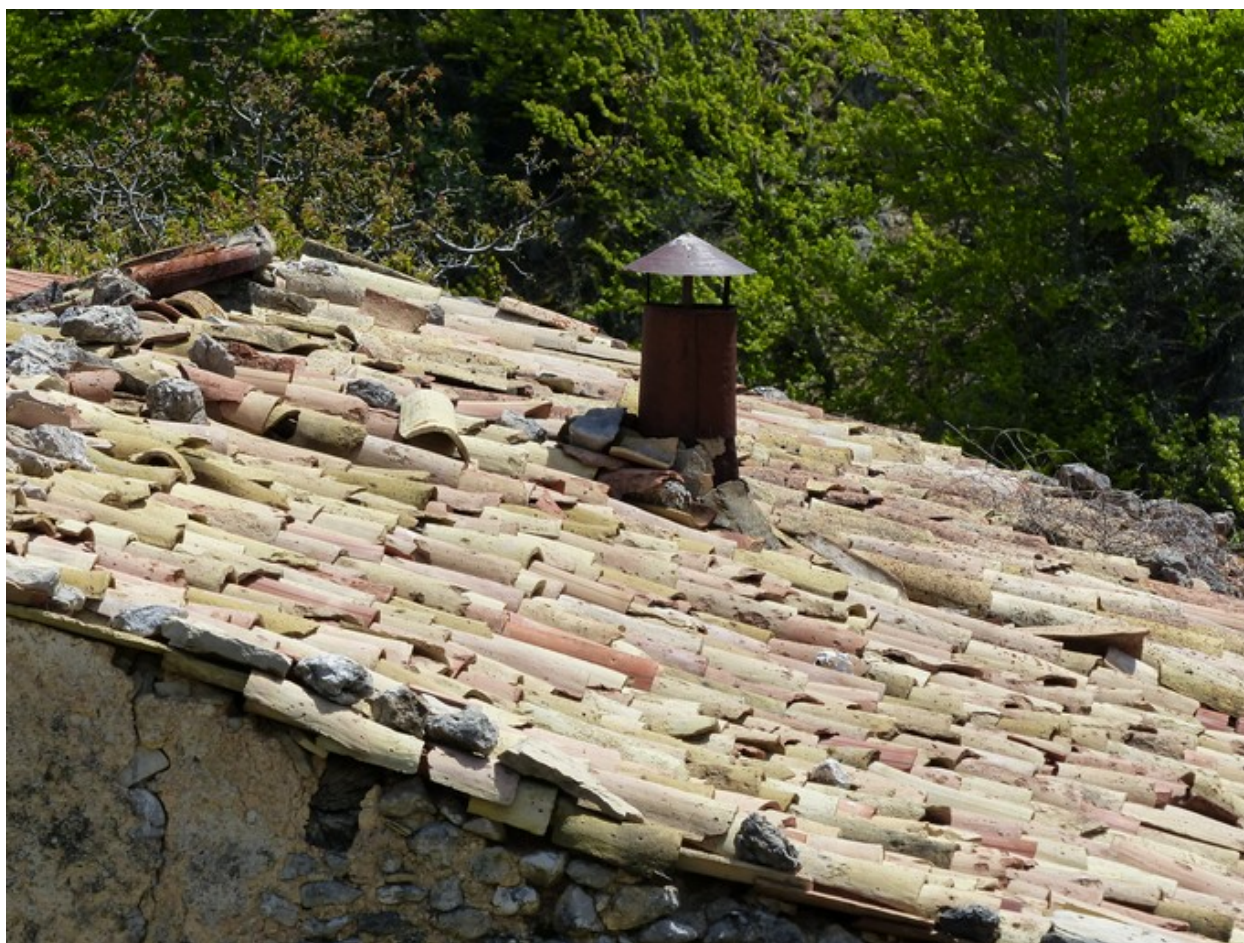
Ensemble oriental. Couverture en tuile creuse.
