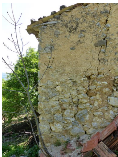
Ensemble oriental. Chaîne d'angle nord-est. Phot. Alexeï Laurent IVR84_20162600774NUCA
