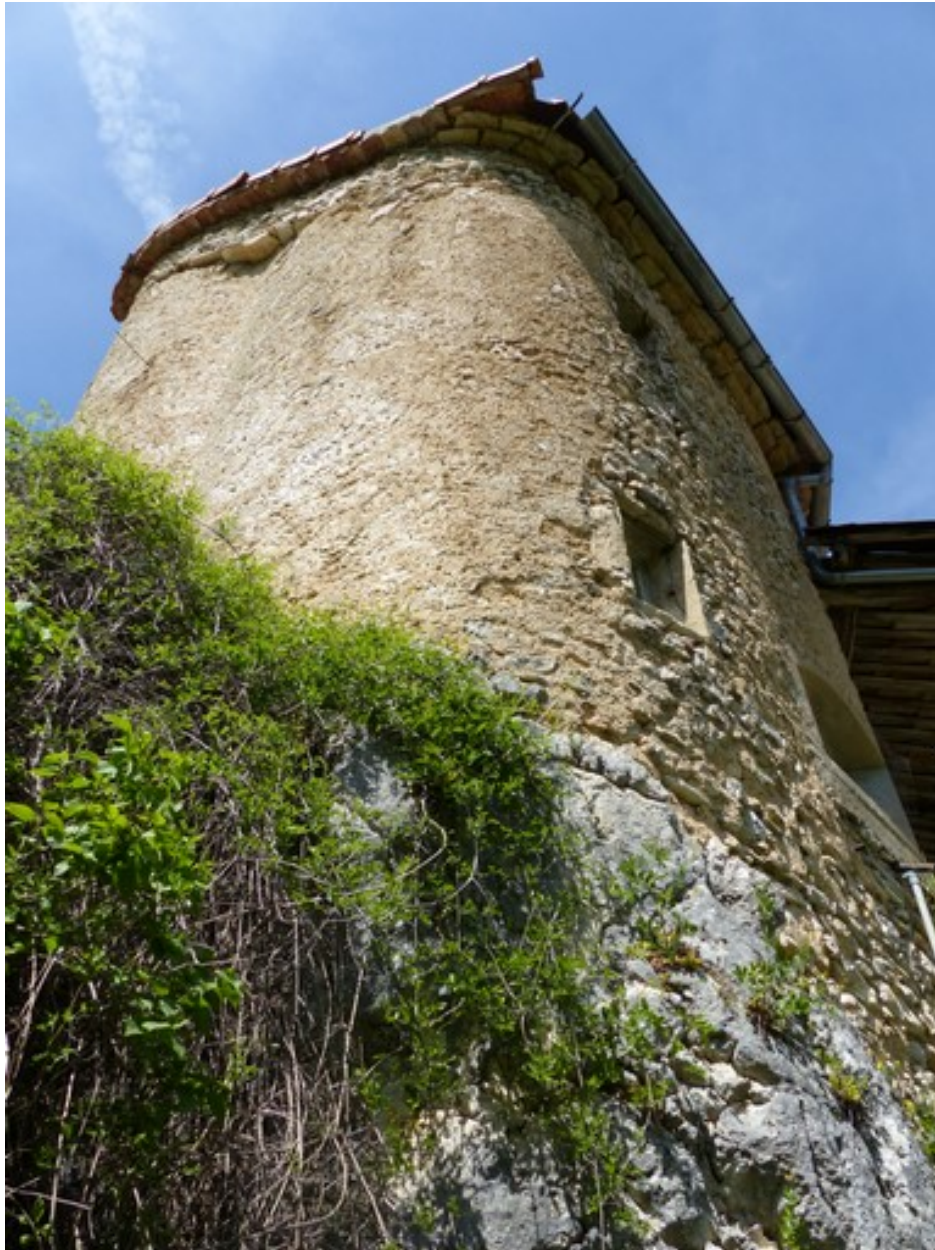
Ensemble occidental. Extension sud, vue d'ensemble prise du sud-est.
