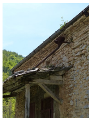
Ensemble occidental. Elévation sud, collecteur de citerne.
