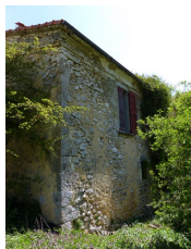
Ensemble occidental. Elévation ouest, partie nord.
