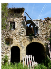
Ensemble oriental. Partie centrale. Elévation ouest.
