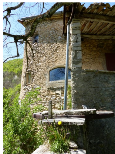
Ensemble occidental. Elévation est, extrémité sud. Phot. Alexeï Laurent IVR84_20162600761NUCA
