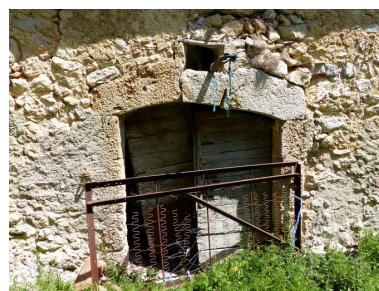
Ensemble oriental. Partie nord. Elévation ouest, porte de l'étable. Phot. Alexeï Laurent IVR84_20162600779NUCA
