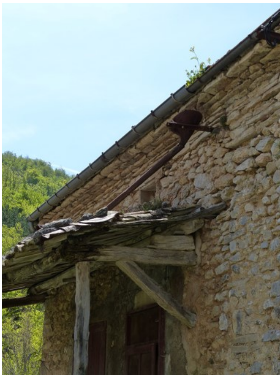
Ensemble occidental. Elévation sud, collecteur de citerne.
