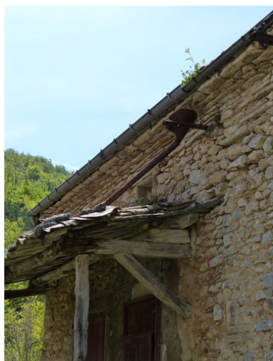
Ensemble occidental. Elévation sud, collecteur de citerne. Phot. Alexeï Laurent IVR84_20162600759NUCA
