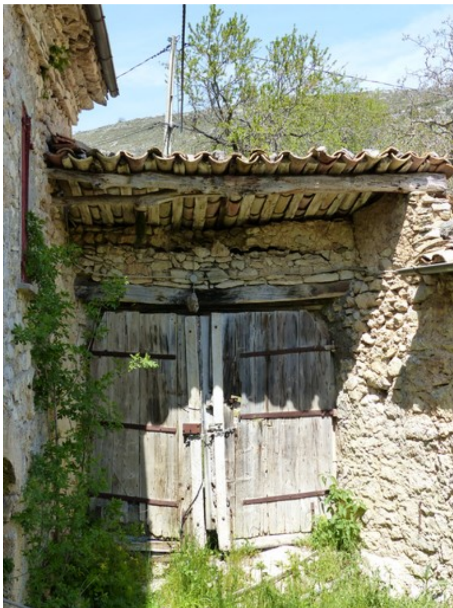
Portail de la cour, vue prise du sud.
