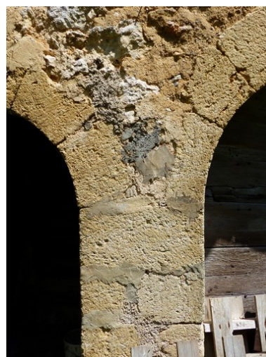
Ensemble oriental. Partie centrale. Elévation ouest, partie nord. Portes du logis et de l'écurie, détail du piédroit commun. Phot. Alexeï Laurent IVR84_20162600788NUCA
