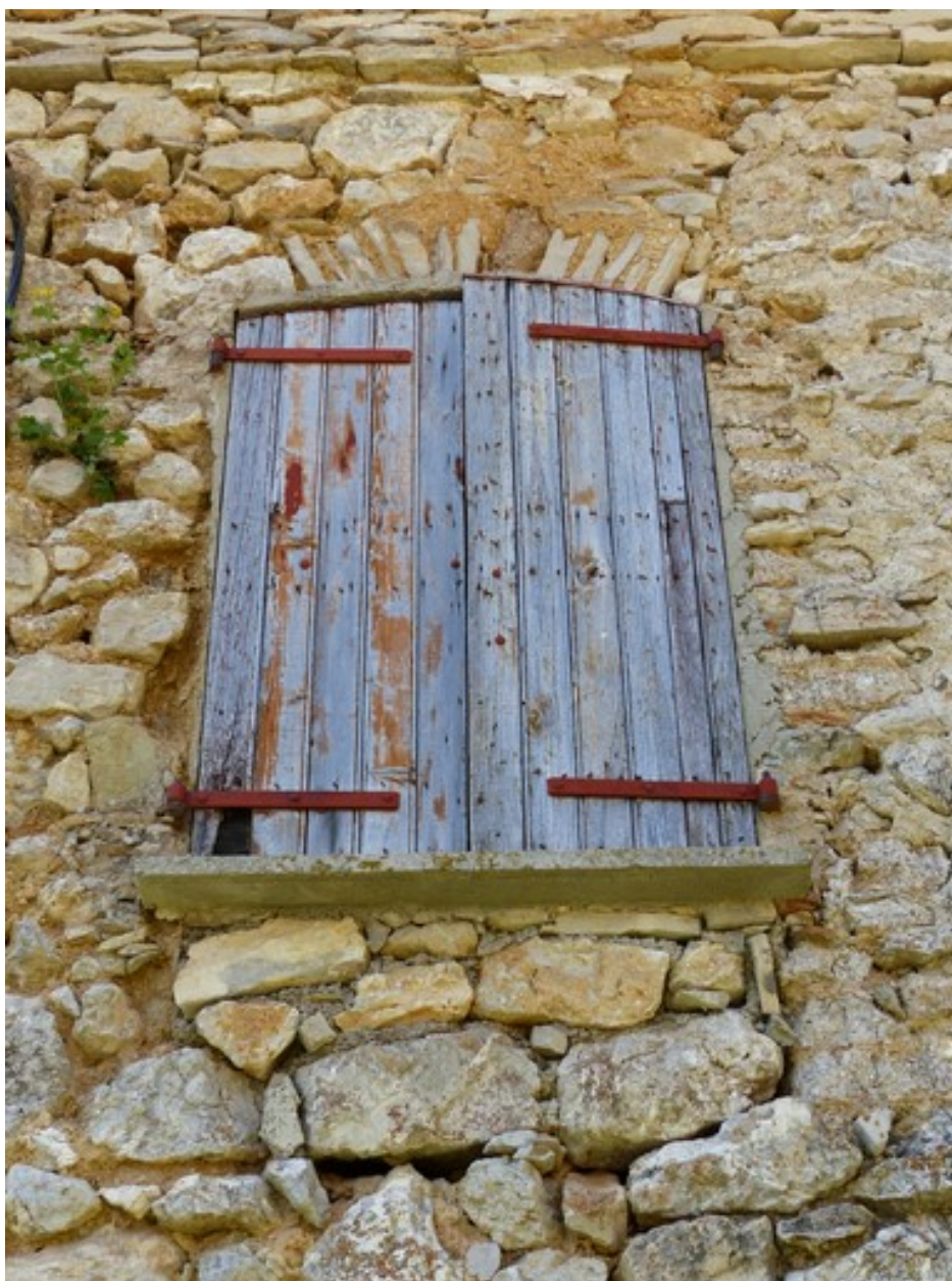
Ensemble occidental. Elévation est, second niveau. Fenêtre.
