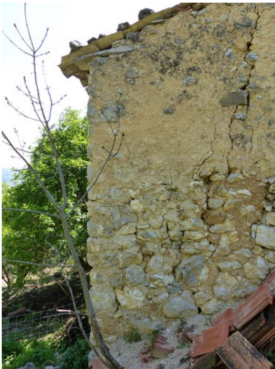
Ensemble oriental. Chaîne d'angle nord-est.
