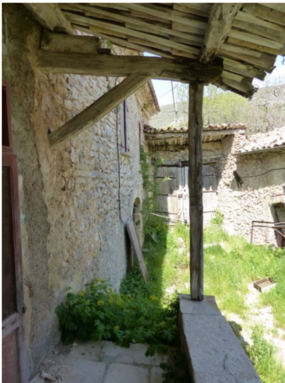
Ensemble occidental. Elévation est, palier filant couvert.
