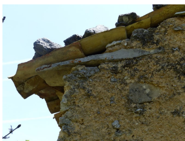
Ensemble oriental. Chaîne d'angle nord-est, avant-toit constitué d'un débord de lauze. Phot. Alexeï Laurent IVR84_20162600775NUCA
