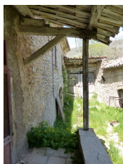
Ensemble occidental. Elévation est, palier filant couvert.
