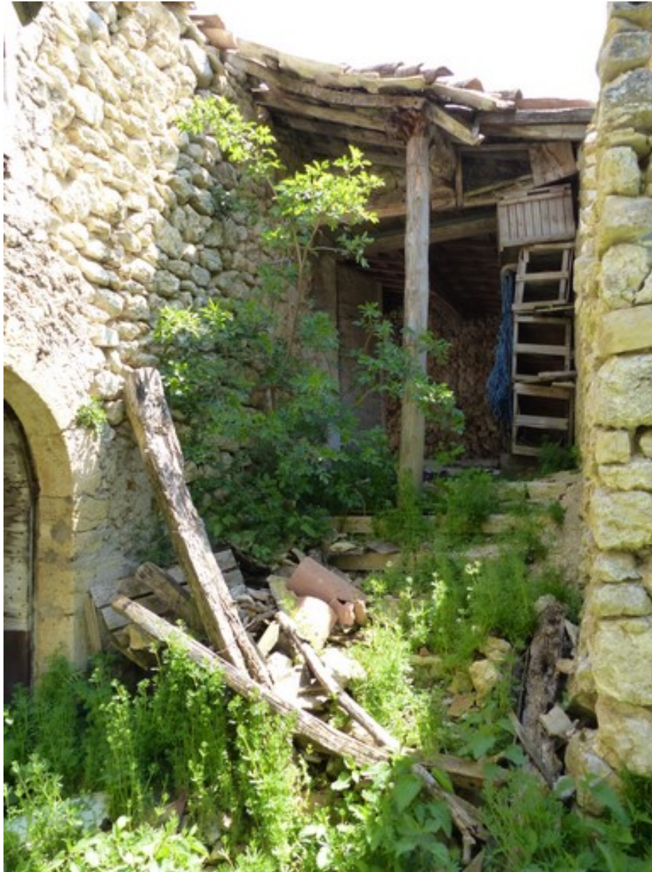
Ensemble oriental. Partie sud. Elévation sud, escalier extérieur couvert.
