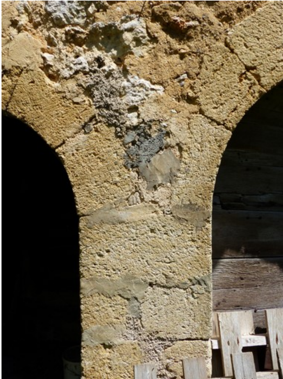
Ensemble oriental. Partie centrale. Elévation ouest, partie nord. Portes du logis et de l'écurie, détail du piédroit commun.
