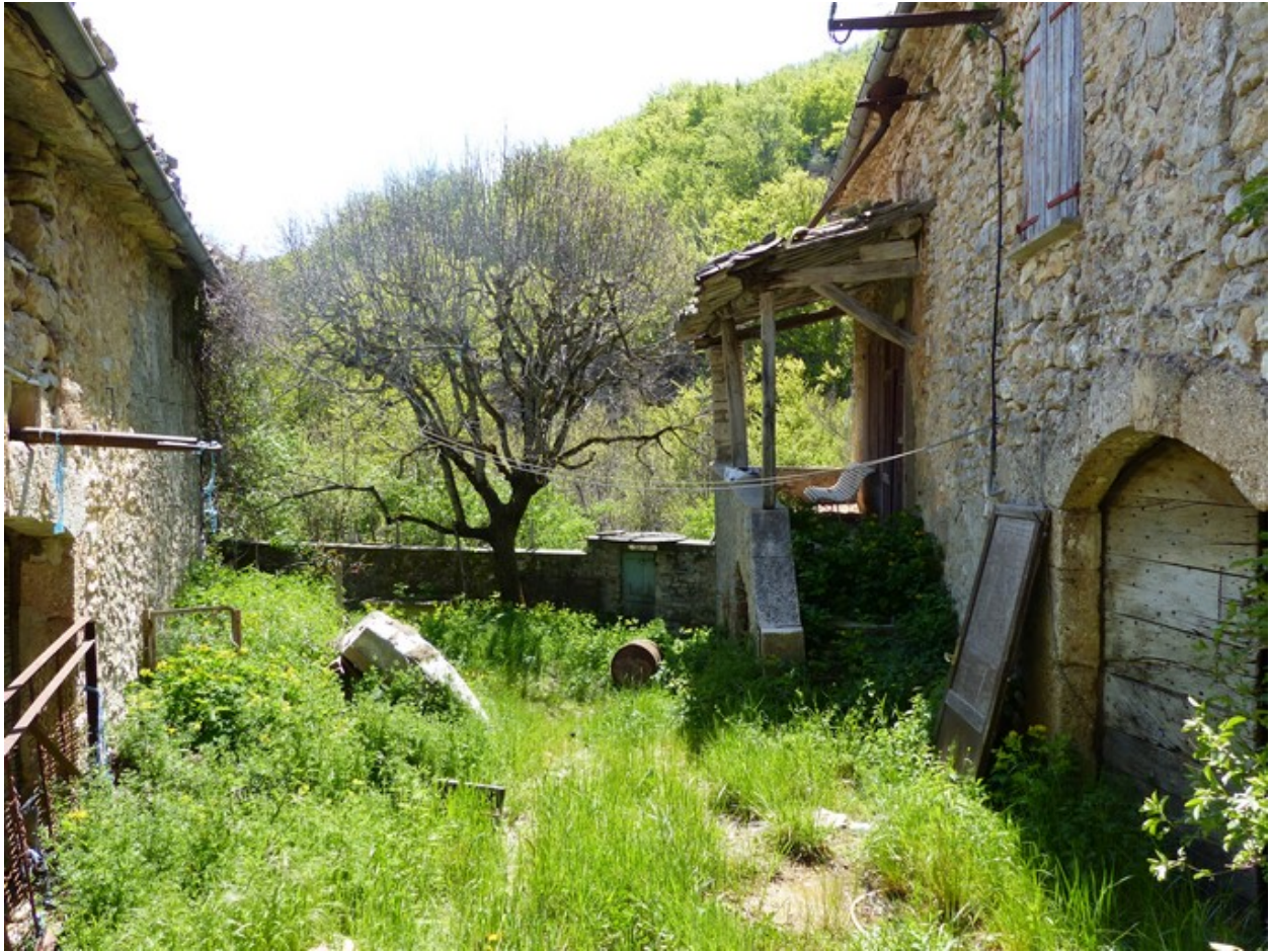
Cour, vue d'ensemble prise du nord.
