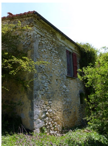
Ensemble occidental. Elévation ouest, partie nord. Phot. Alexeï Laurent IVR84_20162600766NUCA
