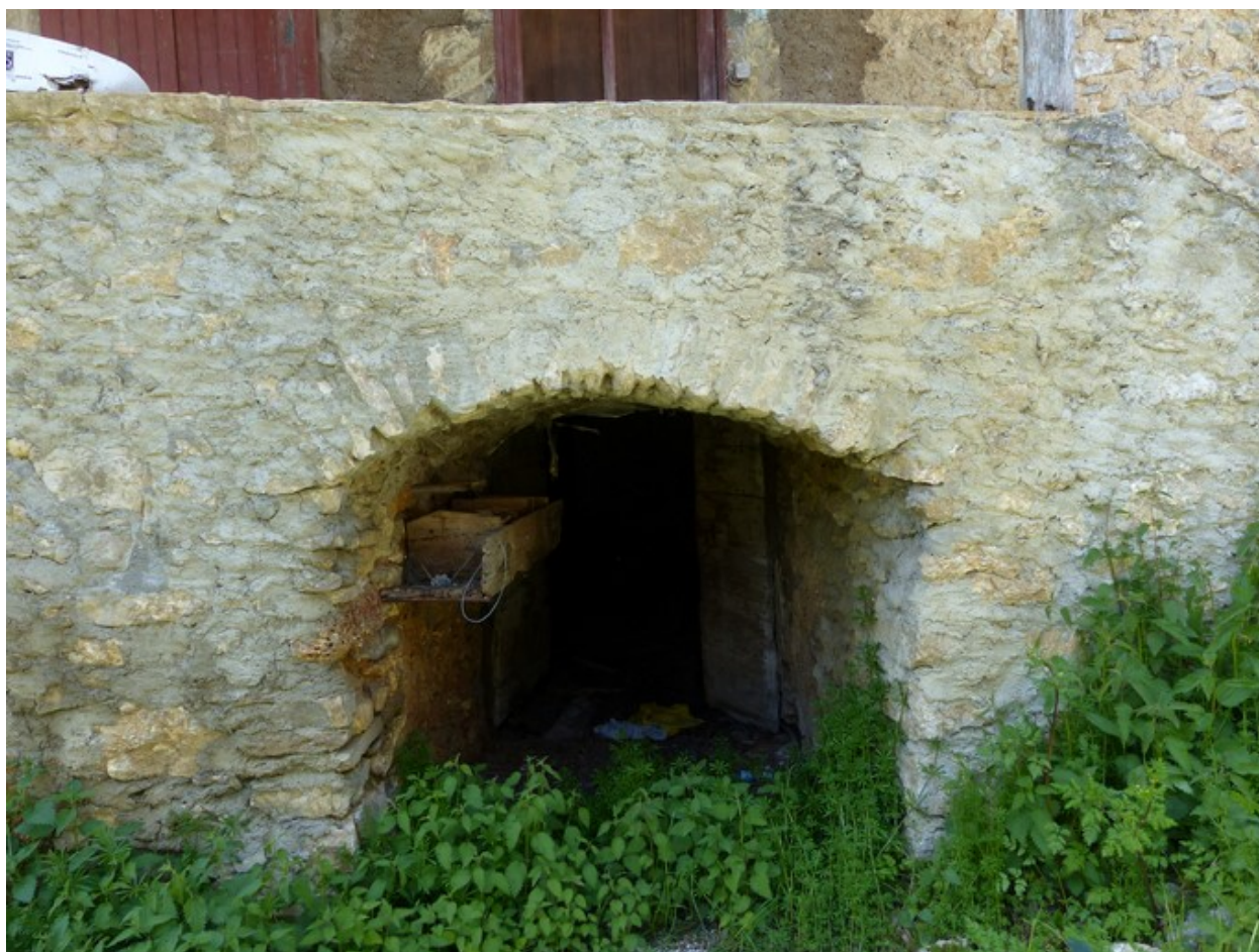
Ensemble occidental. Elévation est, passage voûté sous le palier filant.
