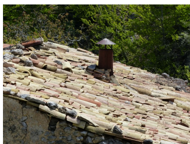
Ensemble oriental. Couverture en tuile creuse. Phot. Alexeï Laurent IVR84_20162600777NUCA
