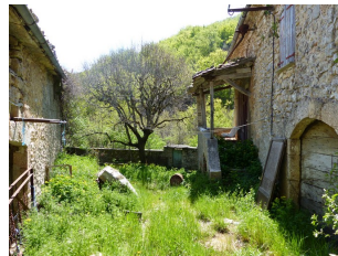
Cour, vue d'ensemble prise du nord.
