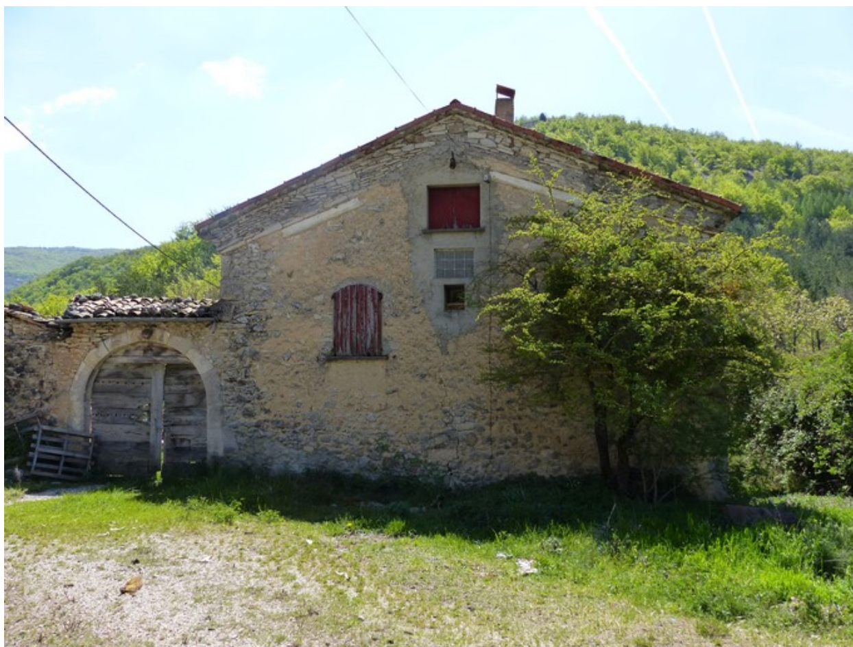
Ensemble occidental. Pignon nord.
