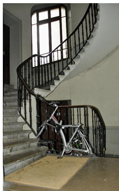
Vue intérieure : la cage d'escalier Phot. Magali Delavenne IVR82_20146902906NUCA
