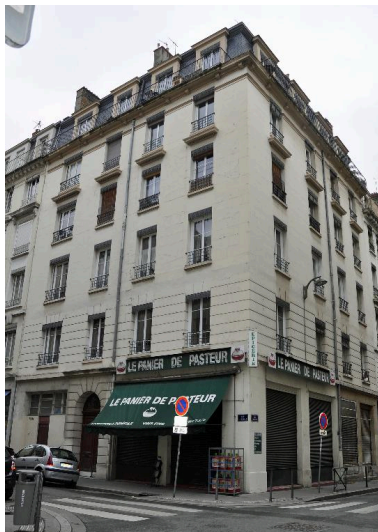
Vue d'ensemble Phot. Magali Delavenne IVR82_20146902902NUCA
