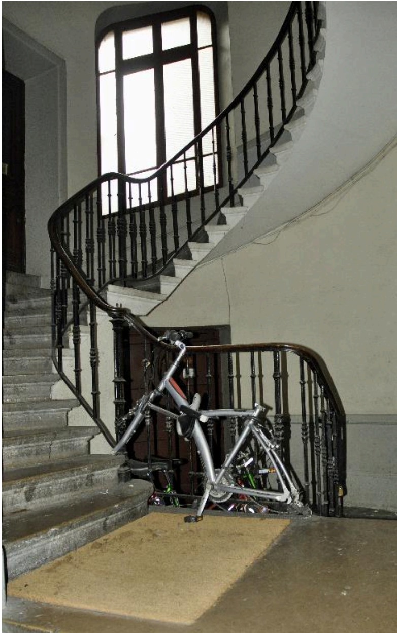
Vue intérieure : la cage d'escalier
