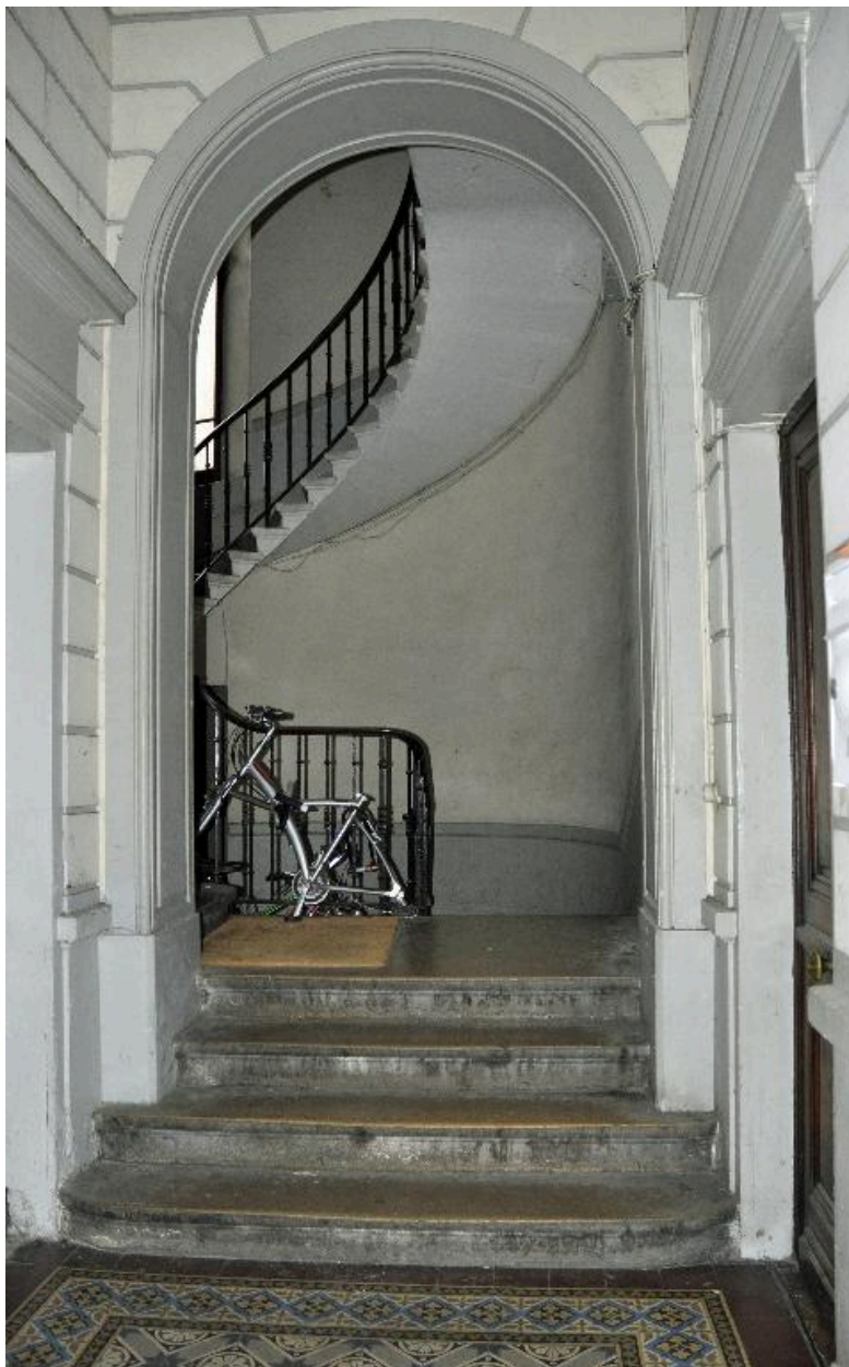
Vue intérieure : emmarchement au départ de l'escalier
