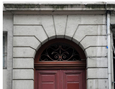
Elévation sur la rue de Bonald : détail de l'imposte Phot. Magali Delavenne IVR82_20146902903NUCA
