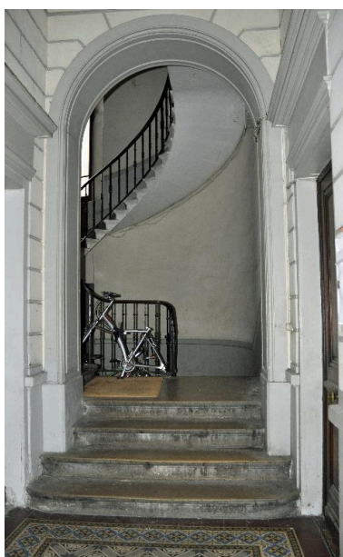
Vue intérieure : emmarchement au départ de l'escalier Phot. Magali Delavenne IVR82_20146902905NUCA
