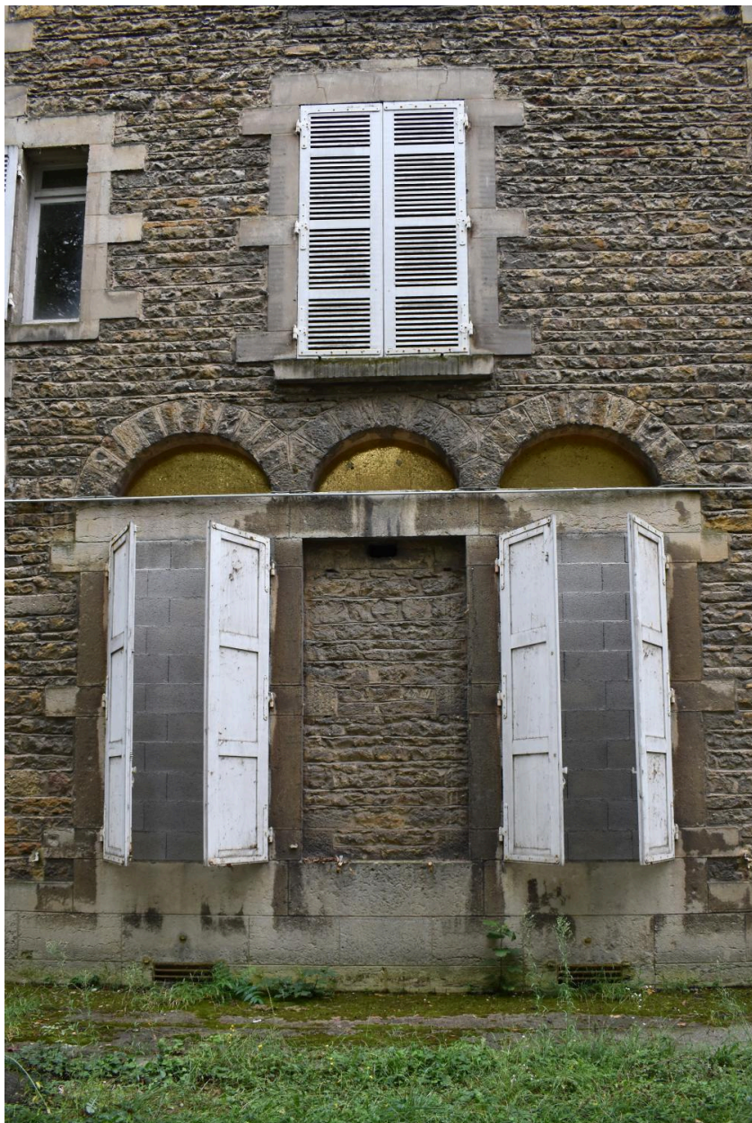
Elévation antérieure : détail d'une travée ; baie jumelée triple avec tympan portant un décor de mosaïque à fond d'or
