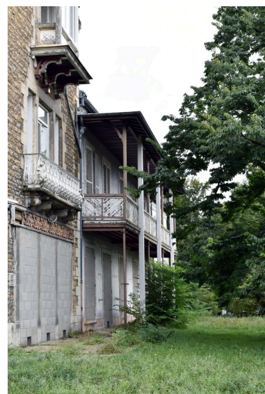
Elévation postérieure, vue d'ensemble depuis le sud Phot. Catherine Guégan IVR84_20246901102NUCA
