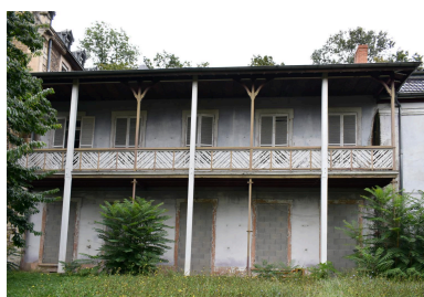
Elévation postérieure : galerie en charpente métallique avec
