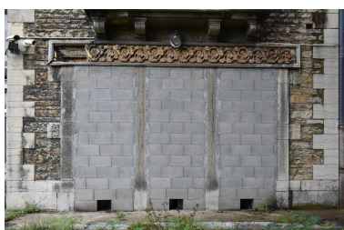
Elévation postérieure : baie jumelée triple (aujourd'hui murée) avec décor de céramique sur le linteau
