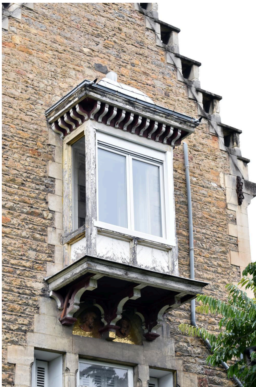
Elévation postérieure : oriel sur le mur pignon, au 2e étage
