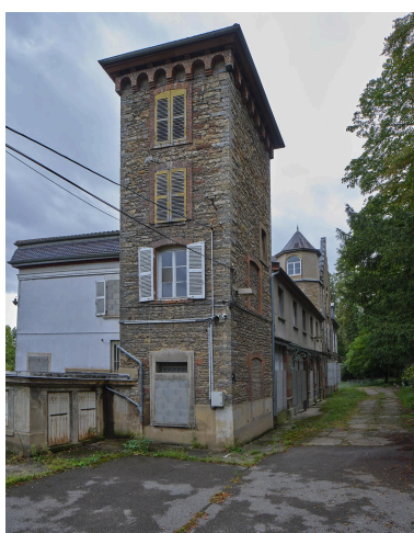
Elévation antérieure, depuis le nord Phot. Franck Trabouillet IVR84_20246901078NUCA
