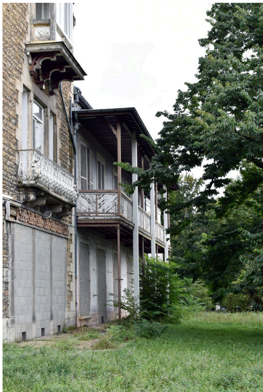
Elévation postérieure, vue d'ensemble depuis le sud
