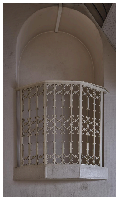
Vestibule : balconnet ménagé dans une baie (aujourd'hui murée) percée dans la première volée de l'escalier en vis Phot. Franck Trabouillet IVR84_20246901084NUCA
