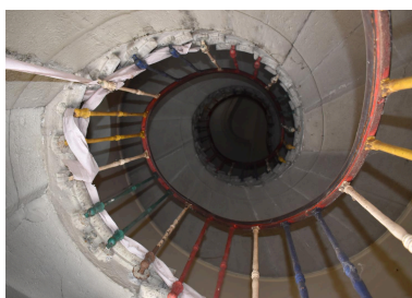
Escalier en vis dans la tour octogonale Phot. Catherine Guégan IVR84_20246901099NUCA
