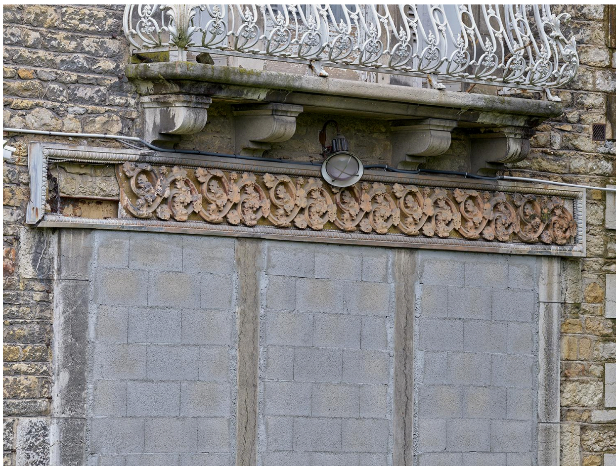
Elévation postérieure, baie jumelée triple : décor en relief de terre cuite sur mosaïque à fond d'or ornant le linteau
