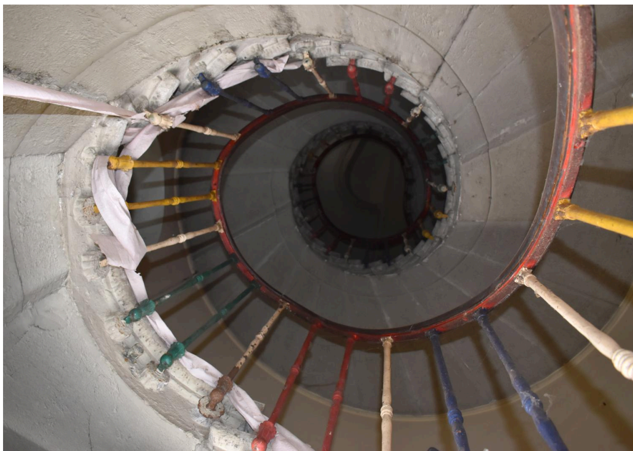
Escalier en vis dans la tour octogonale
