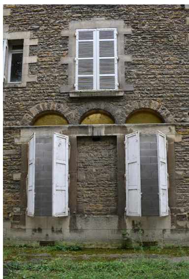
Elévation antérieure : détail d'une travée ; baie jumelée triple avec tympan portant un décor de mosaïque à fond d'or Phot. Catherine Guégan IVR84_20246901093NUCA
