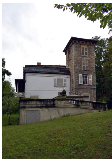
Elévation latérale nord-est et terrasse avec balustrade Phot. Catherine Guégan IVR84_20246901096NUCA
