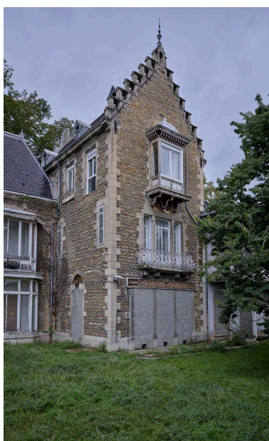
Détail du corps de bâtiment avec mur pignon à redents Phot. Franck Trabouillet IVR84_20246901081NUCA
