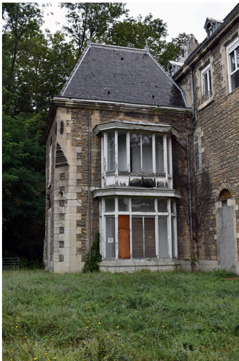
Pavillon sud, vue d'ensemble depuis le sud-est
