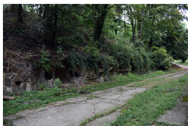
Allée longeant l'élévation antérieure avec mur de soutènement et grottes maçonnées Phot. Catherine Guégan IVR84_20246901088NUCA
