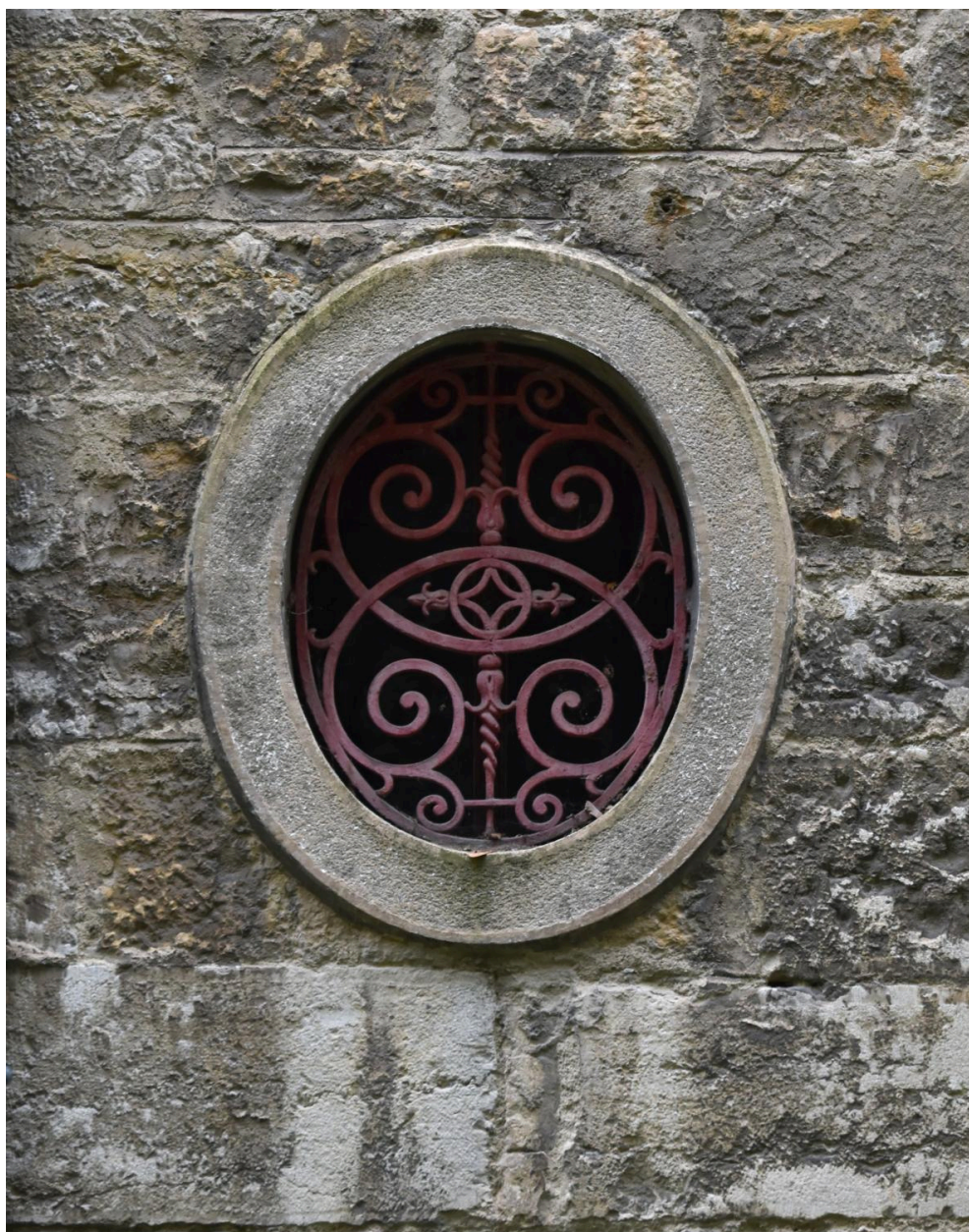
Elévation antérieure : détail de l'oculus éclairant la cage de l'escalier en vis au rez-de-chaussée
