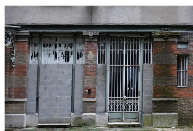
Elévation antérieure : portes de l'entrée principale, linteau ipn supporté par des piliers en brique avec chapiteaux en pierre de taille Phot. Catherine Guégan IVR84_20246901095NUCA
