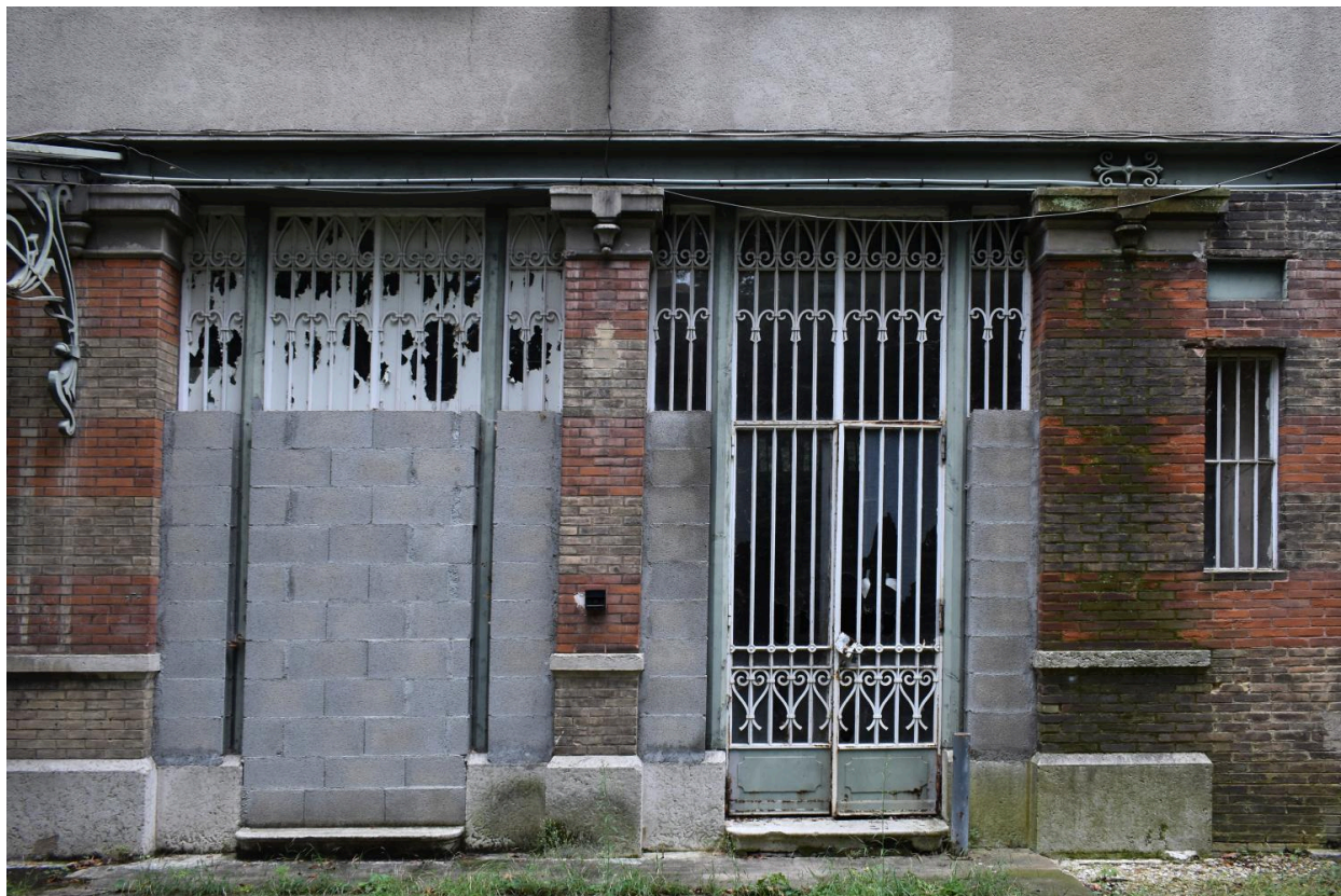
Elévation antérieure : portes de l'entrée principale, linteau ipn supporté par des piliers en brique avec chapiteaux en pierre de taille
