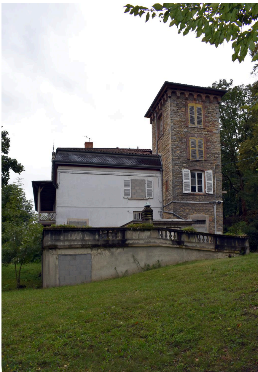
Elévation latérale nord-est et terrasse avec balustrade
