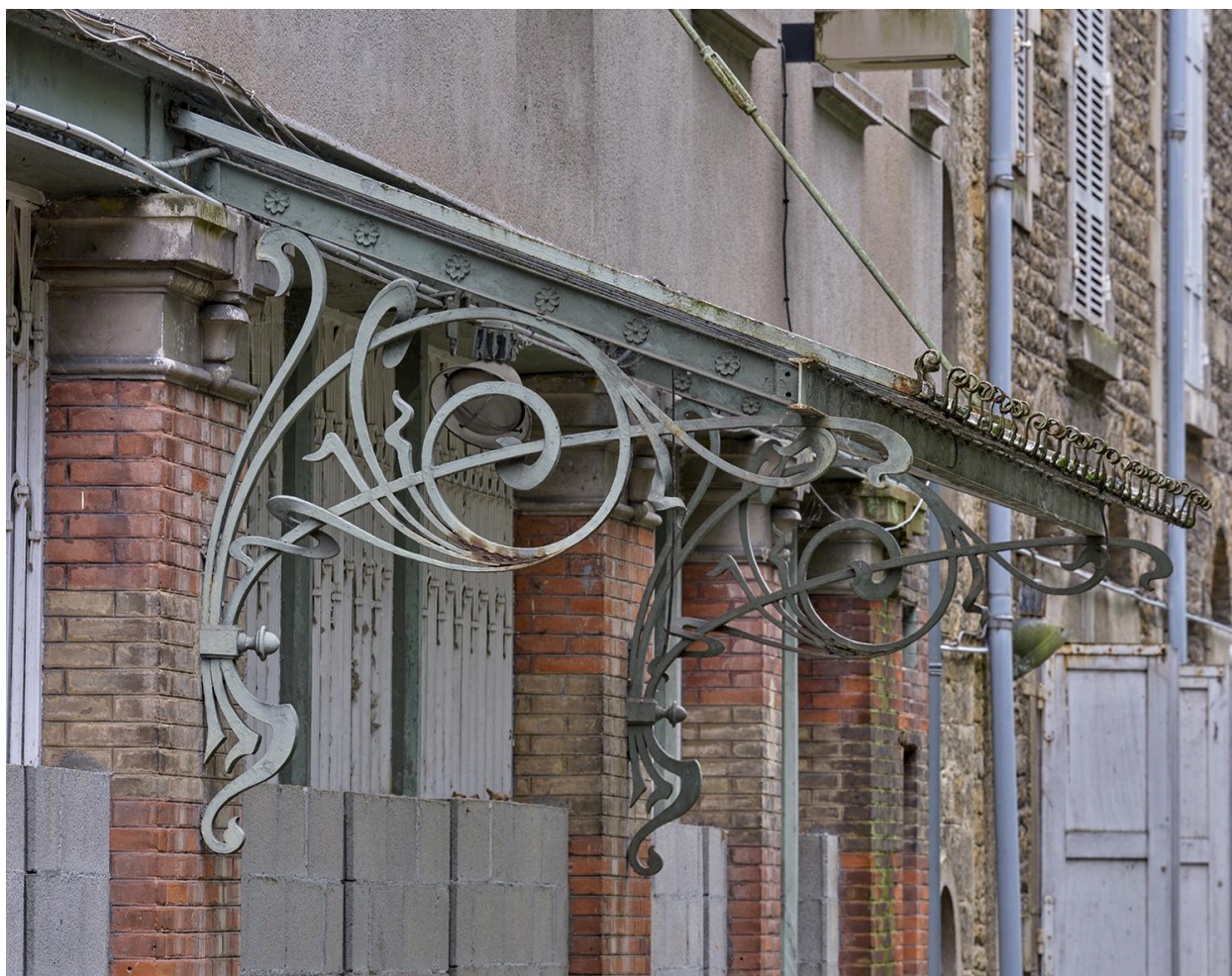
Elévation antérieure : détail de la marquise de style Art Nouveau
