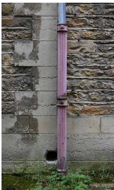
Elévation antérieure : détail d'une descente d'eaux pluviales en fonte Phot. Catherine Guégan IVR84_20246901094NUCA
