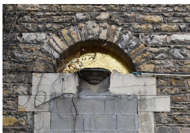
Elévation latérale sud-ouest : détail de la baie du rez-de-chaussée avec applique sur le linteau et tympan avec mosaïque à fond d'or Phot. Catherine Guégan IVR84_20246901098NUCA
