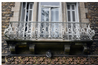
Elévation postérieure : balcon du 1er étage Phot. Catherine Guégan IVR84_20246901101NUCA
