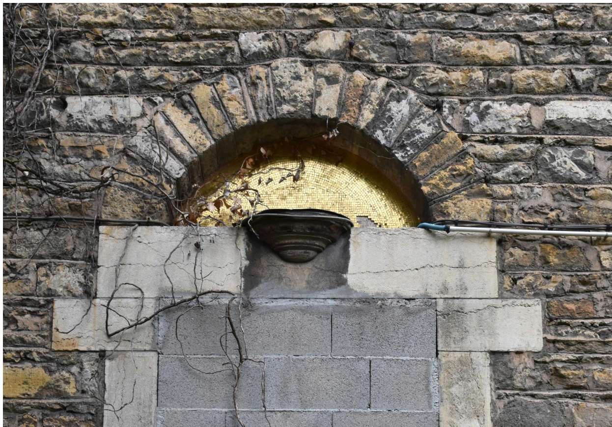
Elévation latérale sud-ouest : détail de la baie du rez-de-chaussée avec applique sur le linteau et tympan avec mosaïque à fond d'or
