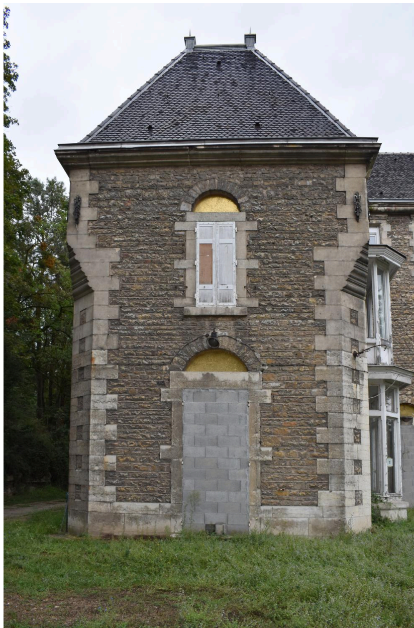
Elévation latérale sud-ouest, détail du pavillon sud
