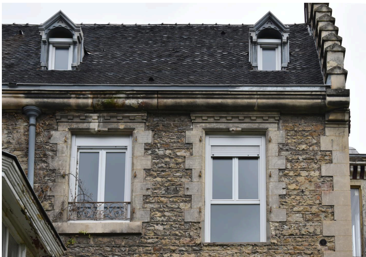
Elévation latérale sud-ouest : baies du 2e étage et toit
