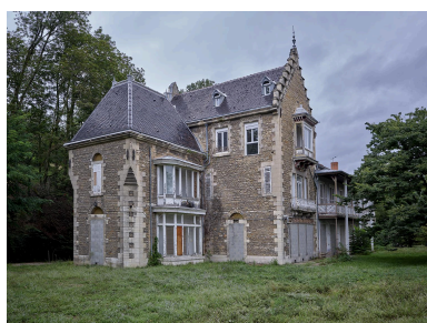
Vue d'ensemble depuis le sud Phot. Franck Trabouillet IVR84_20246901080NUCA
