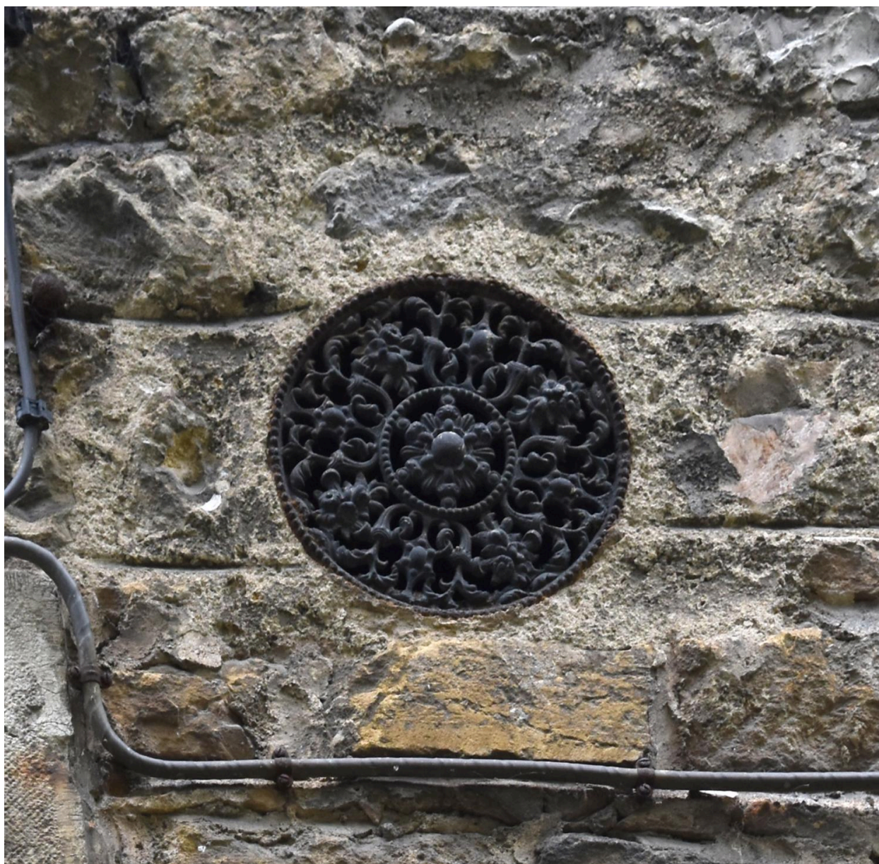
Elévation antérieure : grille de ventilation en fonte
