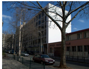
Elévation antérieure depuis le sud-ouest Phot. Maryannick Chalabi IVR82_20116904982NUCA
