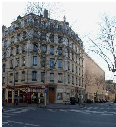
Vue générale depuis le nord Phot. Maryannick Chalabi IVR82_20116904980NUCA
