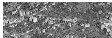
Boulevard Aristide-Briand en 1951 Repro. Félicie Fougère , Autr. auteur inconnu IVR84_20256300819NUC
