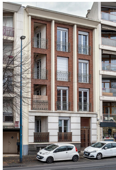
Façade sur le boulevard Aristide-Briand Phot. Michel Pérès IVR84_20256302557NUCA
