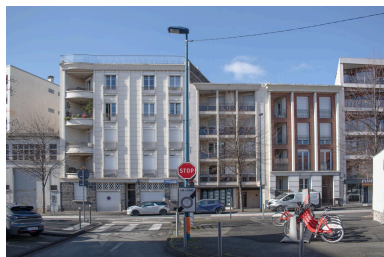
Façades sur le boulevard Aristide-Briand Phot. Félicie Fougère IVR84_20256302374NUCA
