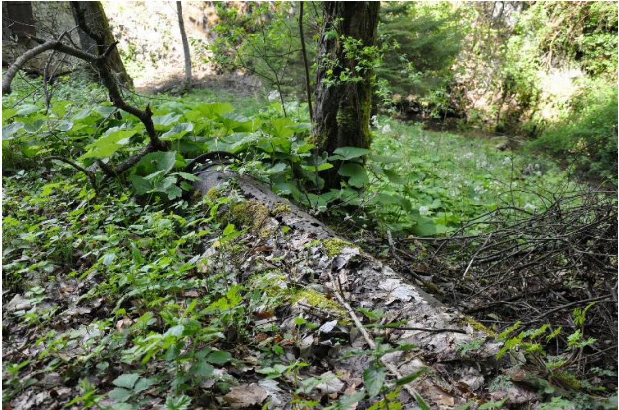
Tronçon de conduite métallique qui alimentait la roue.
