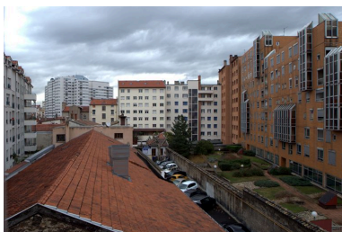
Élévation postérieure depuis le sud
