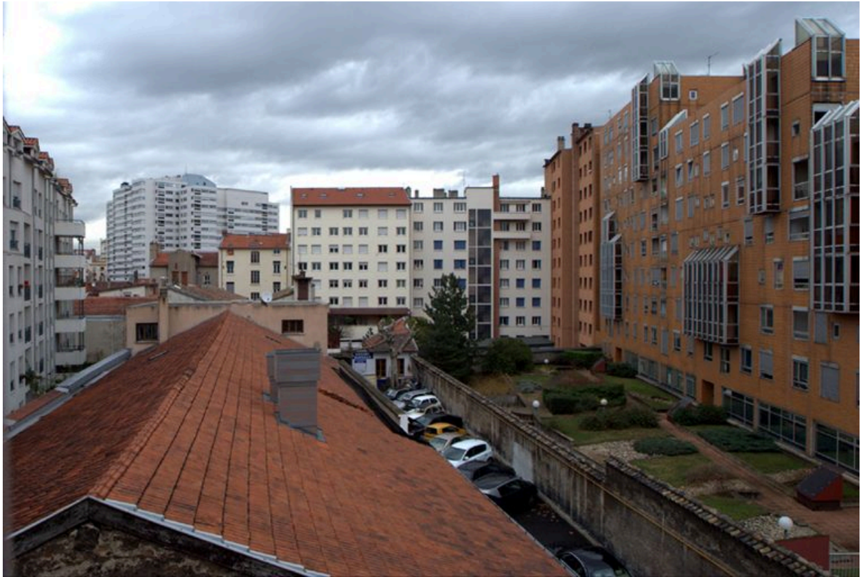
Elévation postérieure depuis le sud
