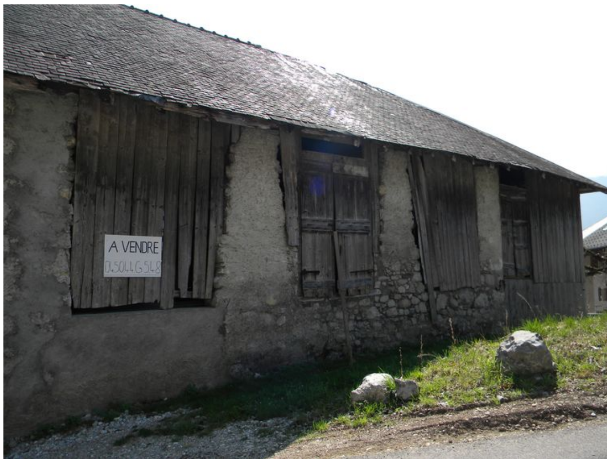
Vue de la façade arrière.
