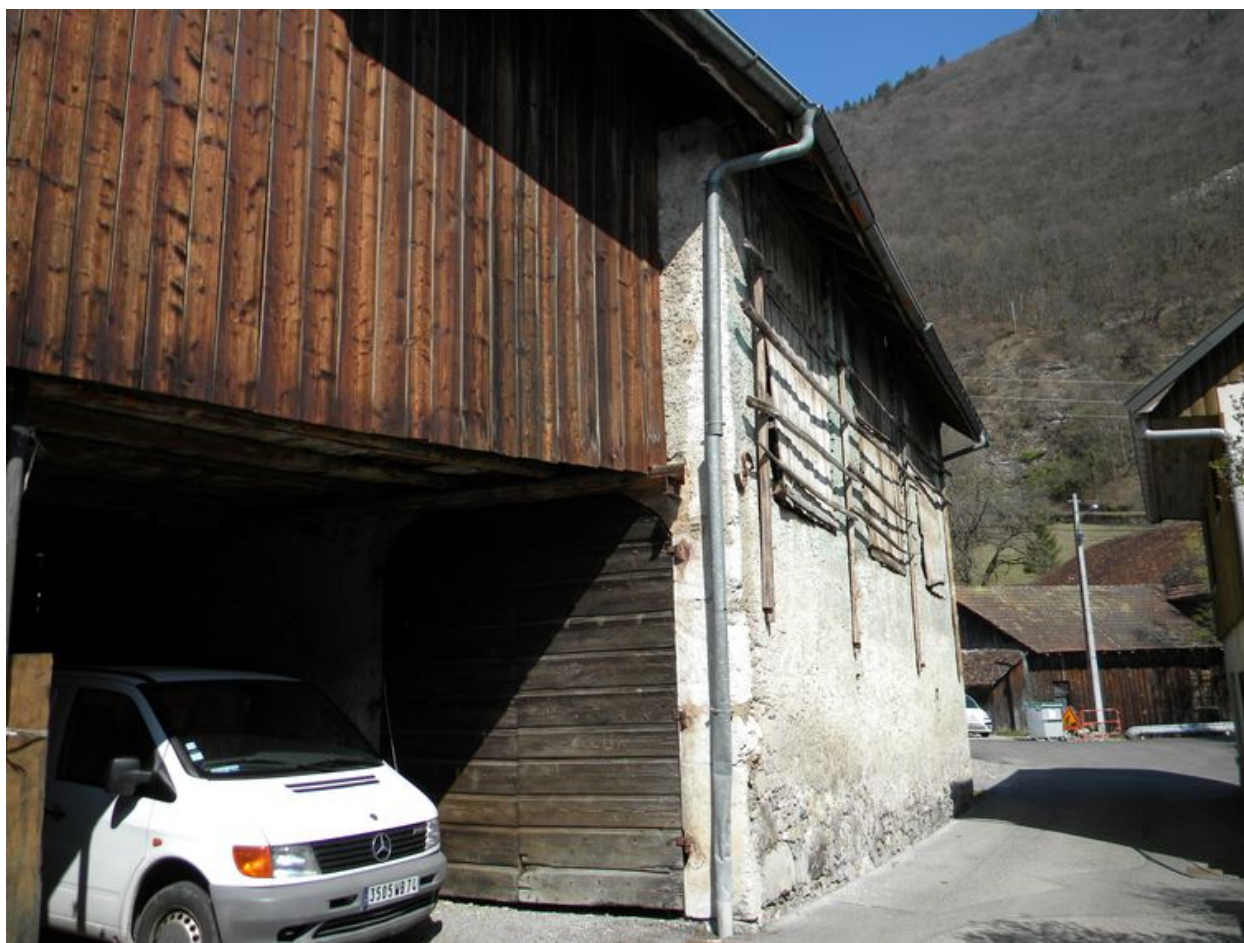
Pignon sud-ouest avec extension en bois.
