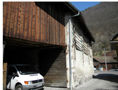
Pignon sud-ouest avec extension en bois. Phot. Jérôme Daviet IVR82_20127400983NUCA
