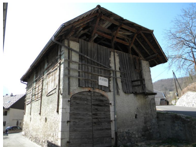
Vue générale Phot. Jérôme Daviet IVR82_20127400950NUCA
