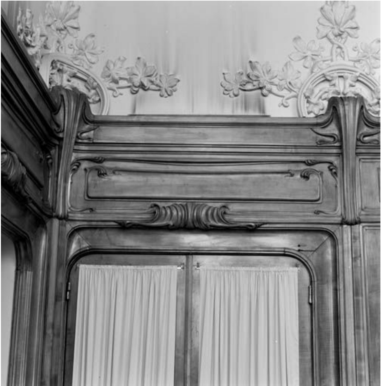
Dessus de porte et détail du plafond
