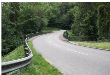
Pont de Vaulx, vue de la chaussée Phot. Pascale Renard IVR84_20207403181NUCA
