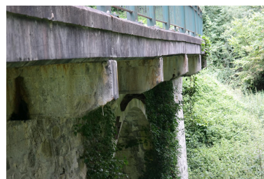
Pont de Vaulx, détail de l'élargissement en béton Phot. Pascale Renard IVR84_20207403182NUCA
