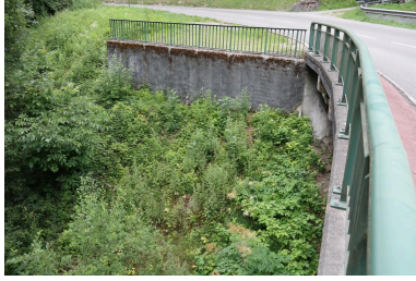
Pont de Vaulx, détail de la réfécion du talus Phot. Pascale Renard IVR84_20207403994NUCA
