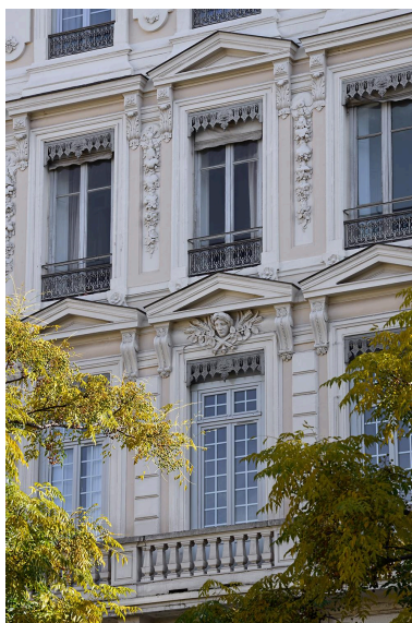
Travées centrales des 1er et 2e étages carrés Phot. Thierry Leroy IVR84_20256901940NUCAQ
