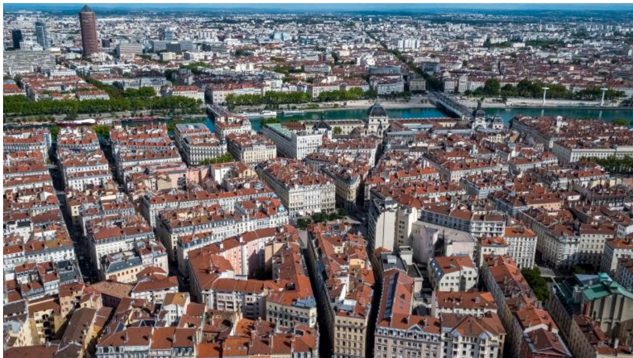
Vue aérienne depuis l'ouest
