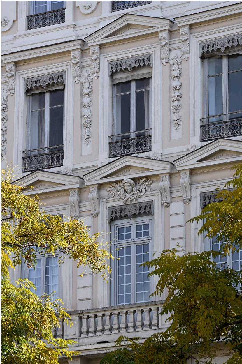
Travées centrales des 1er et 2e étages carrés
