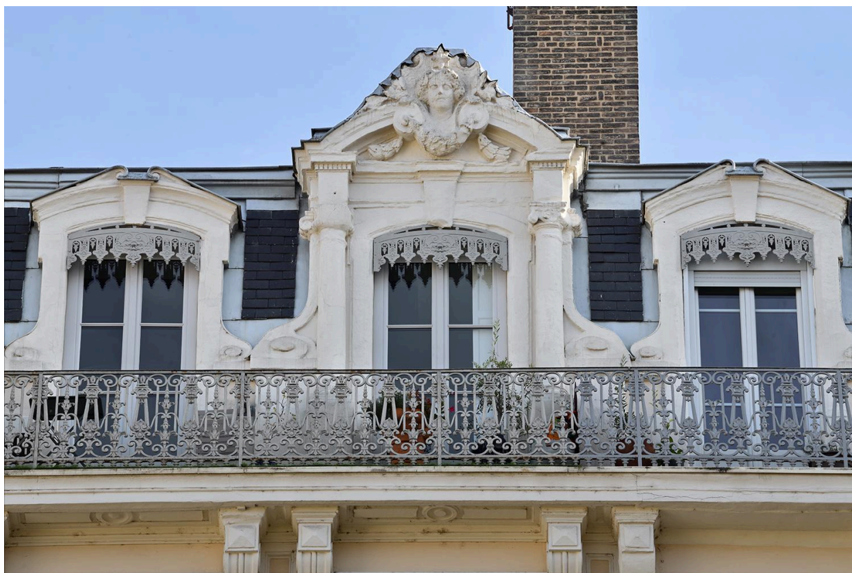
Travées axiales de l'étage de comble
