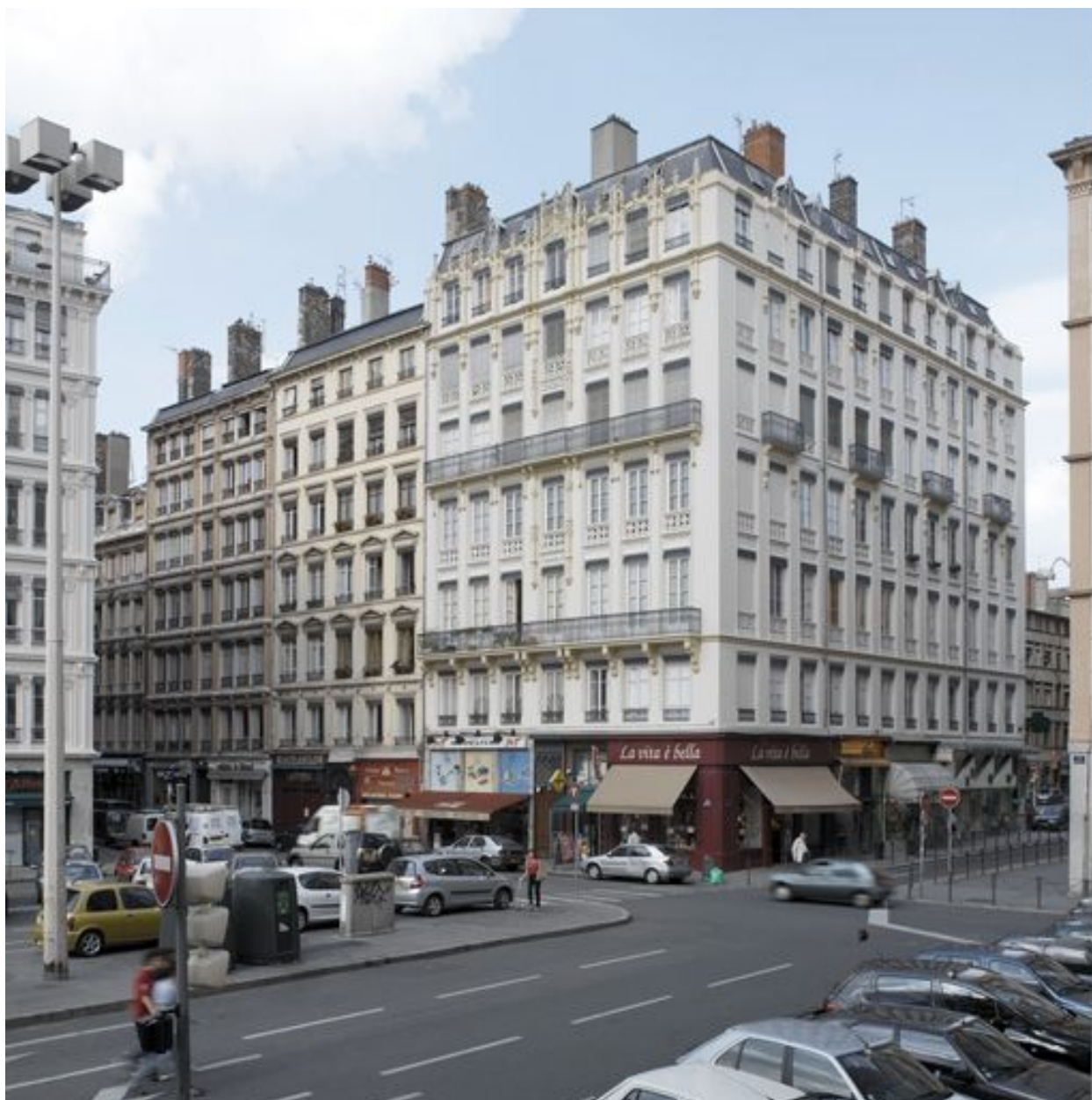
Vue générale de situation
