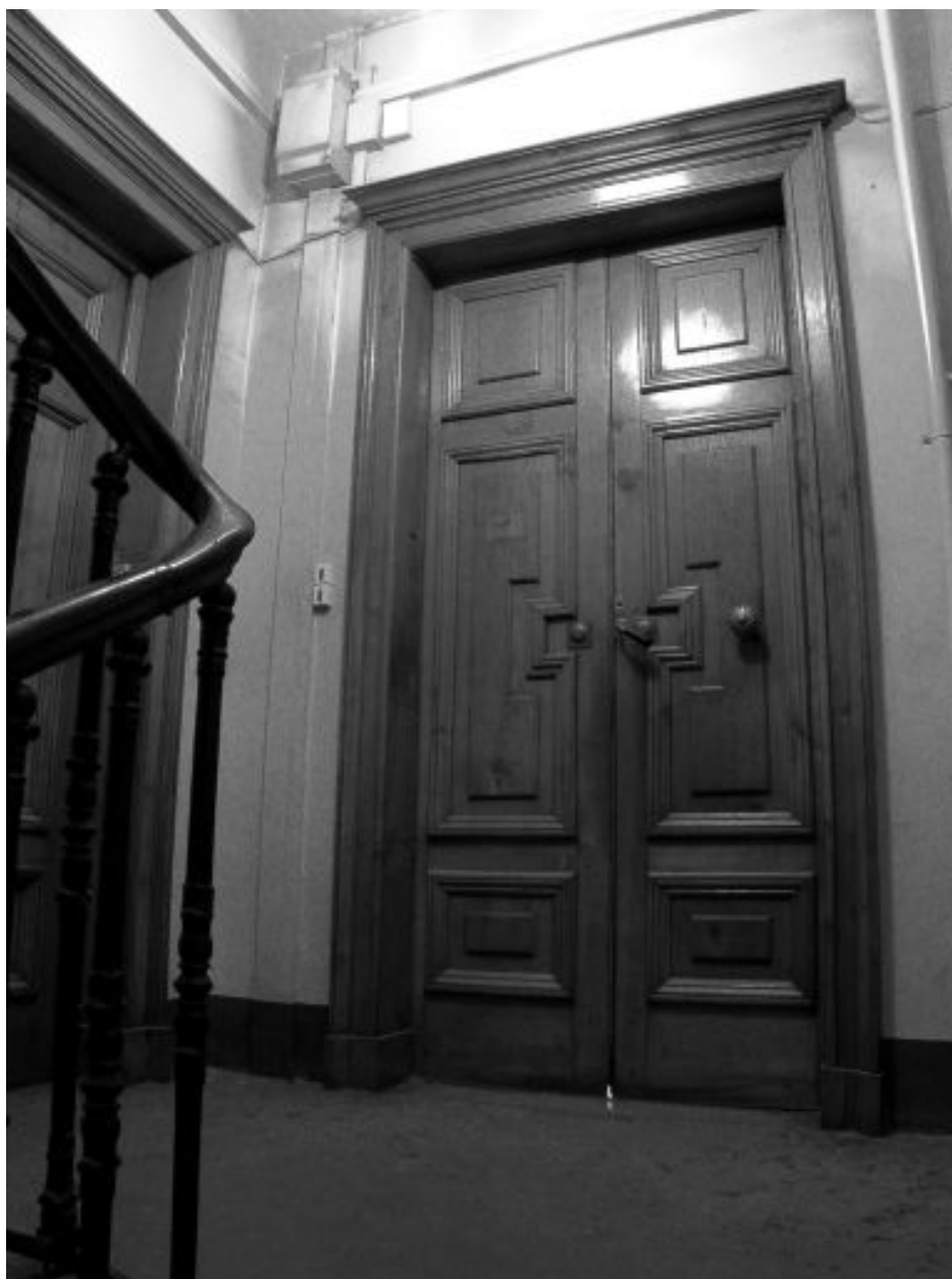
Escalier, palier du 1er étage
