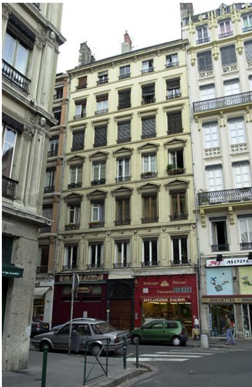
Vue générale de la façade principale
