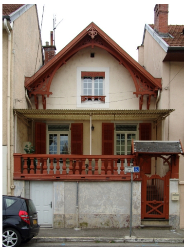
Façade sur rue Phot. François Fouger IVR82_20077300309NUCA
