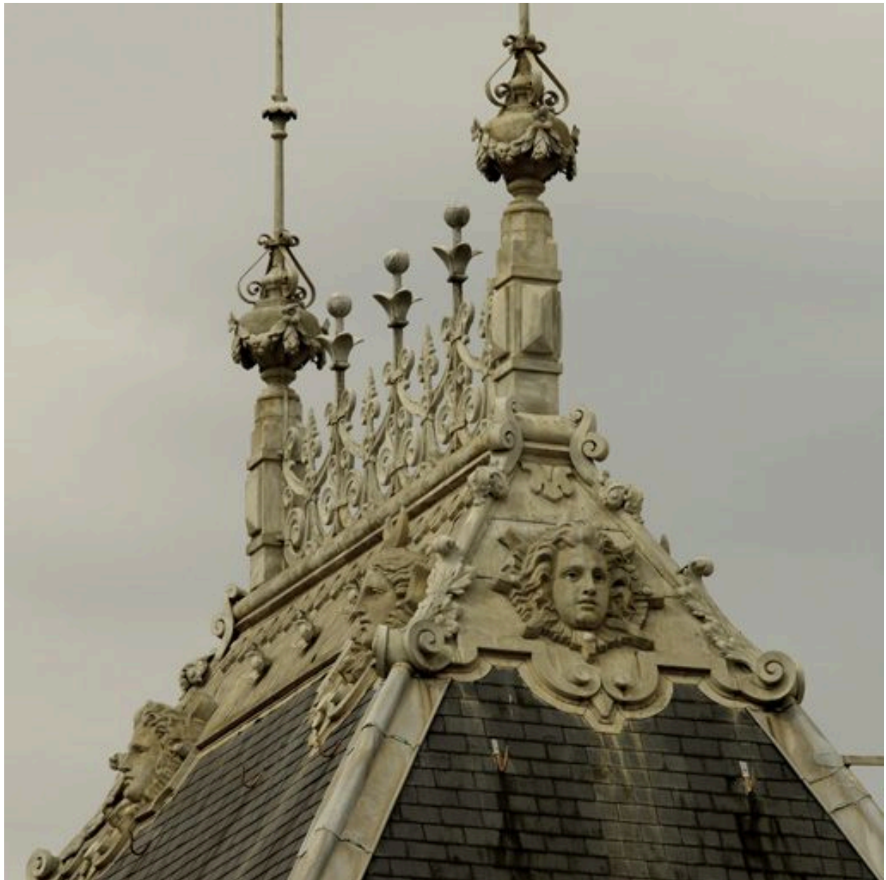
Détail de la toiture du pavillon d'angle oriental (épi de faitage et crête) depuis le toit du Grand Bazar
