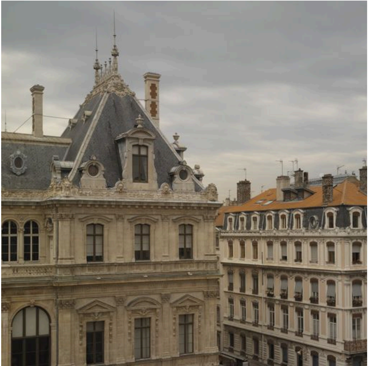
Détail du pavillon d'angle oriental depuis le toit du Grand Bazar
