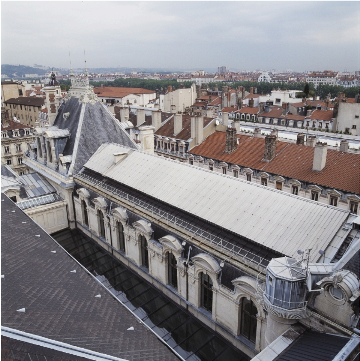
Vue des toits côté nord-est et du corps de bâtiment est, depuis le campanile
