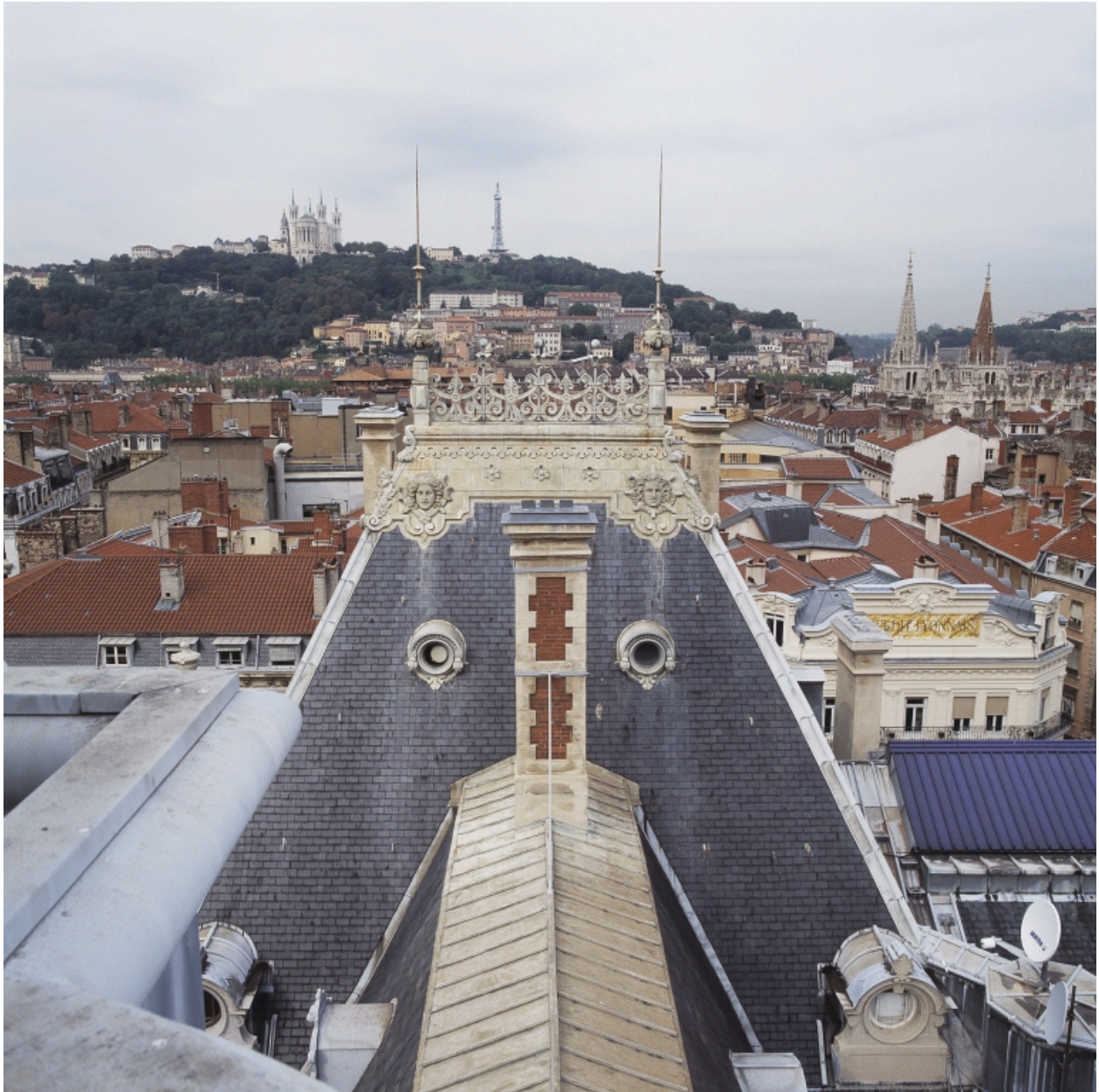
Vue des toits côté ouest, depuis le campanile
