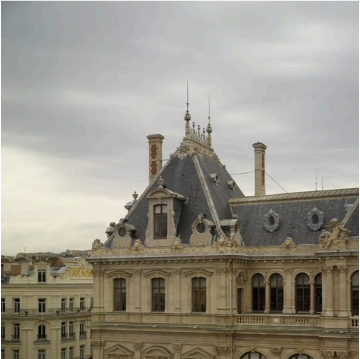
Détail du pavillon d'angle occidental depuis le toit du Grand Bazar
