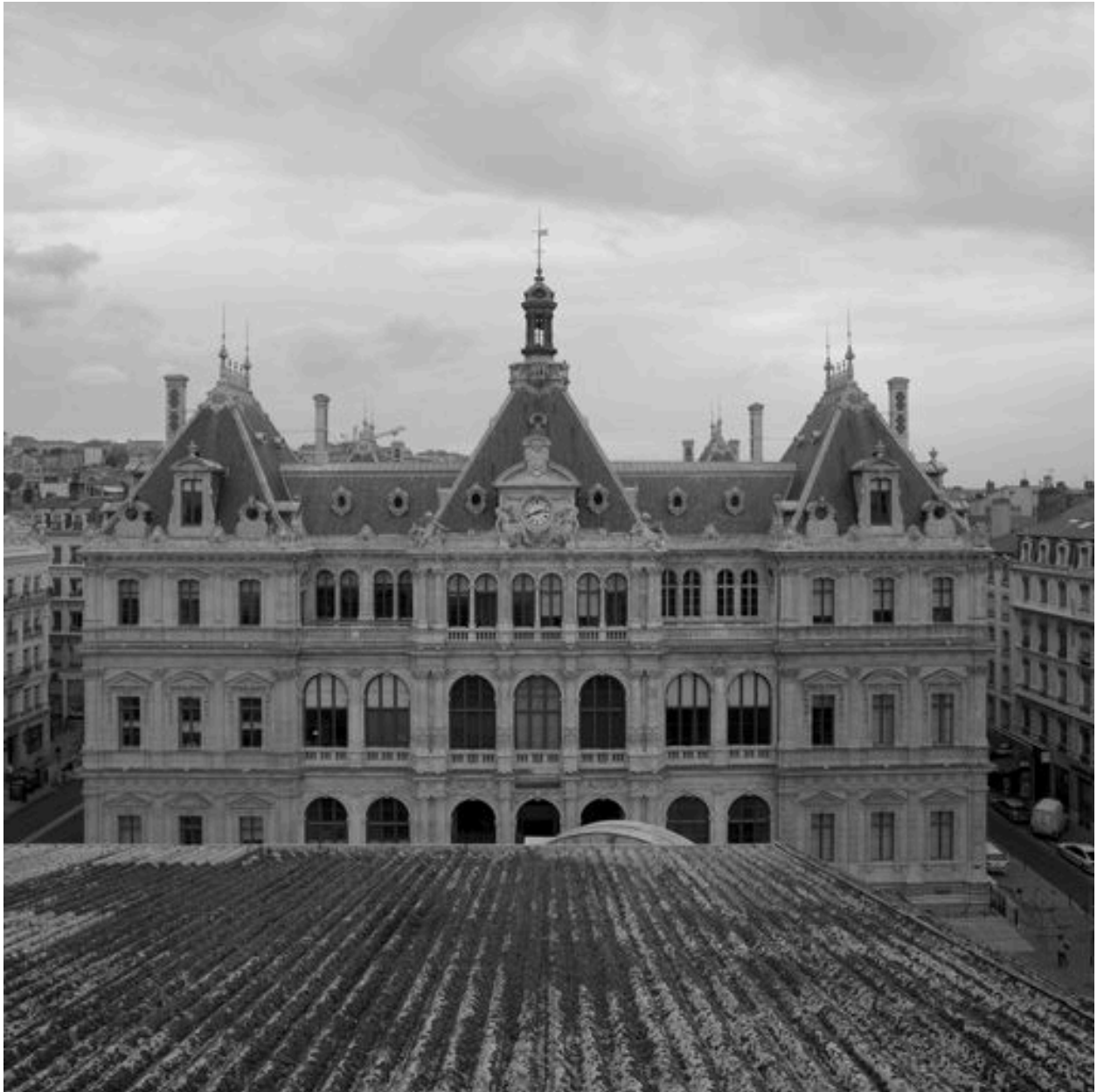
Vue d'ensemble depuis le toit du Grand Bazar
