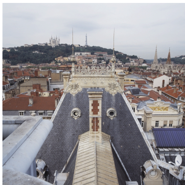
Vue des toits côté ouest, depuis le campanile Phot. Eric Dessert IVR82_20046901179XA
