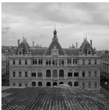
Vue d'ensemble depuis le toit du Grand Bazar Phot. Eric Dessert IVR82_20046901118NUC
