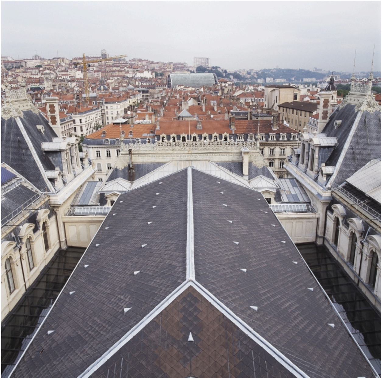
Vue des toits côté nord, depuis le campanile
