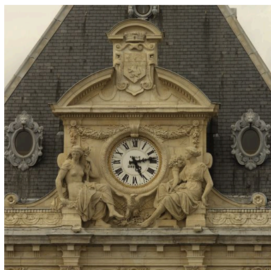
Détail du pavillon central (partie centrale), depuis le toit du Grand Bazar Phot. Eric Dessert IVR82_20046901110NUCA
