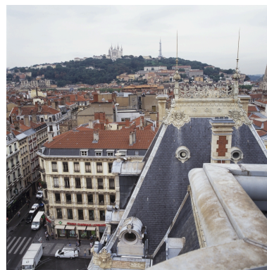
Vue des toits côté ouest-sud-ouest, depuis le campanile Phot. Eric Dessert IVR82_20046901177XA
