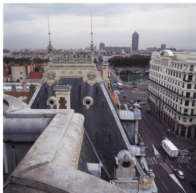
Vue des toits côté est, depuis le campanile Phot. Eric Dessert IVR82_20046901178XA
