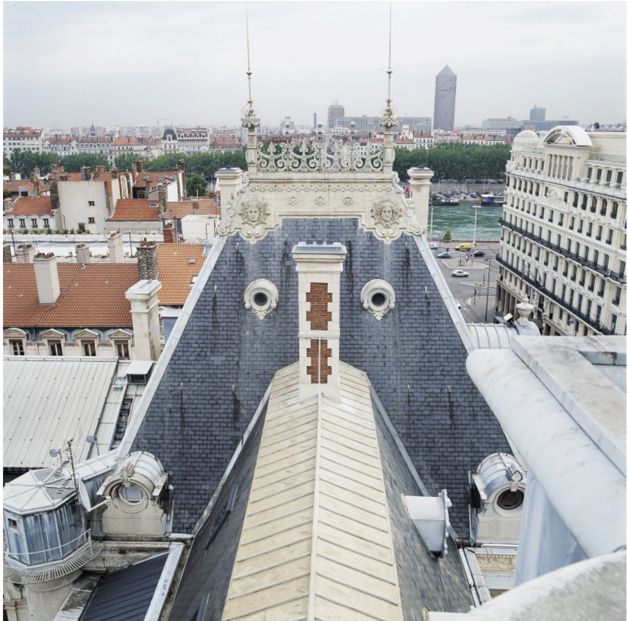
Vue des toits côté est-nord-est, depuis le campanile
