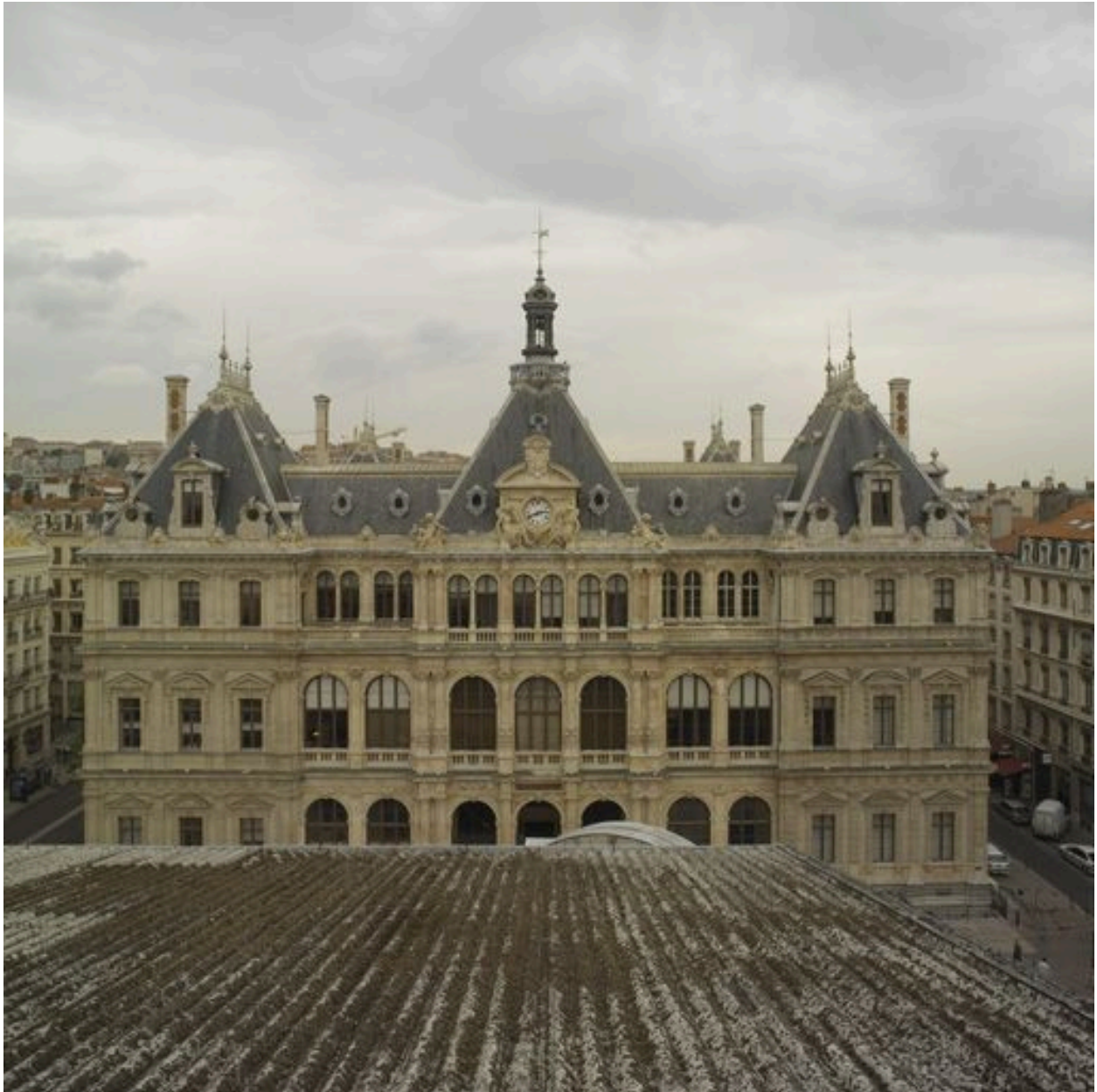
Elévation principale depuis le toit du Grand Bazar
