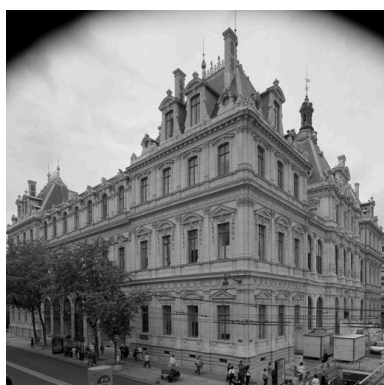
Vue d'ensemble depuis le sud-ouest Phot. Eric Dessert IVR82_20046901117NUC
