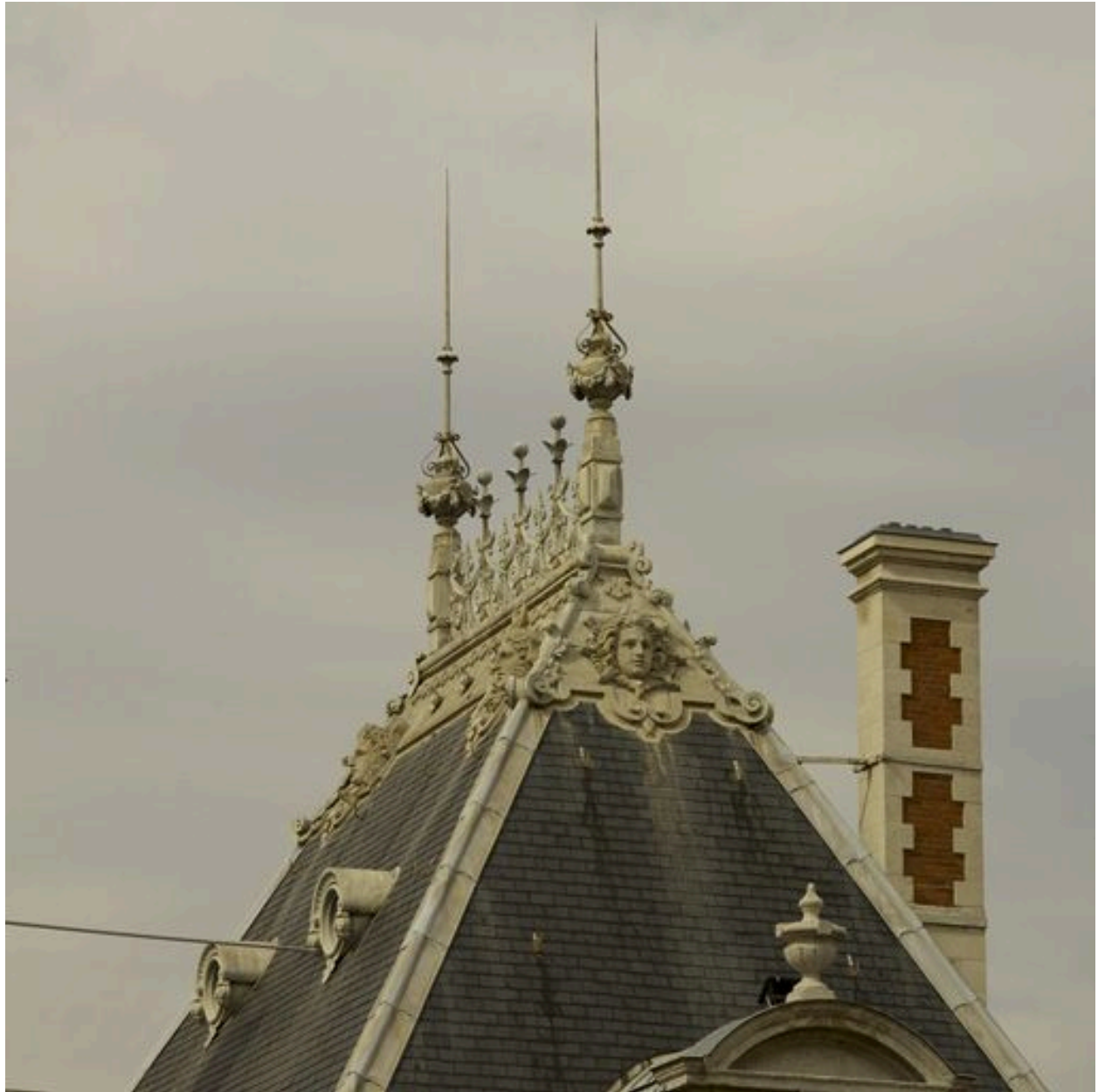
Détail de la toiture du pavillon d'angle oriental depuis le toit du Grand Bazar
