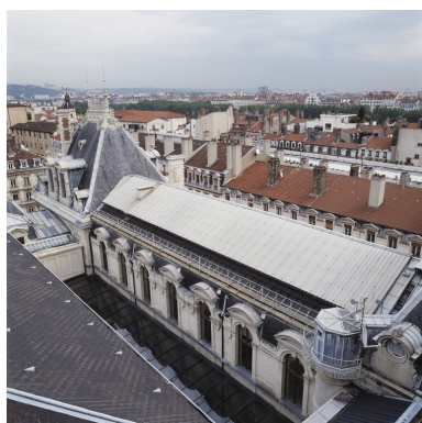
Vue des toits côté nord-est et du corps de bâtiment est, depuis le campanile Phot. Eric Dessert IVR82_20046901182XA
