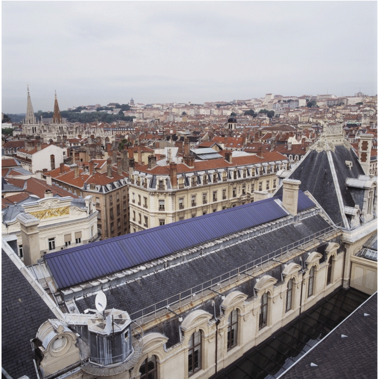
Vue des toits côté ouest-nord-ouest, depuis le campanile
