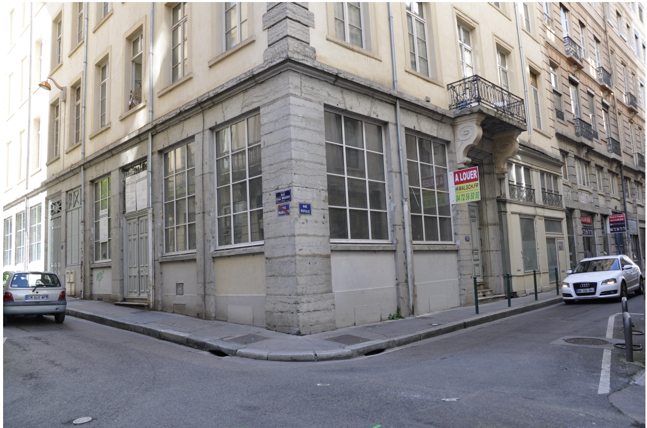
Vue rapprochée sur le rez-de-chaussée, angle rue Brazier et rue Royale
