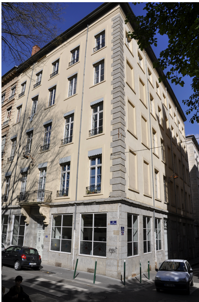
Vue générale depuis la rue d'Alsace-Lorraine
