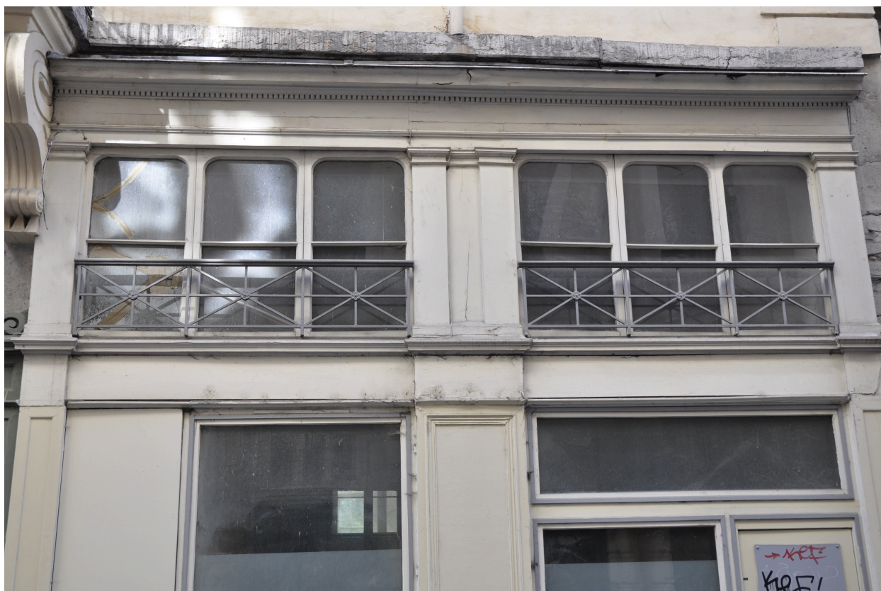
Vue rapprochée sur l'entresol au 10, rue Royale
