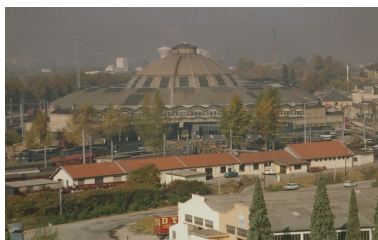
Vue générale Phot. Dominique Peyre IVR82_20087302014NUCA
