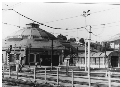
Vue du bâtiment Phot. Dominique Peyre IVR82_20087302013NUC
