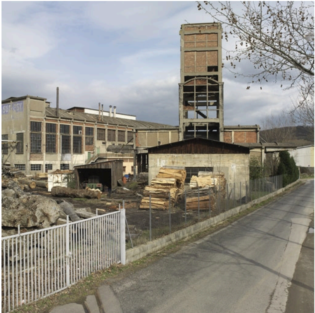
Vue ouest du four
