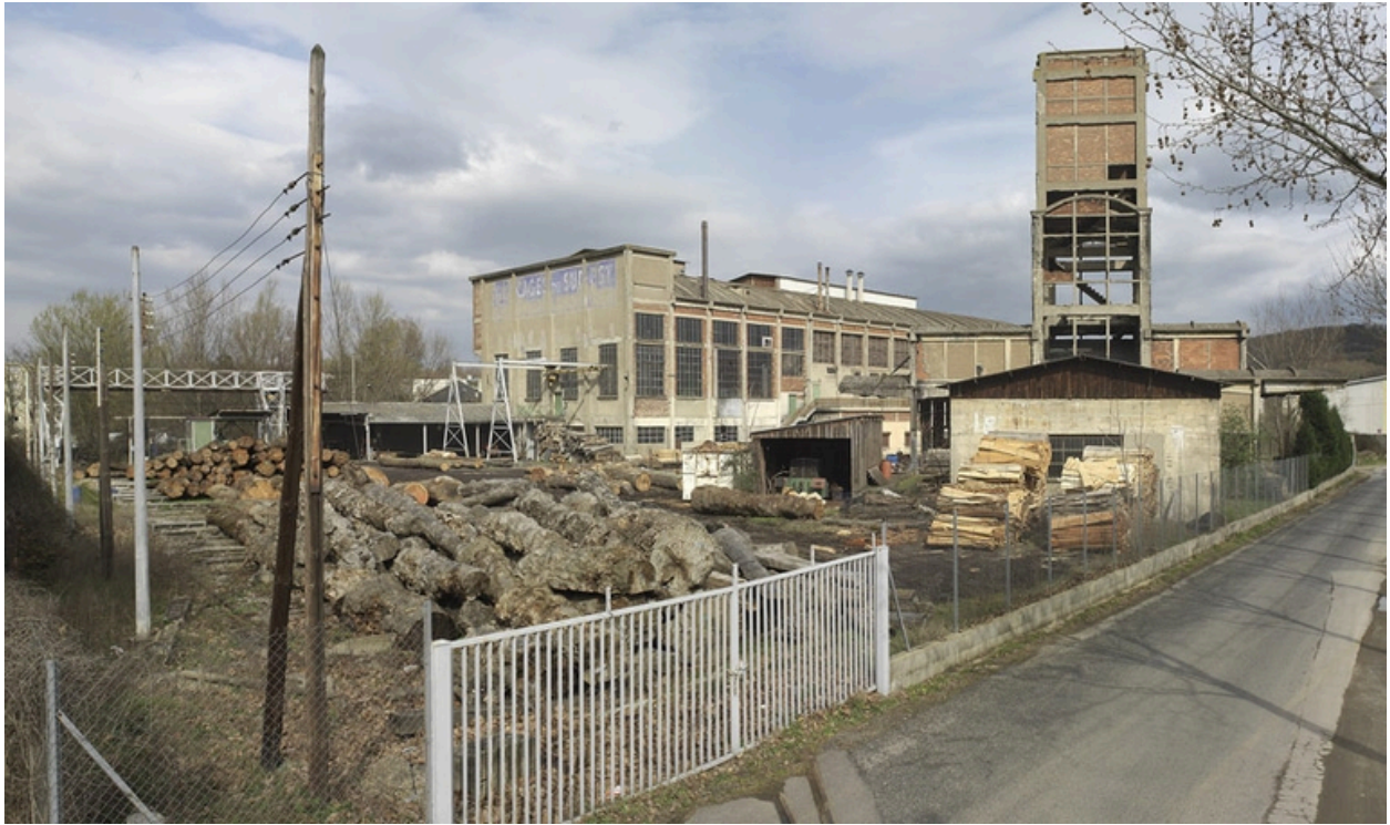
Vue d'ensemble ouest
