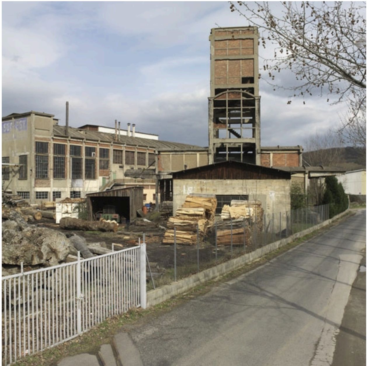
Vue ouest du four
