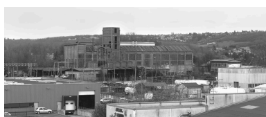
Vue d'ensemble sud-ouest Phot. Didier Gourbin IVR82_20076900892NUC
