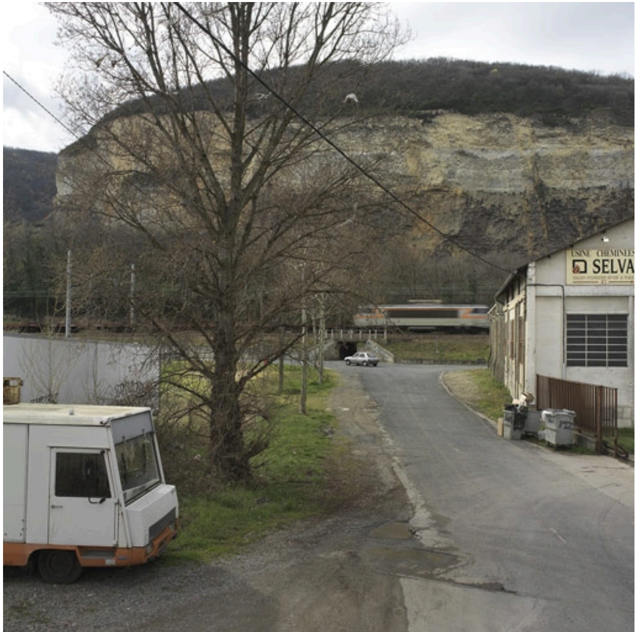
Vue est de la carrière
