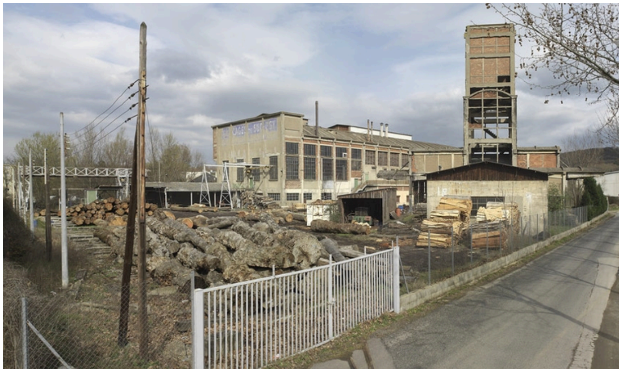
Vue d'ensemble ouest
