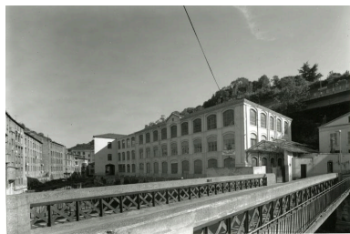
Vue d'ensemble usine Monstre actuellement usine Béal Phot. Jean-Marie Refflé IVR82_19873800591P
