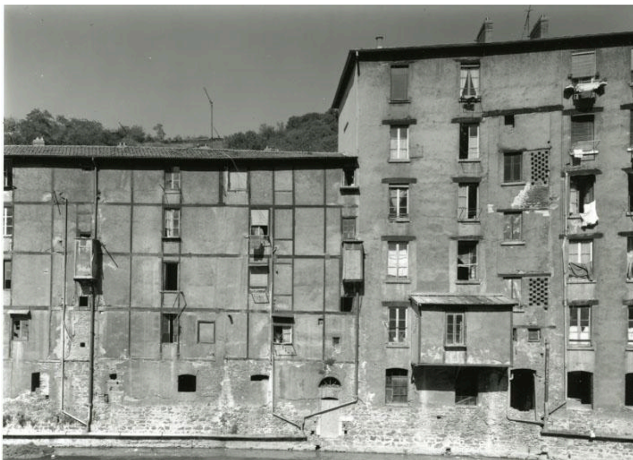
Vue des façades de la vallée de la Gère
