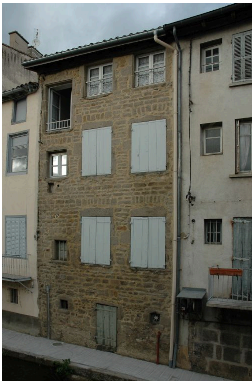
Elévation postérieure donnant sur le quai.
