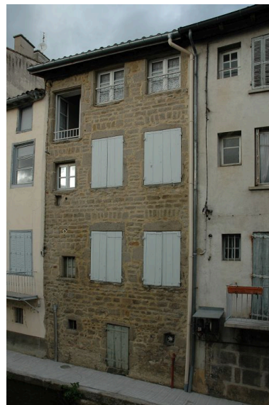
Elévation postérieure donnant sur le quai. Phot. Simone Hartmann-Nussbaum IVR82_20134200532NUCA
