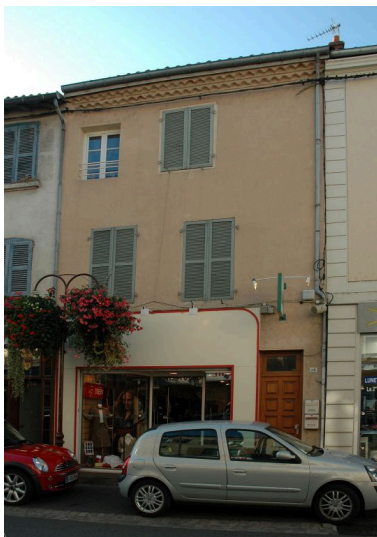
Vue générale sur la rue Tupinerie. Phot. Simone Hartmann-Nussbaum IVR82_20134200531NUCA
