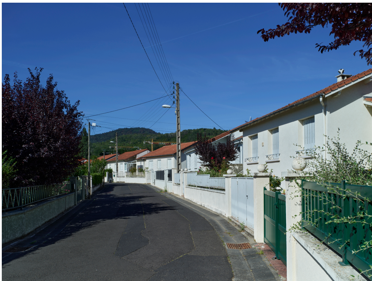
Maisons de la cité sur la rue des Prés-Hauts, depuis le nord-est au niveau du n°8.
