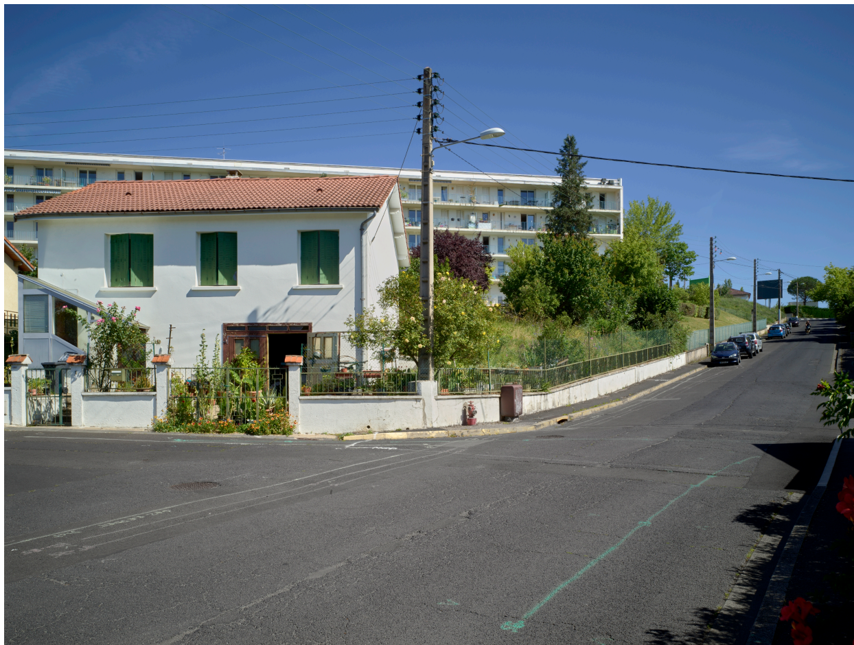
Une des deux maisons à étage, et l'immeuble collectif de la cité des Prés-Hauts, depuis l'avenue du Stade.
