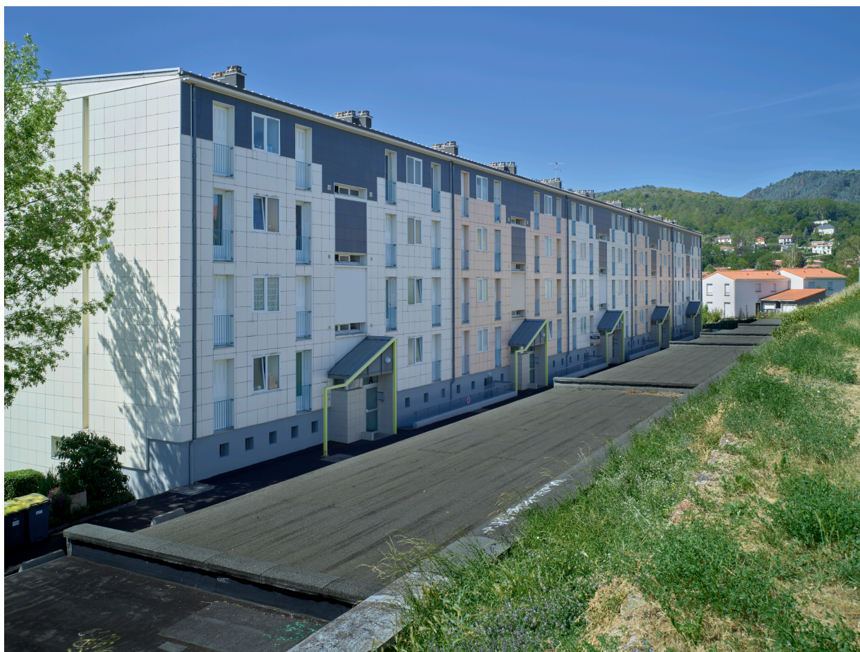
Immeuble collectif de la cité vu depuis le haut (côté des entrées et des garages, au nord).
