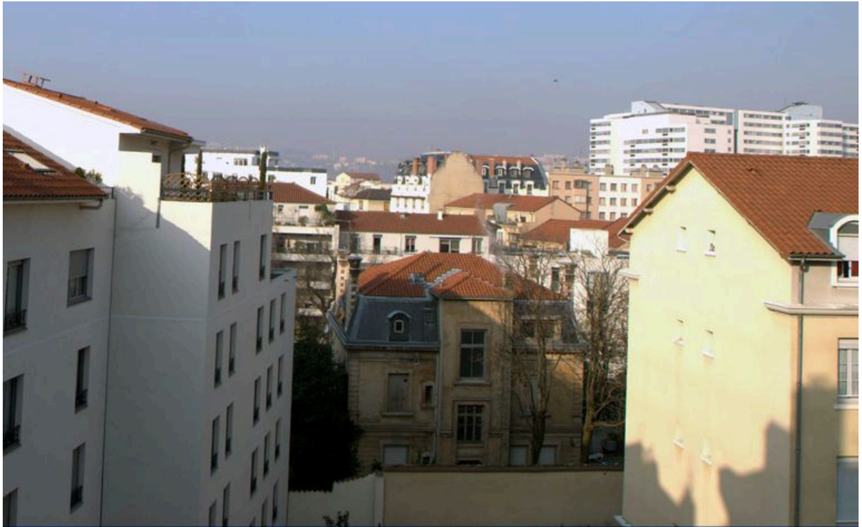
Elévation principale, vue partielle
