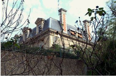
Étage de comble, vue partielle Phot. Maryannick Chalabi IVR82_20106903517NUCA
