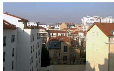
Elévation principale, vue partielle
