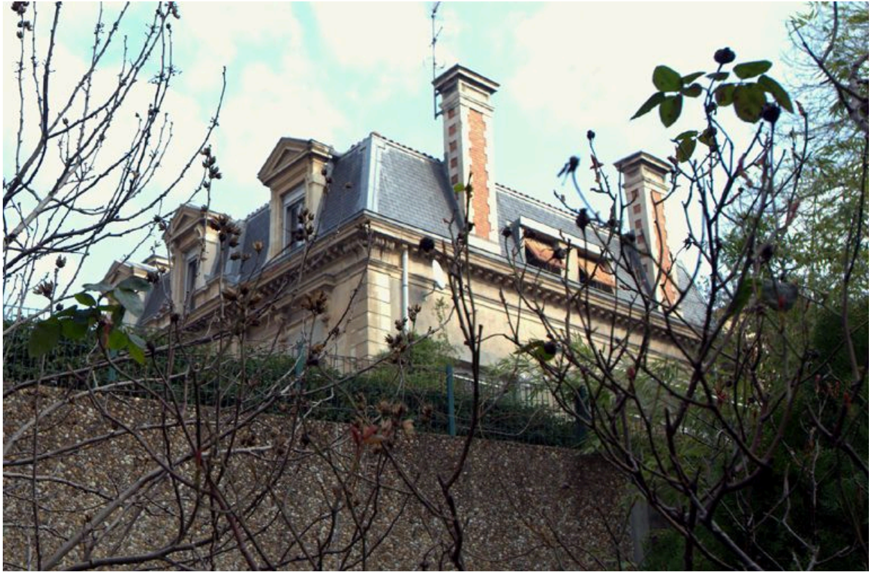
Étage de comble, vue partielle
