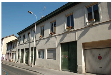
Vue générale. Phot. Catherine Guillot IVR82_20126902760NUCA
