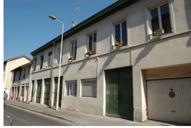
Vue générale. Phot. Catherine Guillot IVR82_20126902760NUCA
