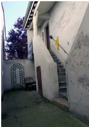
Vue d'ensemble de l'escalier depuis le sud Phot. Maryannick Chalabi IVR82_20116905139NUCA
