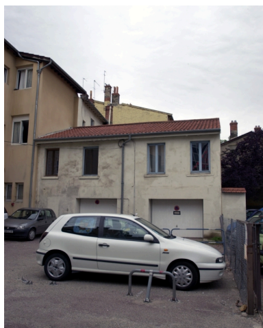
Elévation postérieure, sur la cour de la parcelle AE 136 Phot. Maryannick Chalabi IVR82_20116905031NUCA
