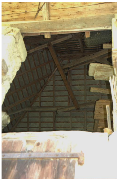
Vue partielle intérieure de la charpente, extrémité est de celle-ci. Phot. Thierry Monnet IVR82_20157302682NUCA
