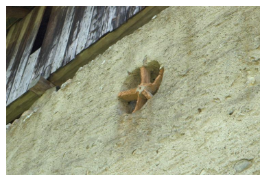
Détail d'une ventilation du fenil, mur pignon est. Phot. Thierry Monnet IVR82_20157302680NUCA
