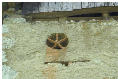
Détail d'une ventilation du fenil, mur pignon est. Phot. Thierry Monnet IVR82_20157302681NUCA
