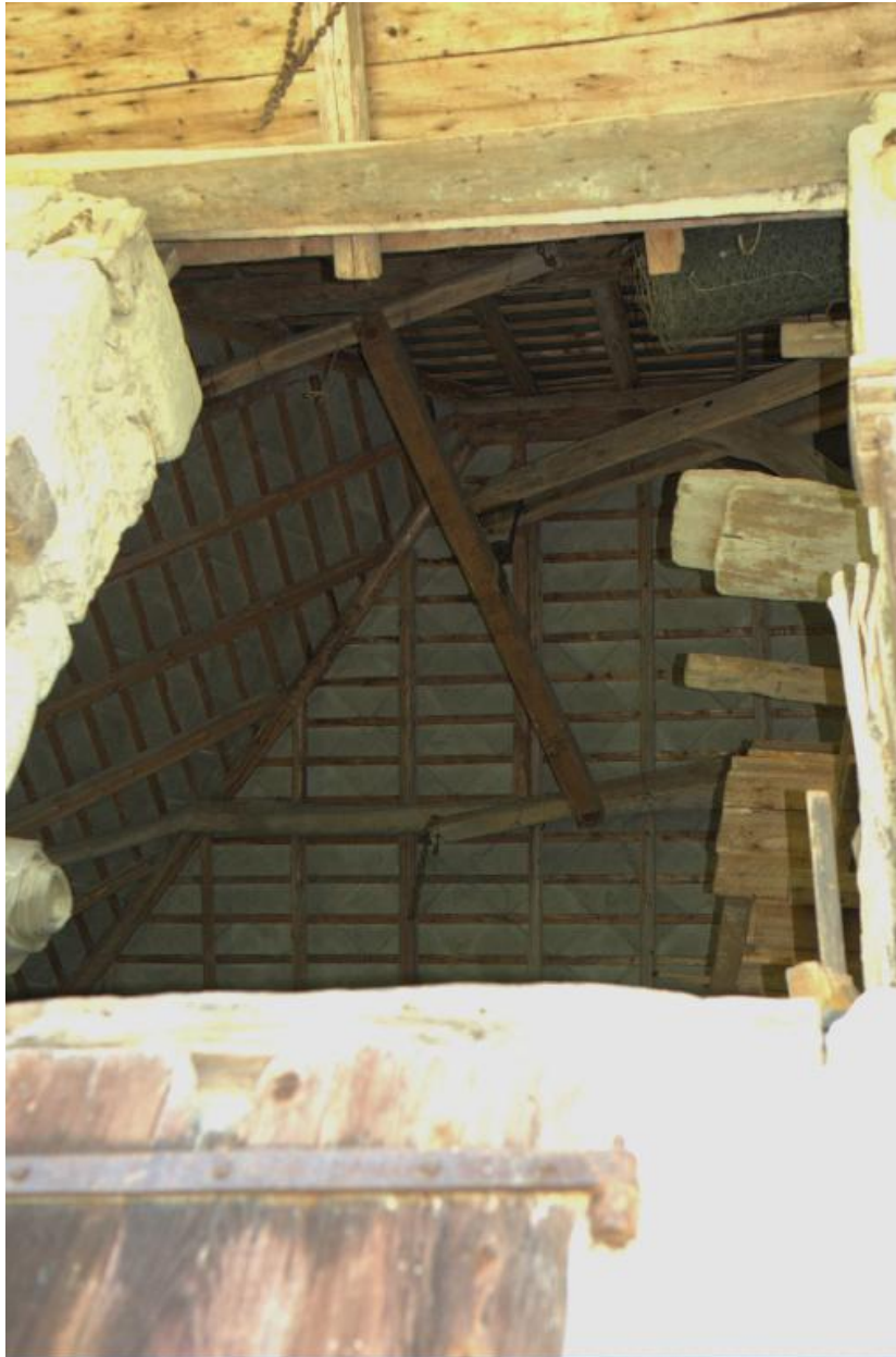
Vue partielle intérieure de la charpente, extrémité est de celle-ci.
