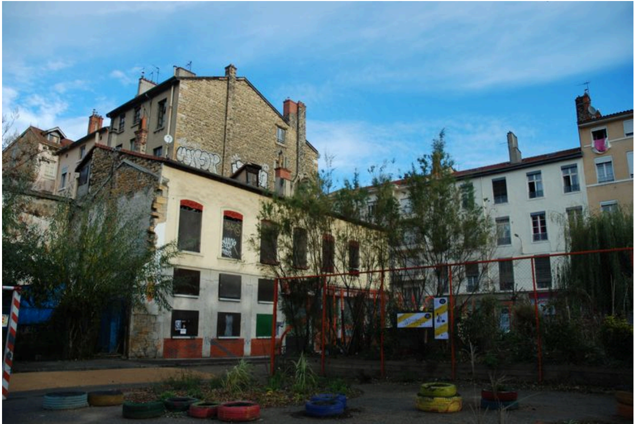
Vue générale, avant démolition (état novembre 2012)
