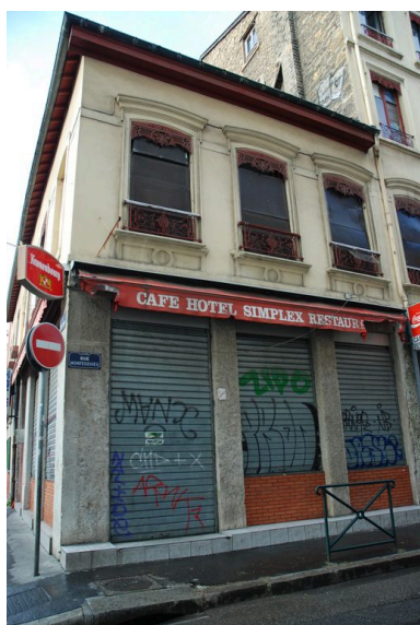
Bâtiment est, vu depuis la rue Montesquieu (état novembre 2012) Phot. Catherine Guillot IVR82_20126901139NUCA
