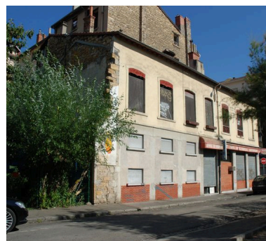
Bâtiment est, vu depuis la rue Mazagran (état août 2012) Phot. Catherine Guillot IVR82_20126901101NUCA
