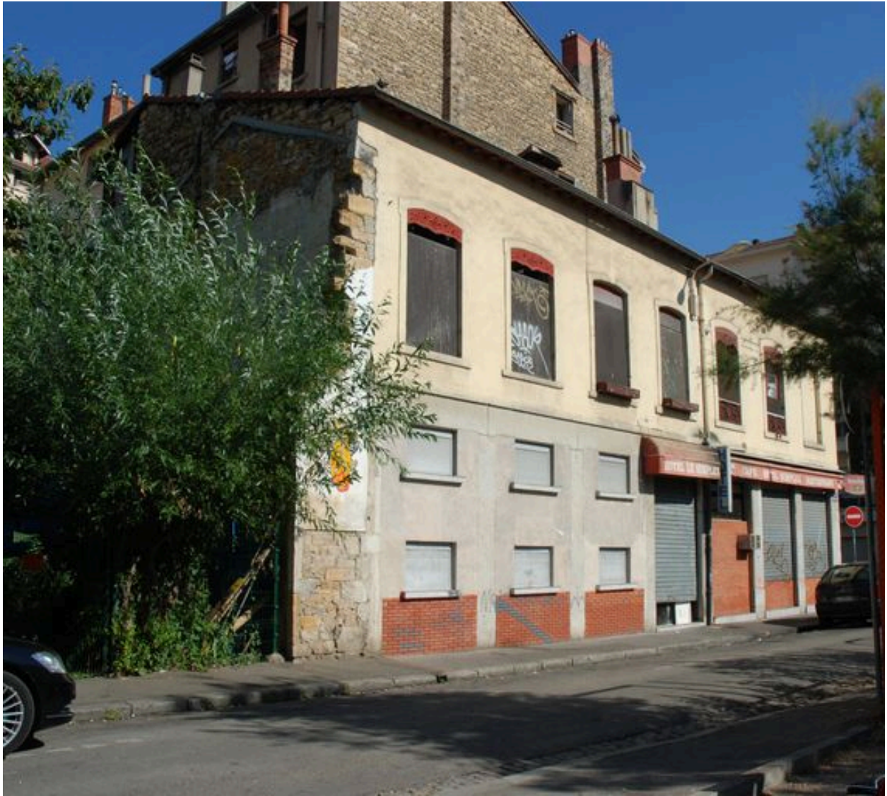
Bâtiment est, vu depuis la rue Mazagran (état août 2012)
