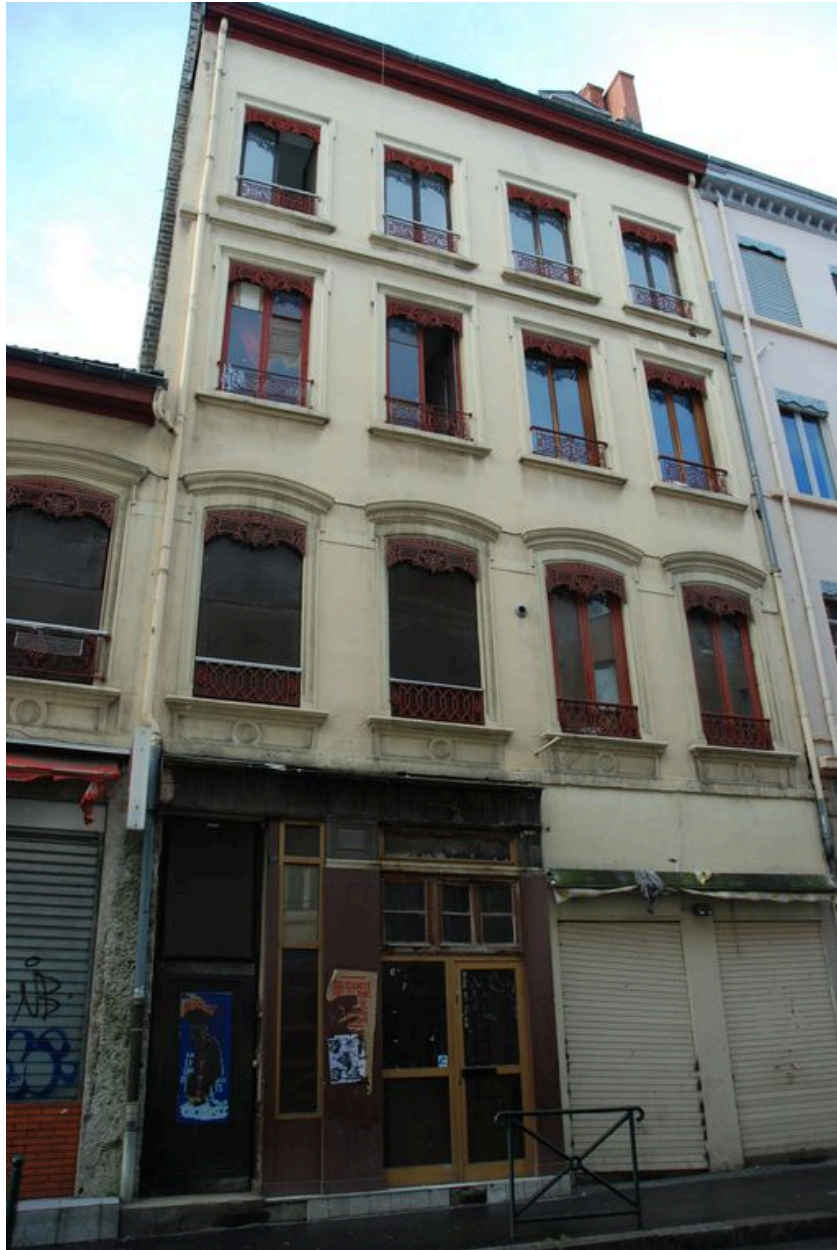
Bâtiment ouest, élévation sur la rue Montesquieu (état novembre 2012)
