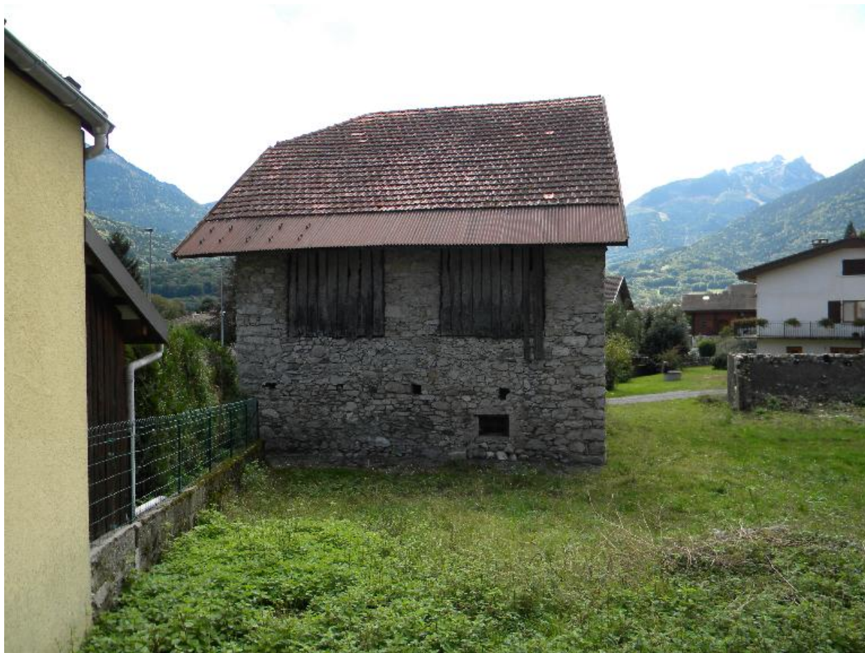
Vue de la façade nord.
