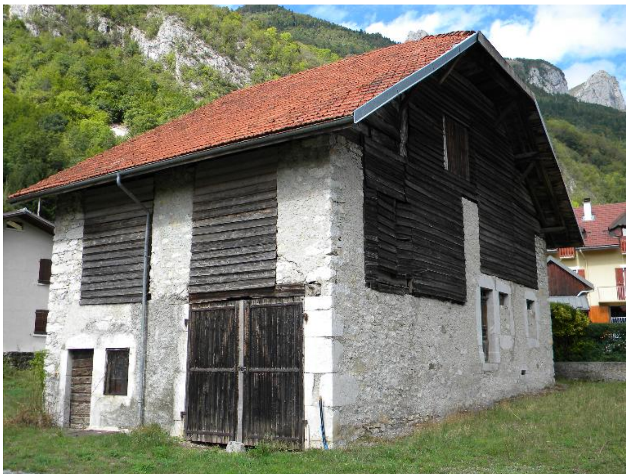
Vue de trois-quarts sud-est depuis la route départementale.
