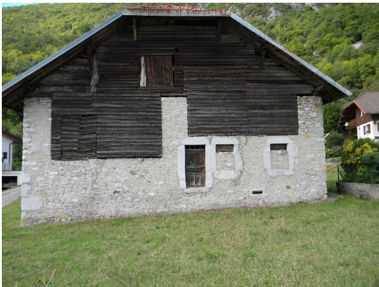
Vue de la façade principale (façade est)
