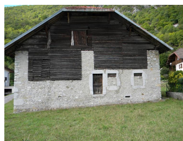
Vue de la façade principale (façade est) Phot. Jérôme Daviet IVR82_20137400948NUCA
