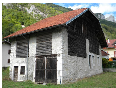
Vue de trois-quarts sud-est depuis la route départementale. Phot. Jérôme Daviet IVR82_20137400946NUCA
