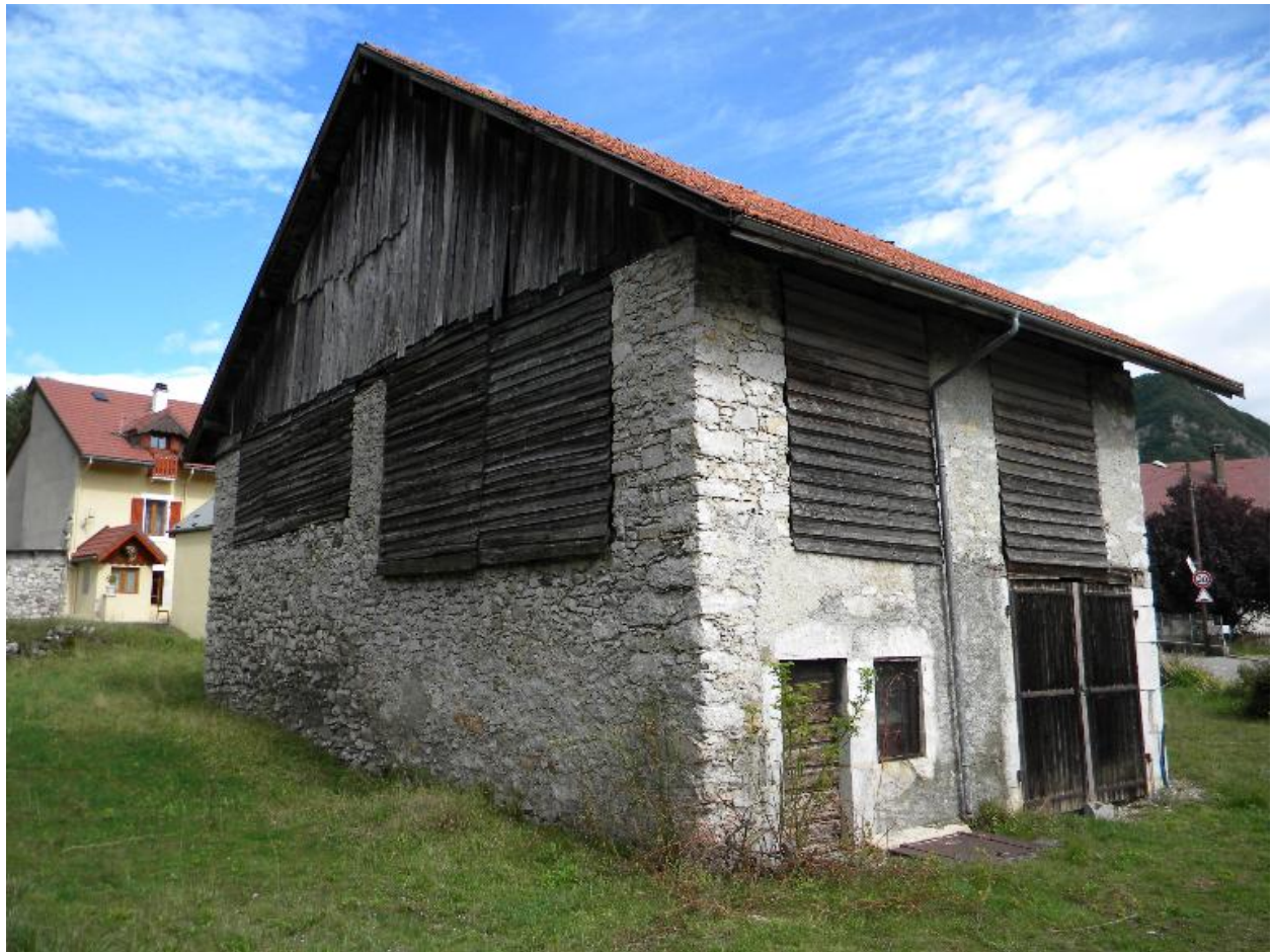
Vue de la façade arrière
