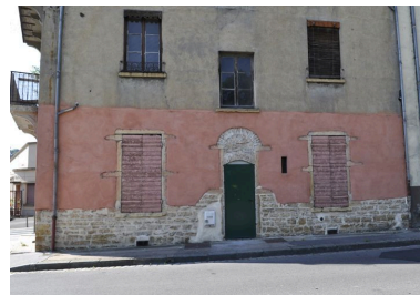
Détail de l'élévation sur la rue Joannès-Carre, état au 25 juin 2009 Phot. Catherine Guégan IVR82_20096903485NUCA
