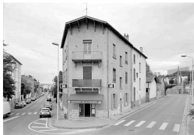
Vue générale Phot. Didier Gourbin IVR82_20056901189P
