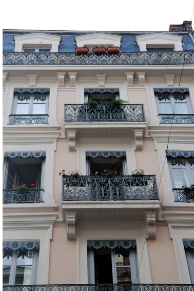
Élévation rue Gasparin : vue partielle Phot. Véronique Belle IVR82_20096904955NUCA
