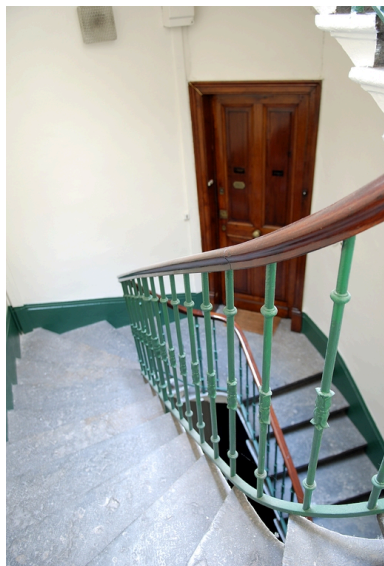
Escalier et porte palière Phot. Véronique Belle IVR82_20096904957NUCA
