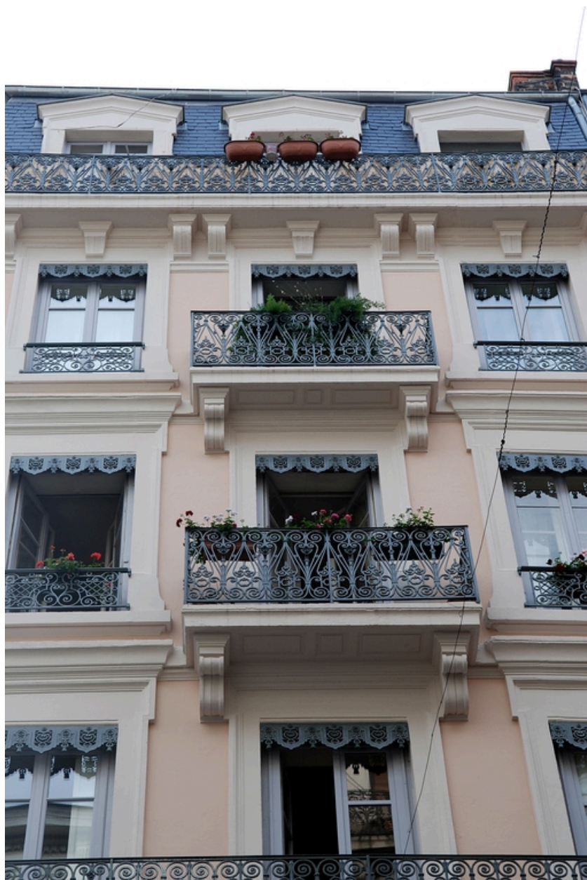
Elévation rue Gasparin : vue partielle
