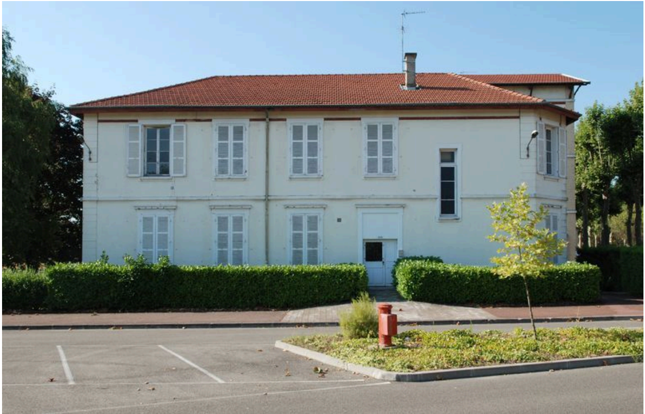
Façade principale (nord) : entrée principale à droite. La fenêtre verticale à l'extrême droite correspond à l'escalier secondaire. Un cordon de briques relie les linteaux des fenêtres de l'étage
