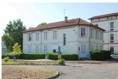
Vue générale depuis le nord-ouest Phot. Catherine Guégan IVR82_20096904571NUCA
