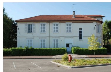
Façade principale (nord) : entrée principale à droite. La fenêtre verticale à l'extrême droite correspond à l'escalier secondaire.
