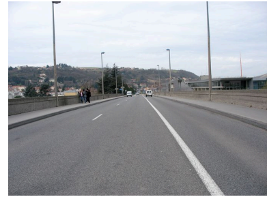
Vue sur le tablier, chaussée Phot. J. Marasi IVR82_20093800025NUCA
