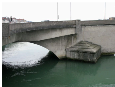
Rive gauche, extrémité du pont, face amont
