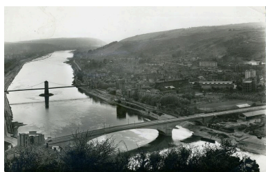
[Nouveau pont sur le Rhône et passerelle en arrière-plan, de l'amont] / Glatigny édit., [avant 1950]. 1 impr. photoméc. (carte postale) : n. et b. (MdFR. Collection Rondeau, CP RON 1057) Phot. Maison du Fleuve Rhône IVR82_20093800036NUCAB
