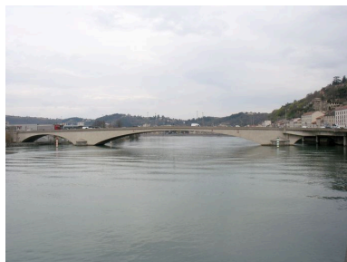
Vue générale du pont, côté aval
