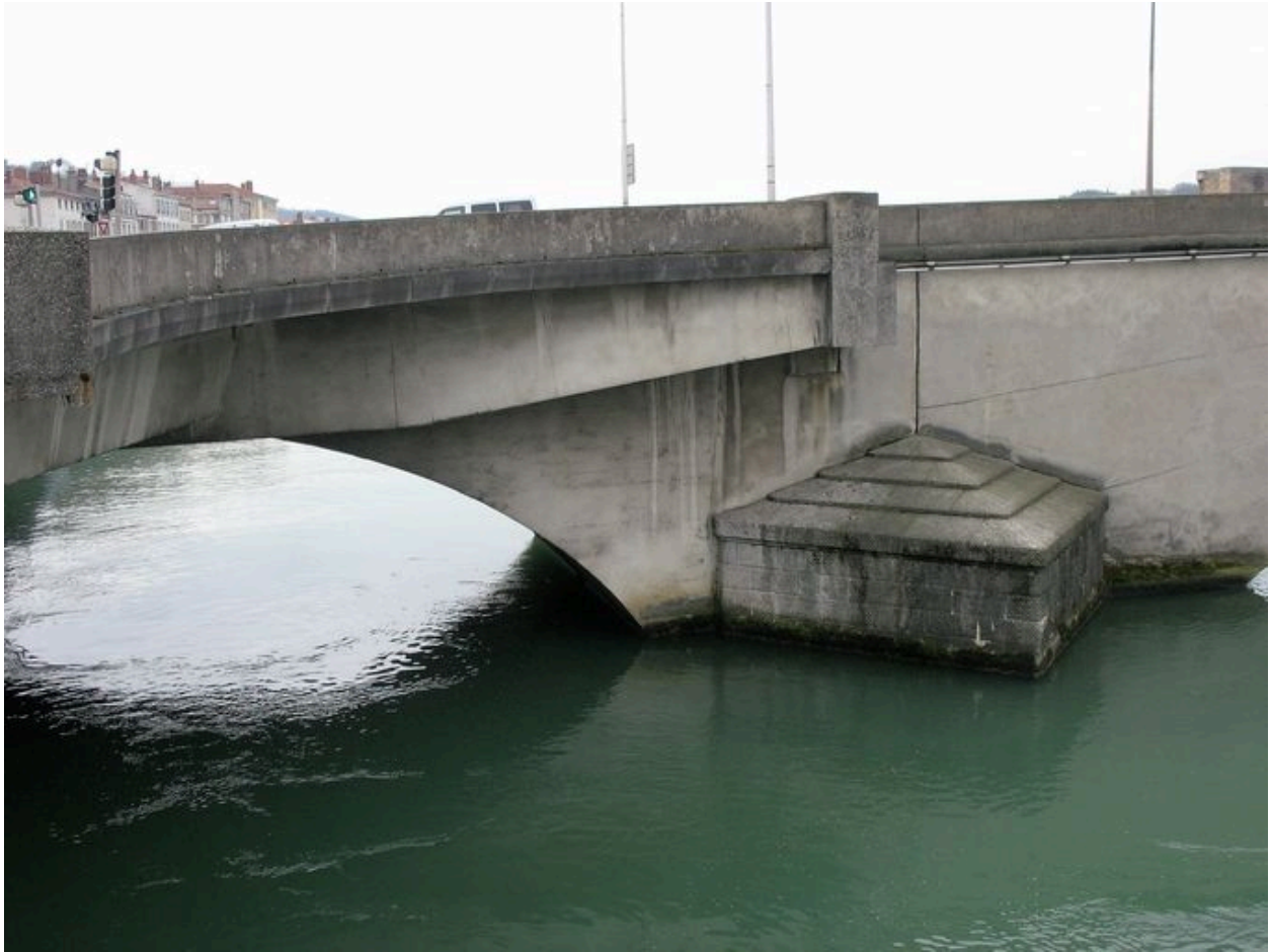
Rive gauche, extrémité du pont, face amont
