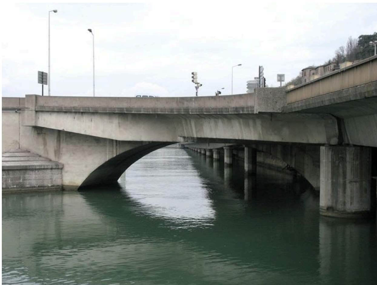
Travée de rive gauche, face aval
