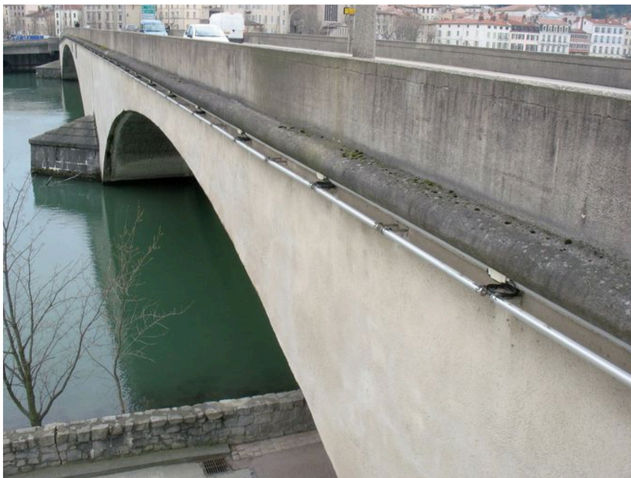
Vue de la face amont (depuis la rive droite)
