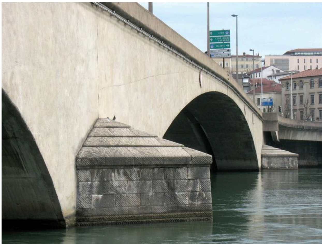
Vue partielle, face aval
