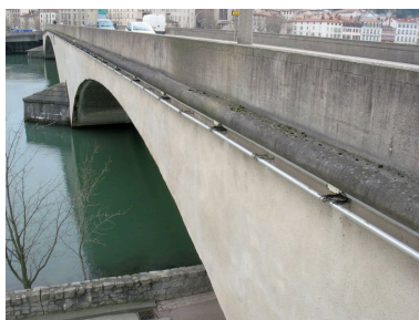
Vue de la face amont (depuis la rive droite)
