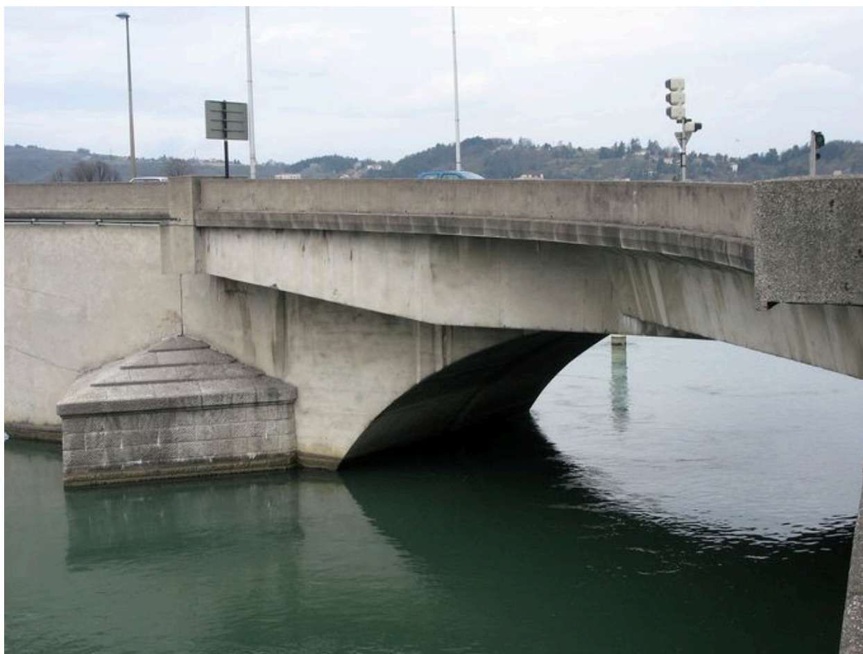
Rive gauche, extrémité du pont, face aval
