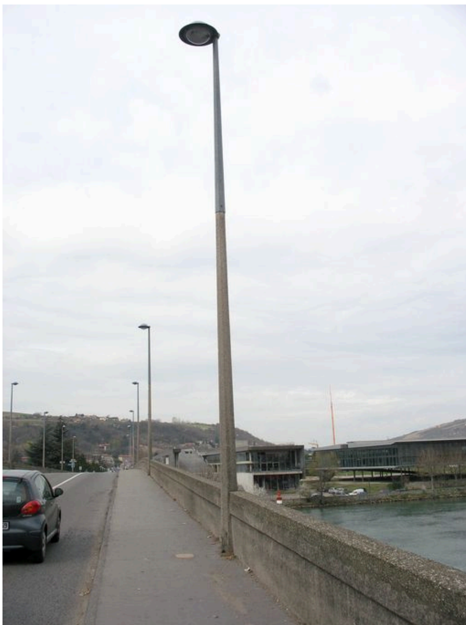
Sur le tablier : trottoir et lampadaires
