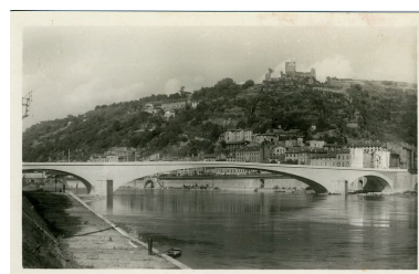
[Le nouveau pont, face aval, de la rive droite, et vue sur la Batie] / C.A.P. édit. Paris : C.A.P., [avant 1970]. 1 impr. photoméc. (carte postale) : n. et b. (MdFR. Collection Rondeau, CP RON 1055) Phot. Maison du Fleuve Rhône IVR82_20093800040NUCAB
