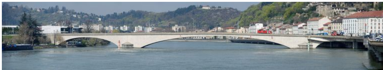
Vue panoramique, côté aval
