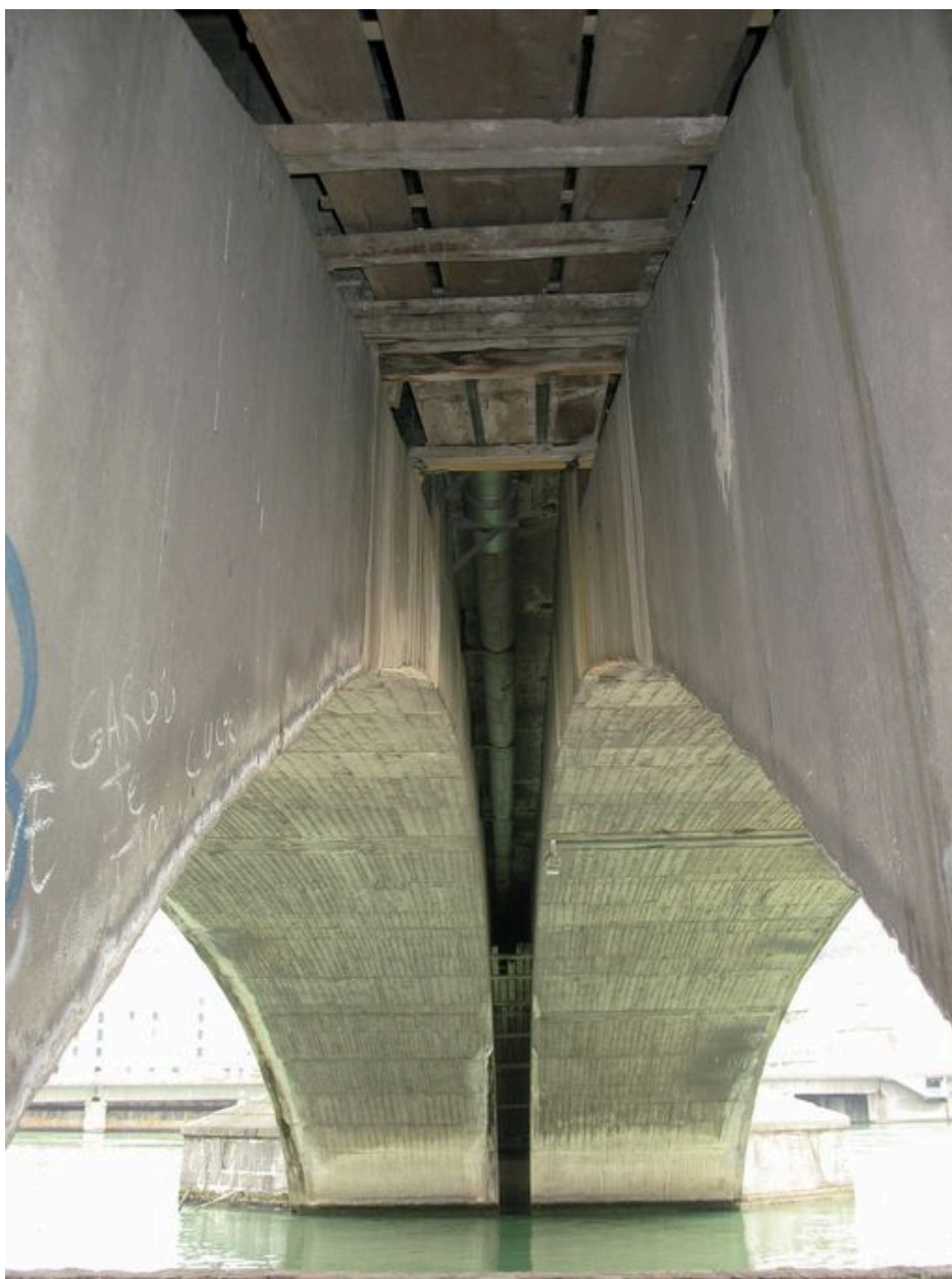
Travée de rive droite : vue du dessous du tablier
