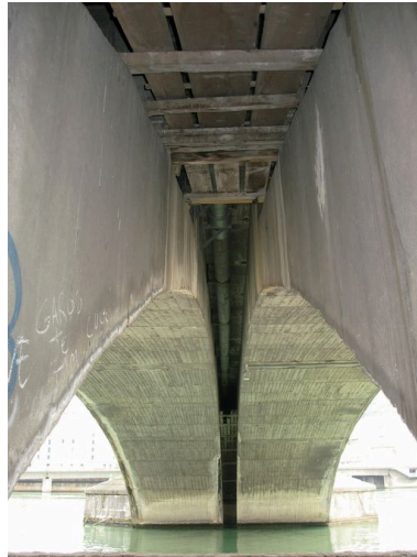
Travée de rive droite : vue du dessous du tablier Phot. J. Marasi IVR82_20093800024NUCA
