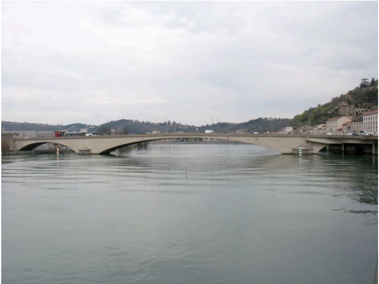
Vue générale du pont, côté aval
