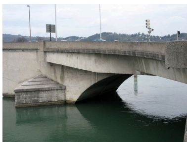
Rive gauche, extrémité du pont, face aval
