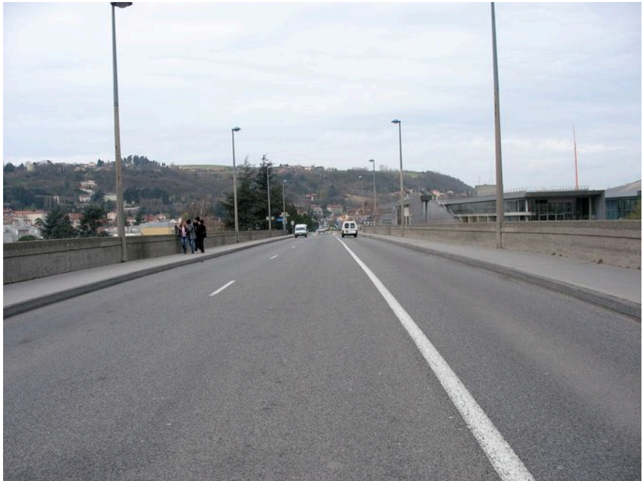
Vue sur le tablier, chaussée
