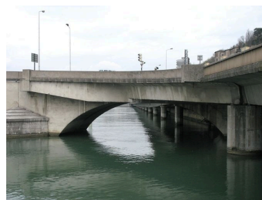
Travée de rive gauche, face aval
